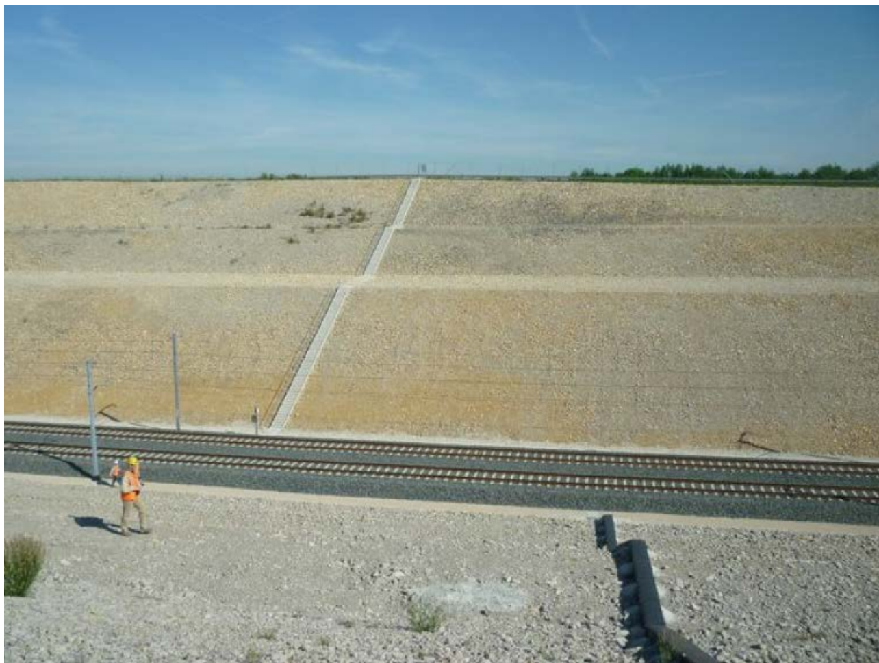
Figure 2.3 - Déblai LGV Rhin-Rhône Instrumentation par inclinométrie, piézométrie et CPI (crédit photographique : SNCF RESEAU).
