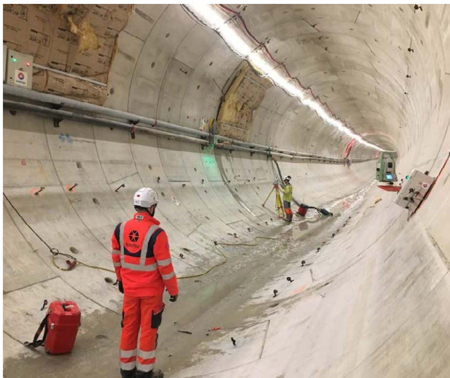
Figure 2.10 –Monitoring tunnel urbain par topométrie (crédit photographique : SIXENSE).
