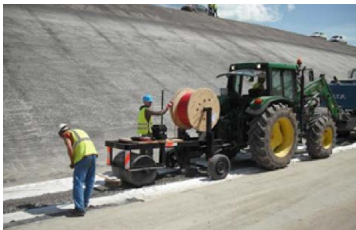
Figure 6.13 - Pose fibre optique (crédit photographique : EDF)
