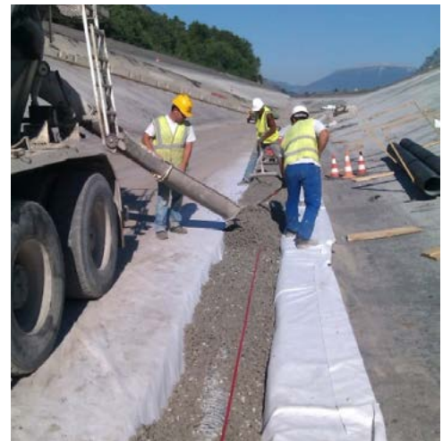
Pose de la fibre optique dans les tranchées drainantes
