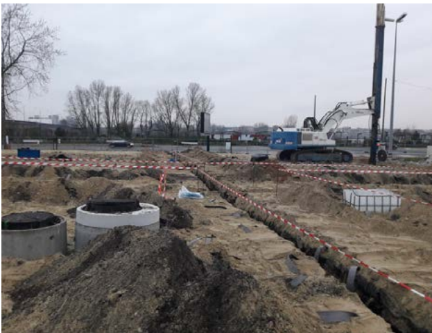
Réalisation des tranchées pour pose des profilomètres
