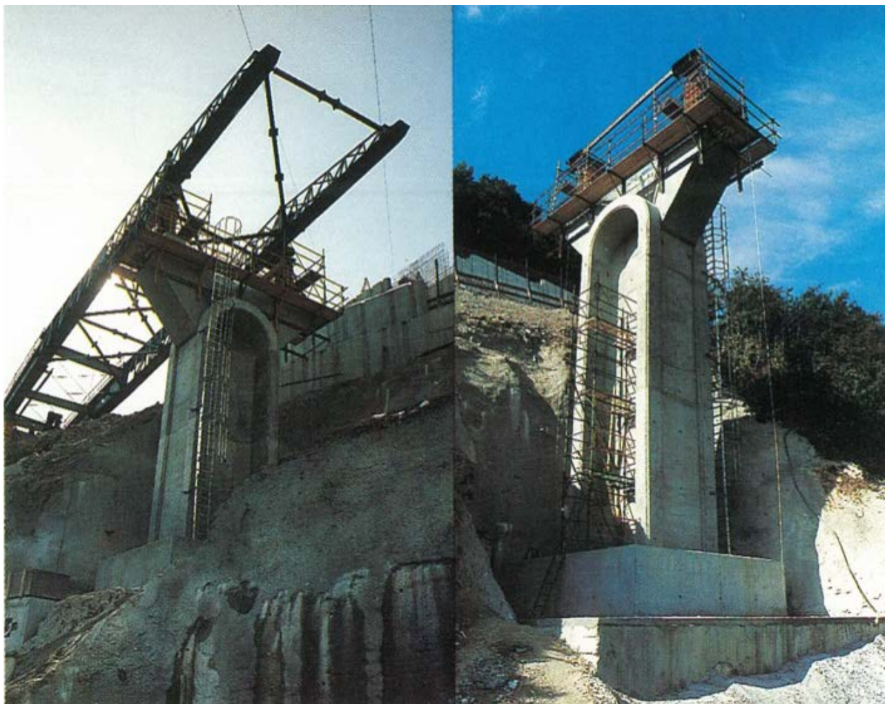
Figure 2.12 – Fondations superficielles avec renforcement par clouage – instrumentation pour suivi des déformations et efforts dans les renforcements (crédit photographique : EGIS).
