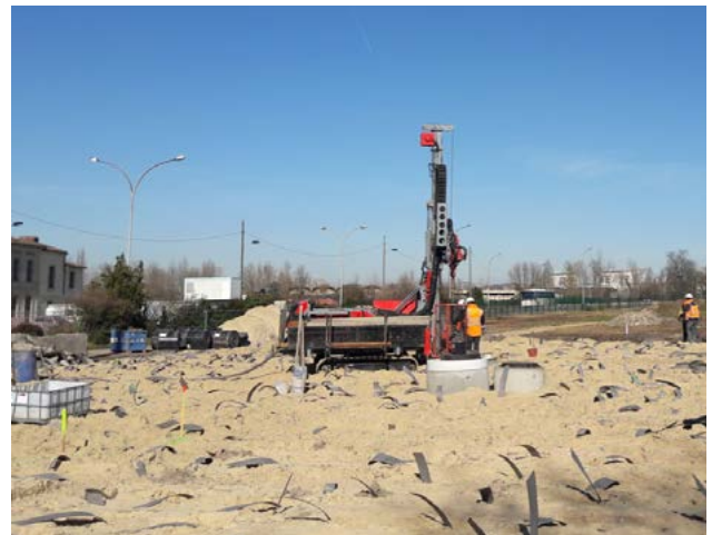
Forage pour pose de CPI
