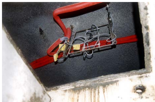
Cordes vibrantes (déformations) noyées dans le béton
