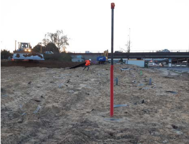
Pige tassométrique en cours de montée du remblai
