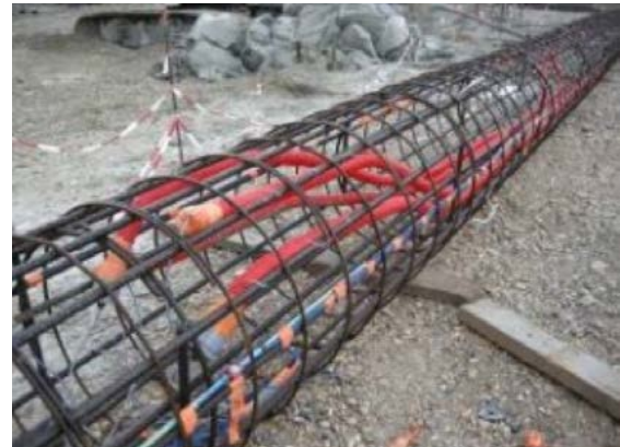
Instrumentation des cages d'armature pour mesurer la déformation
