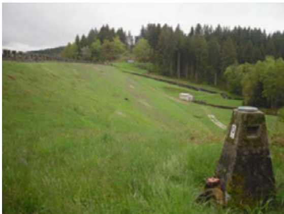
Figure 6.11 - Pilier pour mesure planimétrique (crédit photographique : EDF)
