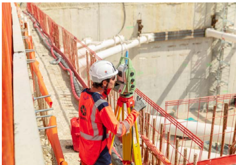
Figure 2.6 - Monitoring fouille urbaine, paroi moulée butonnée (crédit photographique : SIXENSE)
