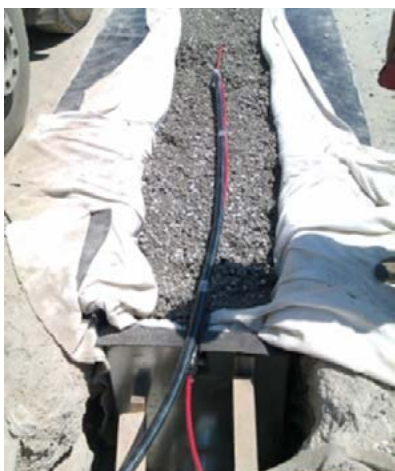
Figure 6.13 - Pose fibre optique (crédit photographique : EDF)
