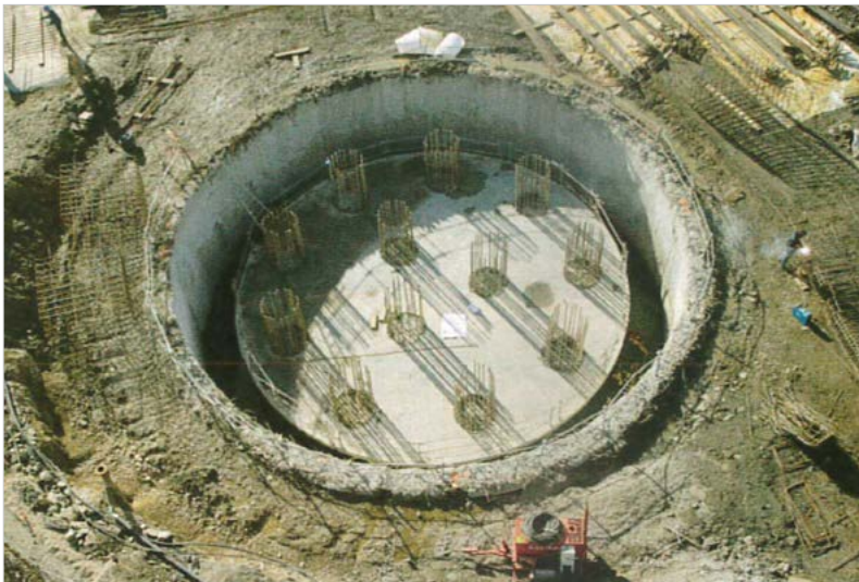
Têtes de pieux avec protection par enceinte circulaire
