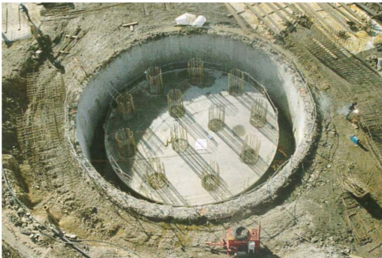
Figure 2.13 – Fondations profondes – Viaduc de Monestier – Instrumentation mesurant l'influence d'un glissement de terrain sur les pieux (crédit photographique : EGIS).
