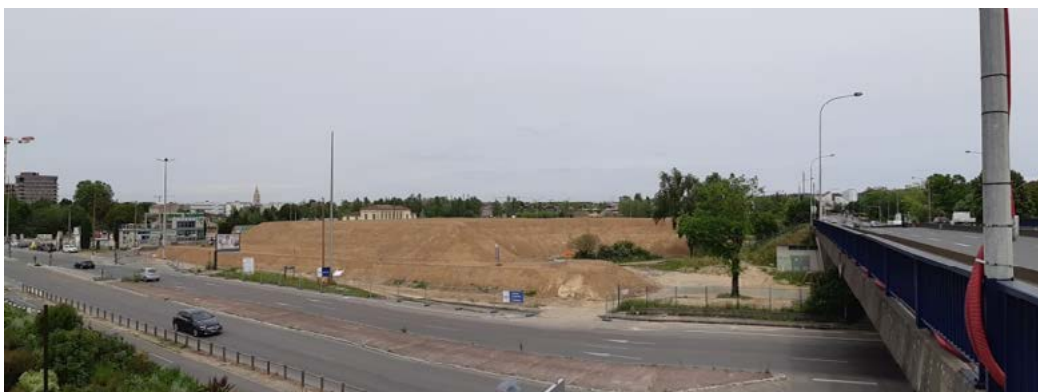
Figure 2.1 - Remblai de préchargement – Bordeaux (crédit photographique : GEOTEC).
