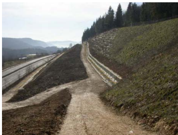
Vue d'ensemble du déblai D23 après travaux de confortement
