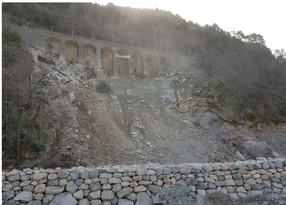
Figure 2.8 - Versant du mur à arcature de Fontan - ligne Coni-Vintimille (travaux suite à la tempête ALEX – 2020/2021) (crédit photographique : SNCF RESEAU).
