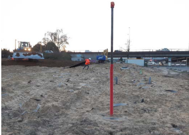
Figure 6.4 - Pige topographique (crédit photographique : GEOTEC)
