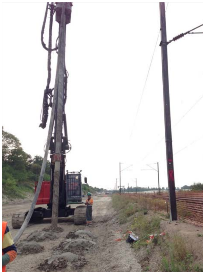
Figure 2.5 – Renforcement de sol par CMC – Remblai ferroviaire – Instrumentation pour suivi des tassements en construction et en service (crédit photographique : EGIS)
