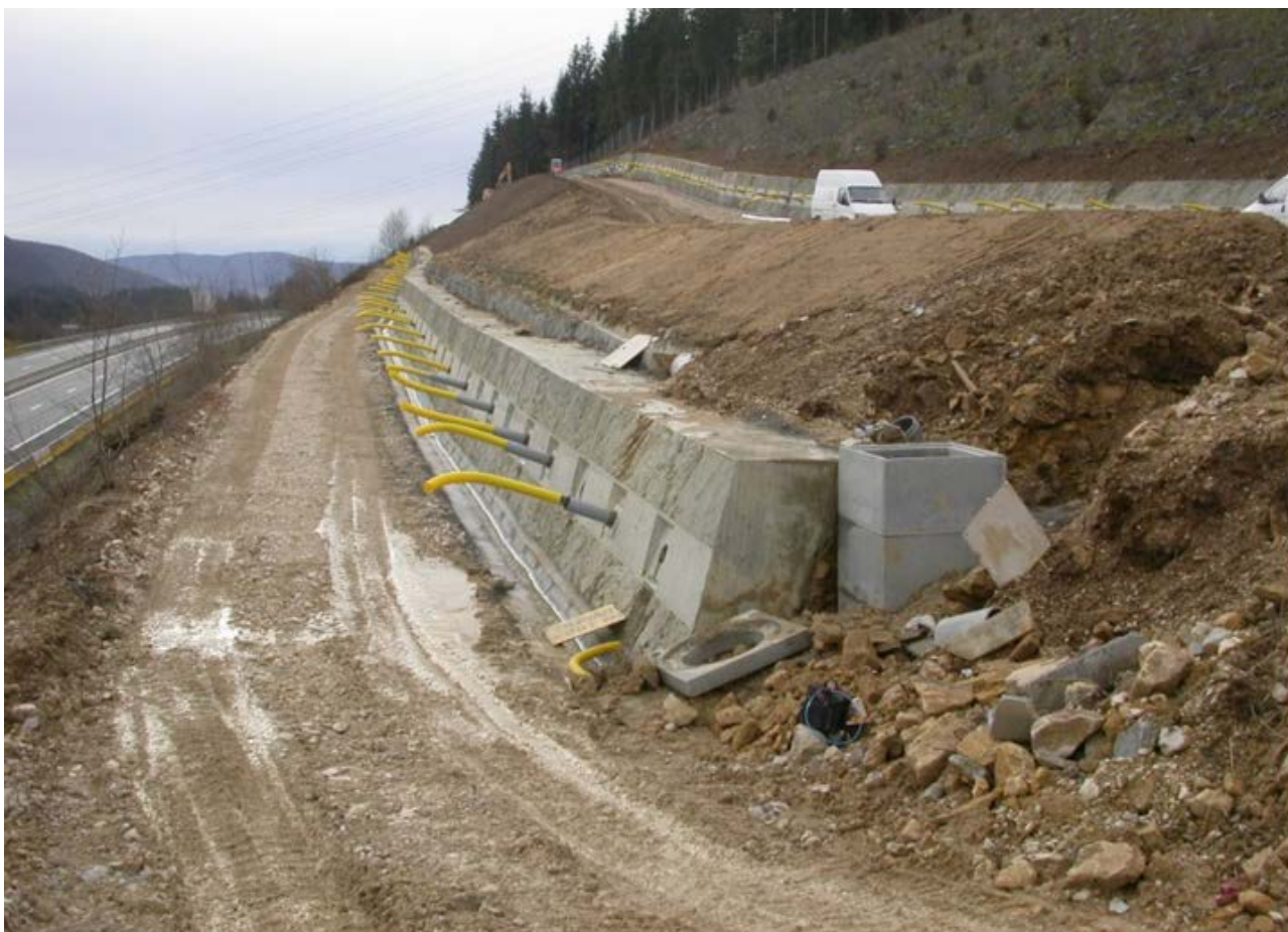
Figure 2.9 – Renforcement d'un glissement de terrain – Méthode Observationnelle – Autoroute A404 (crédit photographique : EGIS).
