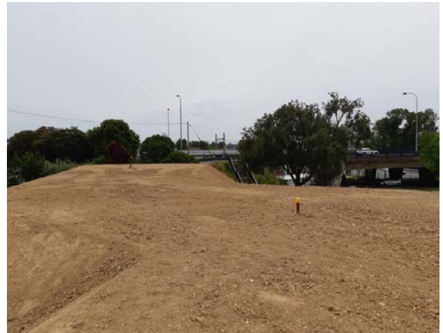
Pige tassométrique en fin de montée du remblai
