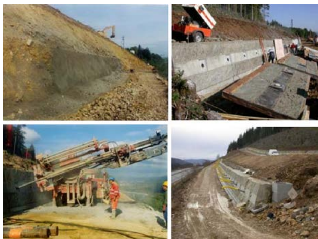
Photographies en cours de travaux
