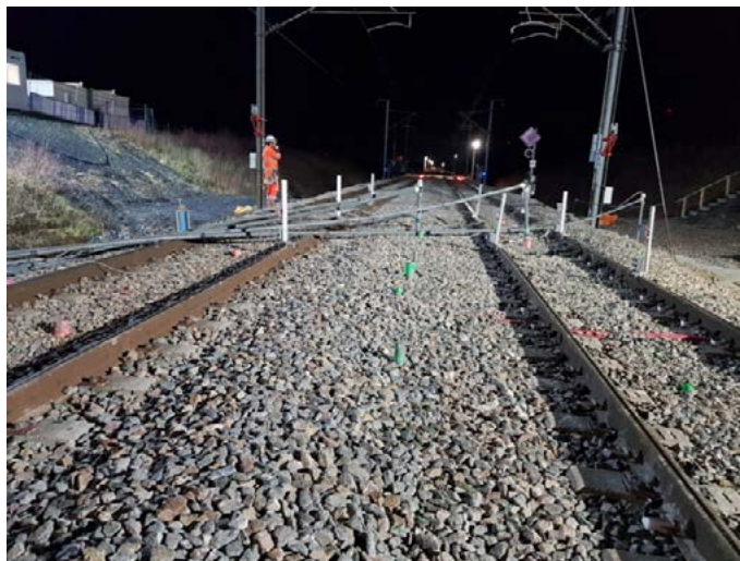
Figure 2.4 - Injection de sol - déblai km 87 – LGV Nord Europe – Travaux à la suite de fontis (2020) (crédit photographique : SNCF RESEAU).
