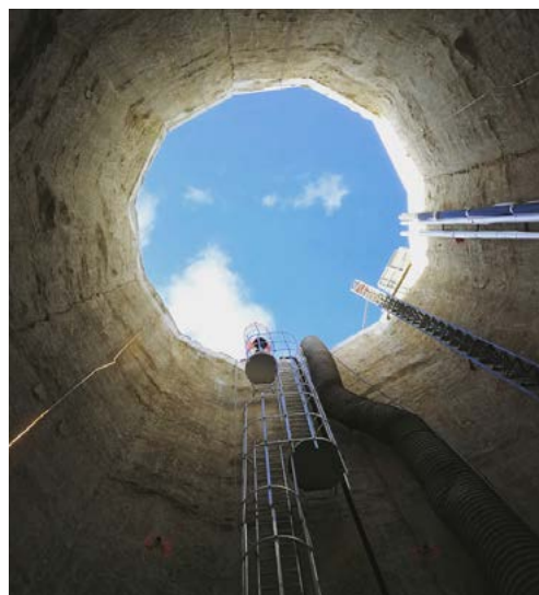
Figure 2.7 – Puits instrumenté à Aulnay-sous-Bois avec rétro analyse (crédit photographique : EGIS)
