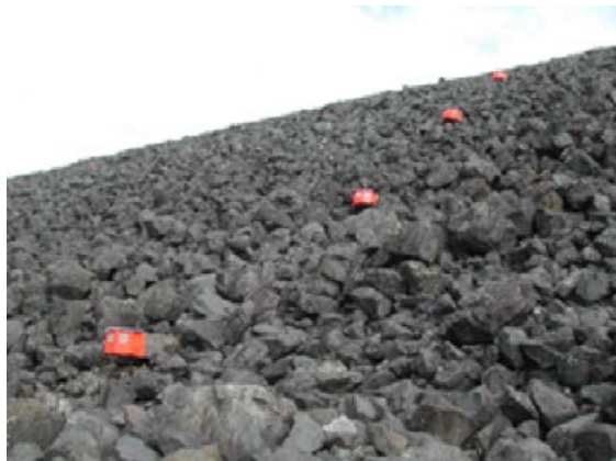
Figure 6.12 - Cocardes planimétriques en parement aval (crédit photographique : EDF)
