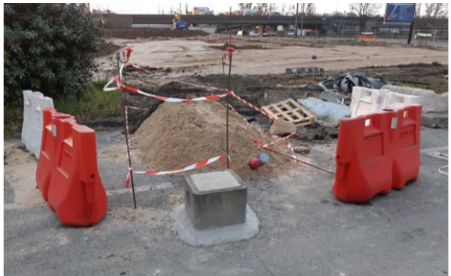
Figure 6.5 - Tranchée et extrémité d'un profilomètre (crédit photographique : GEOTEC)
