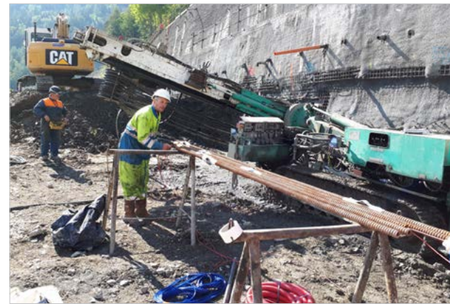
Photo de machine de forage et clou extensométrique instrumenté
