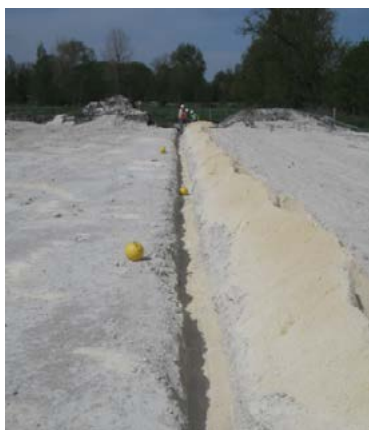
Figure 6.6 - Tranchée et extrémité de boules tassométriques (crédit photographique : GEOTEC)
