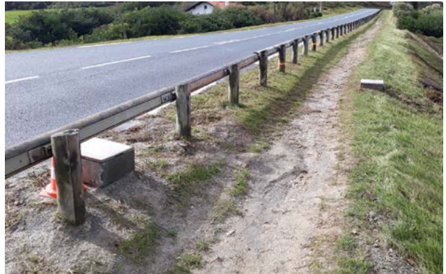
Regards d'installation des logger en tête de falaise
