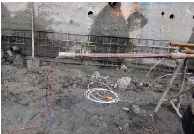
Photo de clou Extensométrique instrumenté
