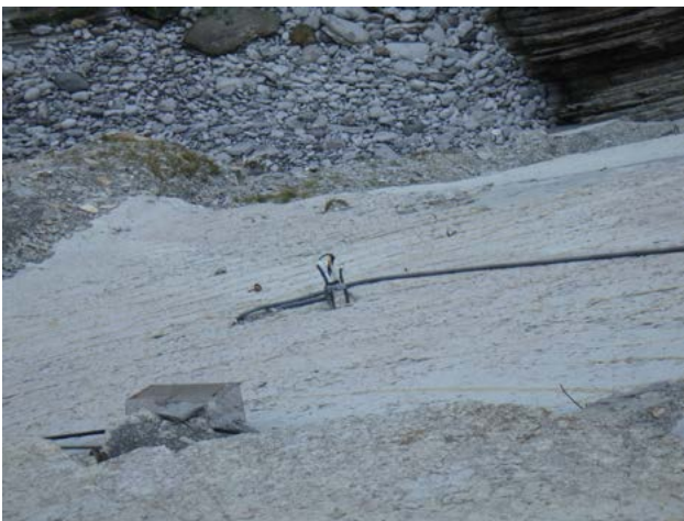
Positionnement d'un extensomètre et d'un inclinomètre horizontal sur la falaise
