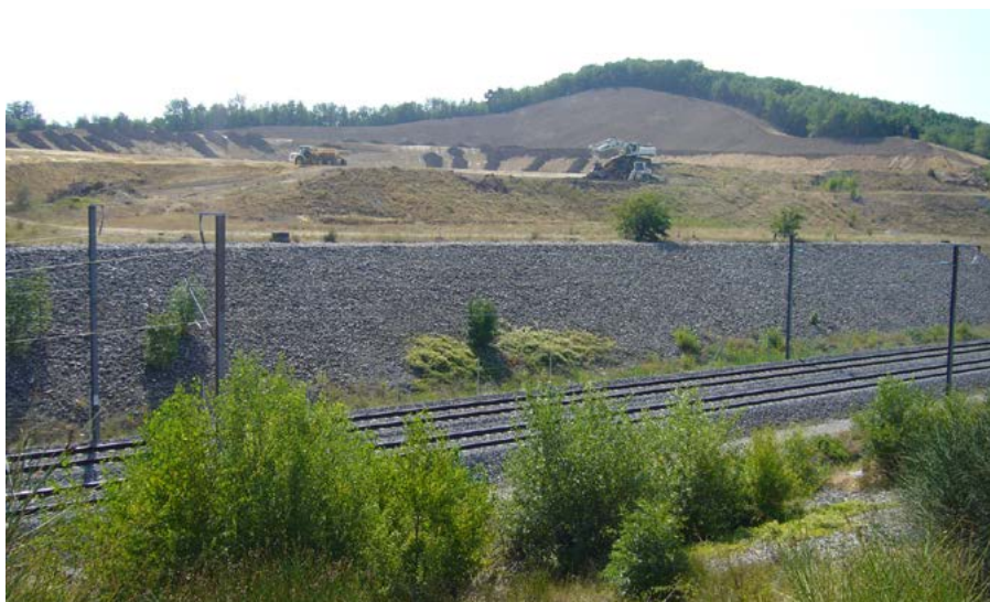
Situation en cours de terrassement en 2015
