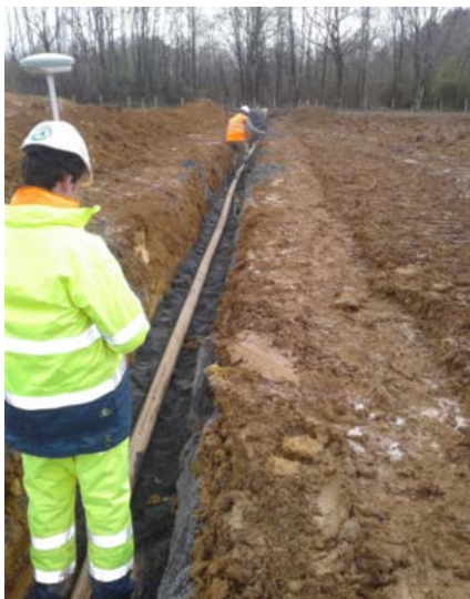
Figure 6.5 - Tranchée et extrémité d'un profilomètre (crédit photographique : GEOTEC)
