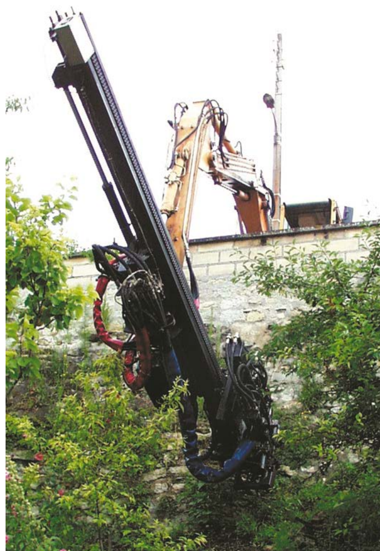
Photo 7.3 : foreuse montée en rétro (© Spie Fondations)
