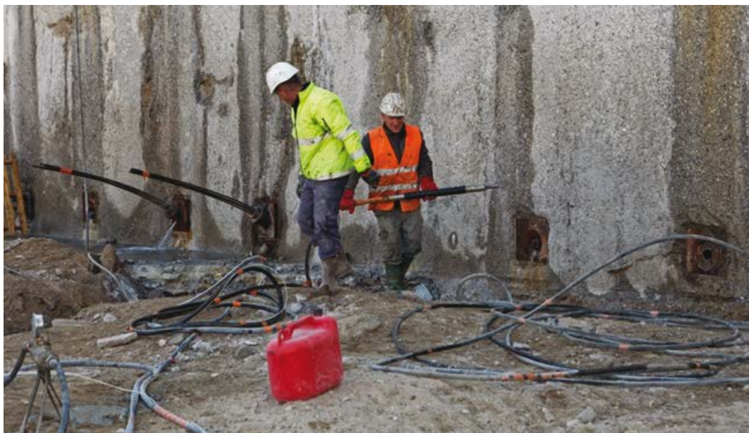
Photo 7.12 : mise en place de l'obturateur (© Spie Fondations)
