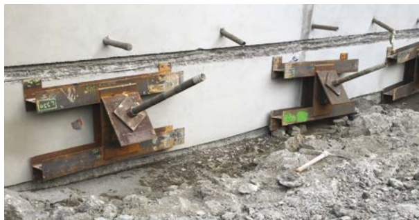
Photo 3.3 : exemple de système d'appui (© Franki Fondation)
