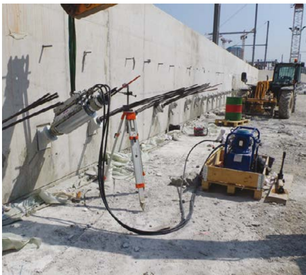
Photo 8.4 : essai de contrôle (© Soletanche Bachy)
