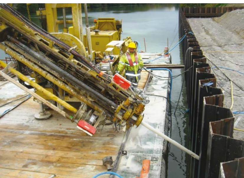
Photo 7.4 : foreuse installée sur une barge (© Sefi Intrafor)
