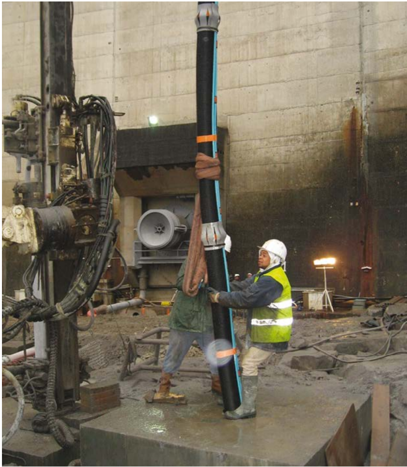
Photo 4.3 : centreurs (gris) et tubes à manchettes (bleu) (© Spie Fondations)
