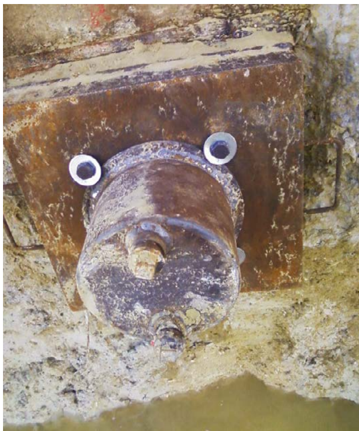
Photo 3.1 : exemple de capot de protection (© Sefi Intrafor)
