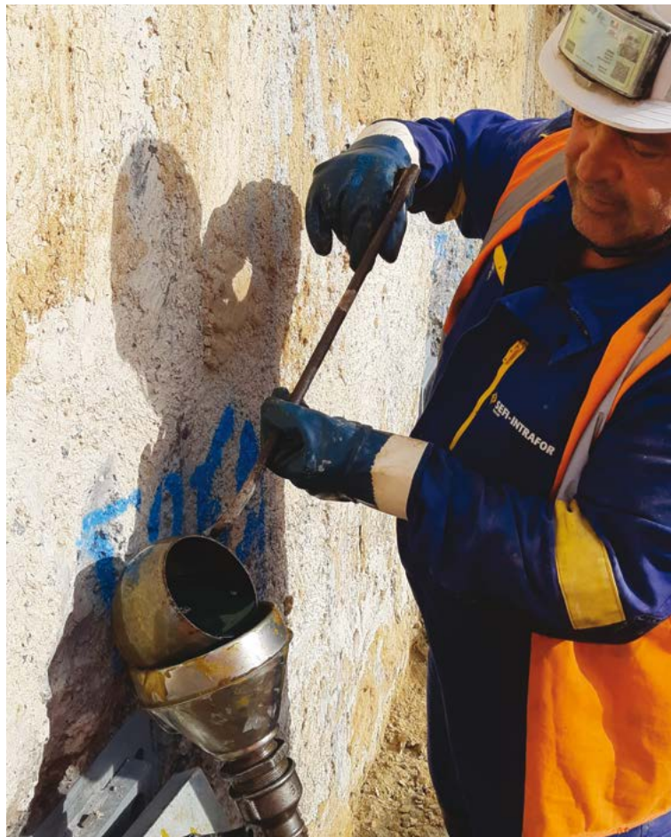
Photo 6.5 : remplissage du tube-trompette de produit anti-corrosion (cire)
