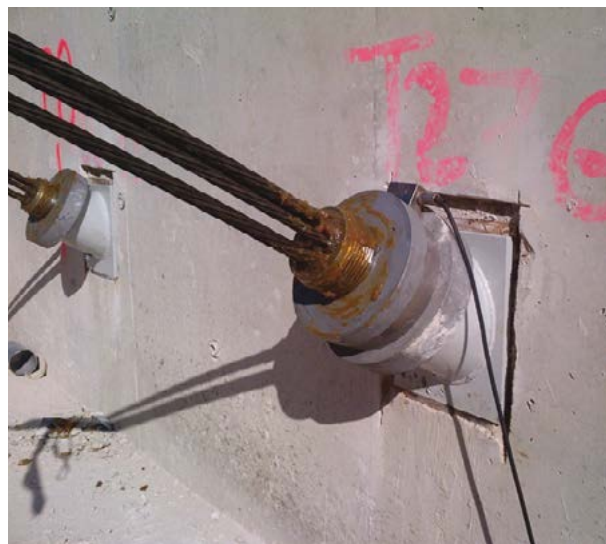
Photo 8.5 : tête de tirant instrumentée (© Freyssinet)
