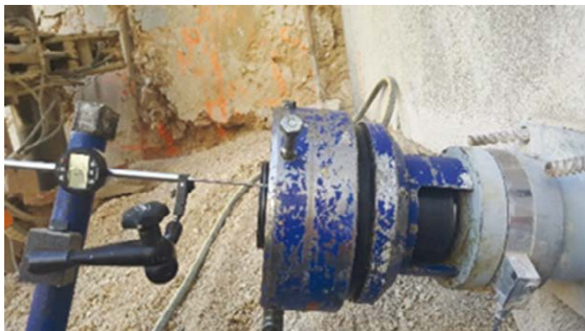
Photo 8.10 : pesage d'un tirant avec tête instrumentée (© Freyssinet)
