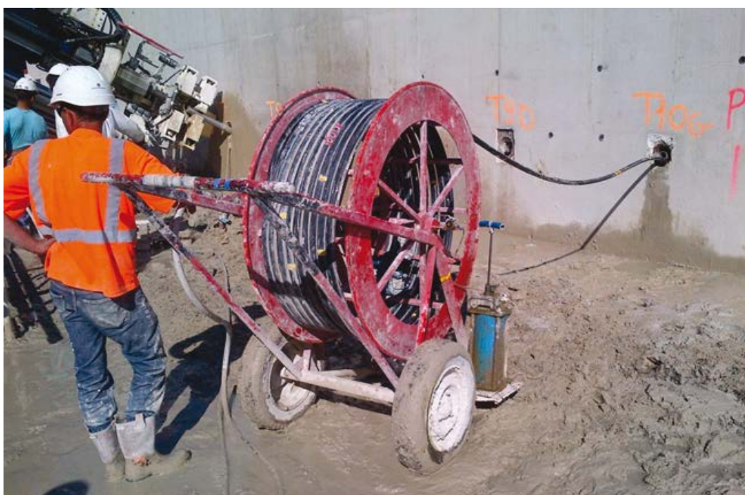
Photo 7.13 : injection de type IRS (©Freyssinet)
