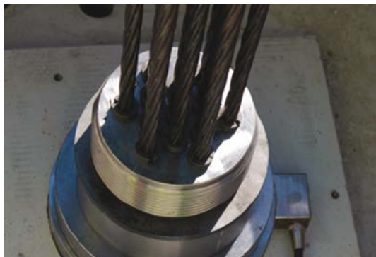
Photo 3.4a : Tête d'ancrage réglable (© Freyssinet)
