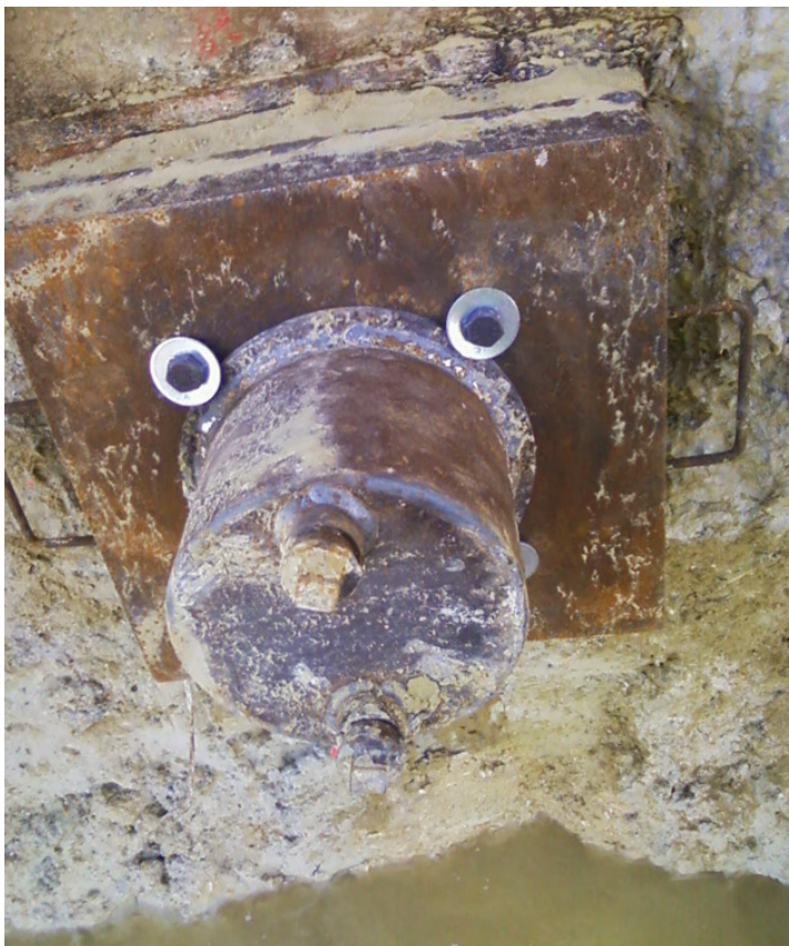
Photo 3.1 : exemple de capot de protection (© Sefi Intrafor)
