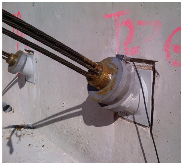
Photo 8.5 : tête de tirant instrumentée (© Freyssinet)
