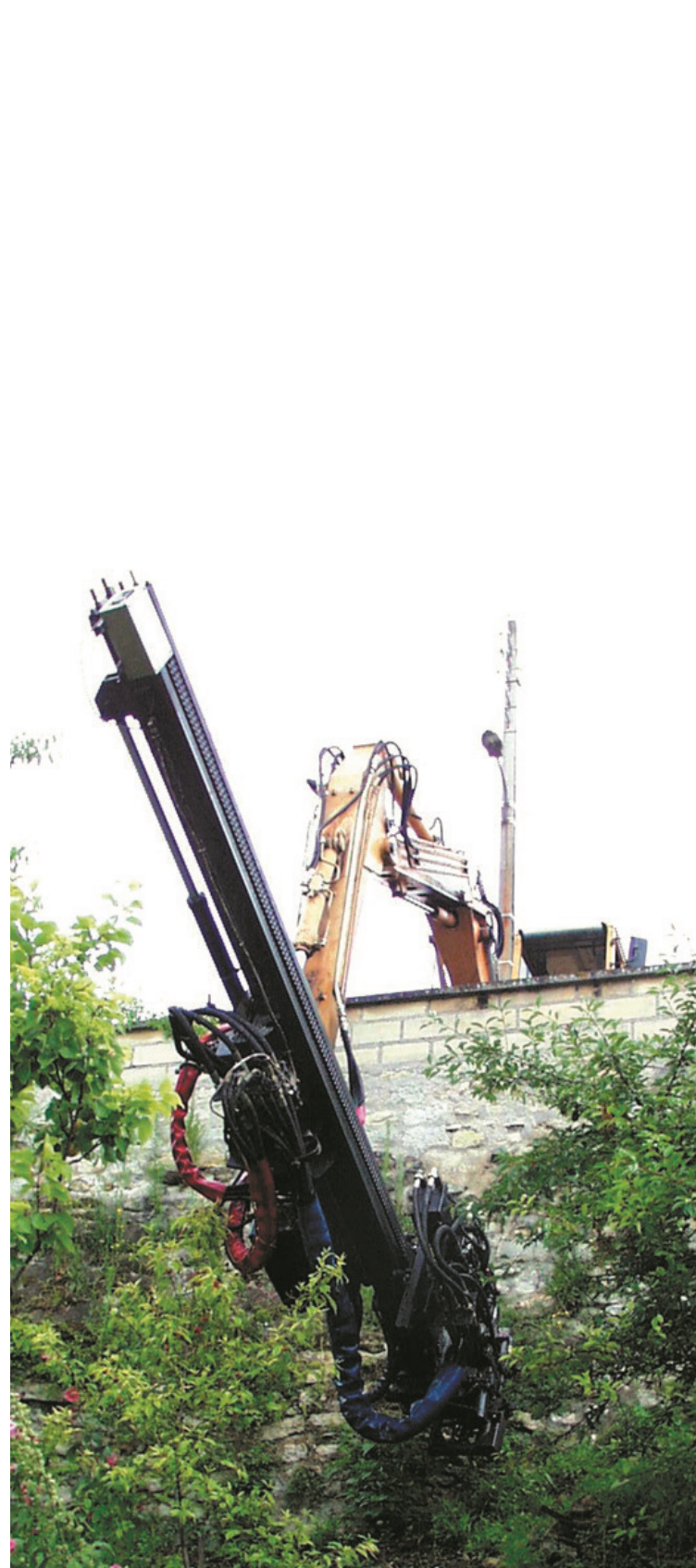
Photo 7.3 : foreuse montée en rétro (© Spie Fondations)
