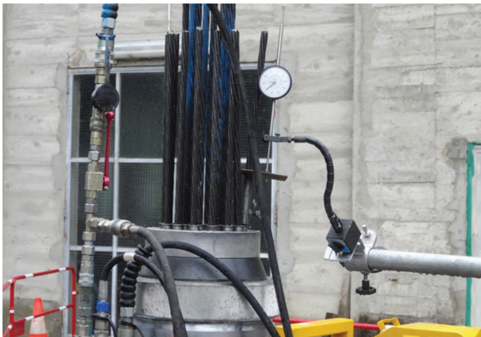
Photo 7.15 : Mesure de l'allongement par un comparateur (© Alexis Piron-EDF)
