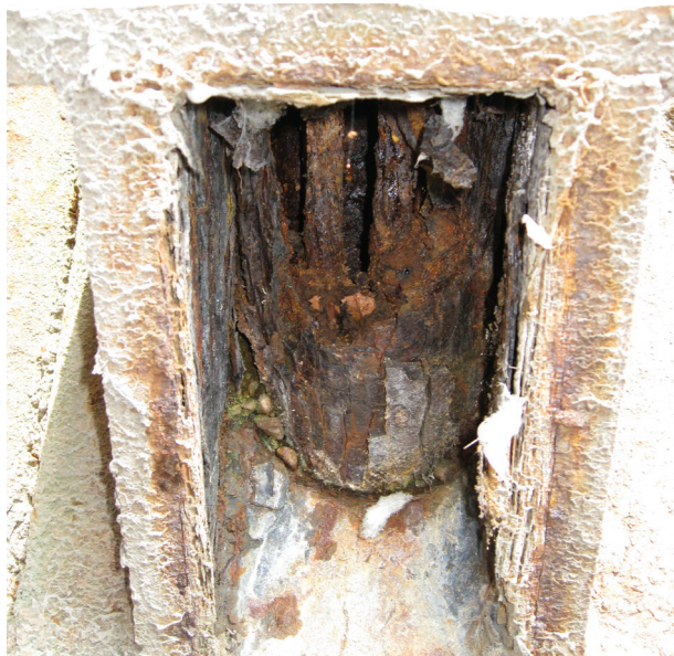
Photo 6.1 : illustration de l'effet d'un défaut de protection au niveau d'une tête d'ancrage (©SMG)
