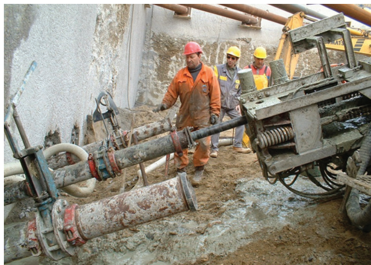
Photo 7.6 : forage sous sas (© Sefi Intrafor)
