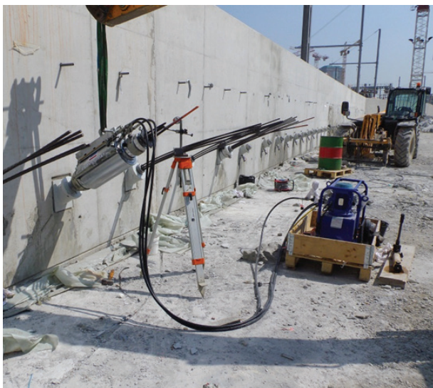
Photo 8.4 : essai de contrôle (© Soletanche Bachy)
