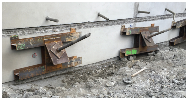
Photo 3.3 : exemple de système d'appui (© Franki Fondation)
