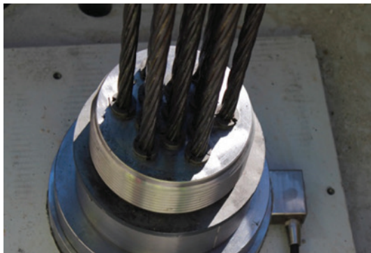
Photo 3.4a : Tête d'ancrage réglable (© Freyssinet)
