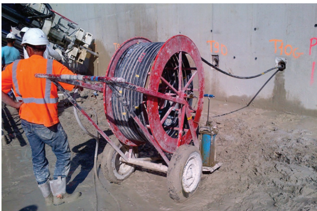
Photo 7.13 : injection de type IRS (©Freyssinet)
