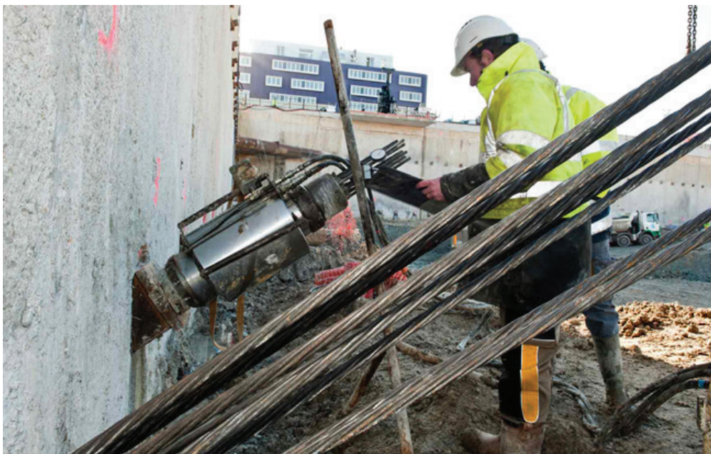
Photo 7.14 : mise en service du tirant (© Sefi Intrafor)
