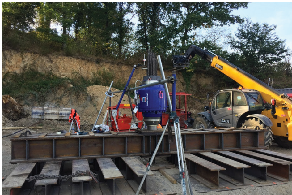
Photo I.1 : Structure d'appui d'essai de chargement (© Soletanche Bachy)
