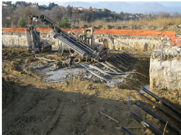
Photo 7.7 : forage avec tubes prolongateurs (© Spie Fondations)
