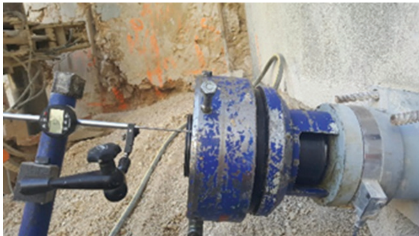
Photo 8.10 : pesage d'un tirant avec tête instrumentée (© Freyssinet)
