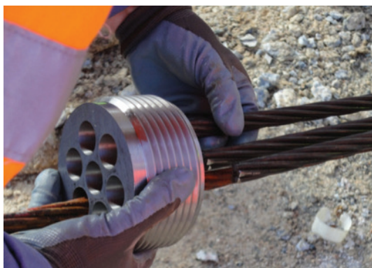
Photo 3.4b : Bloc d'ancrage retensionnable (© Freyssinet)
