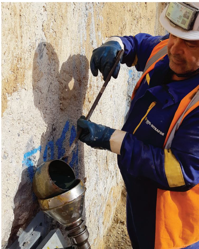
Photo 6.5 : remplissage du tube-trompette de produit anti-corrosion (cire)
