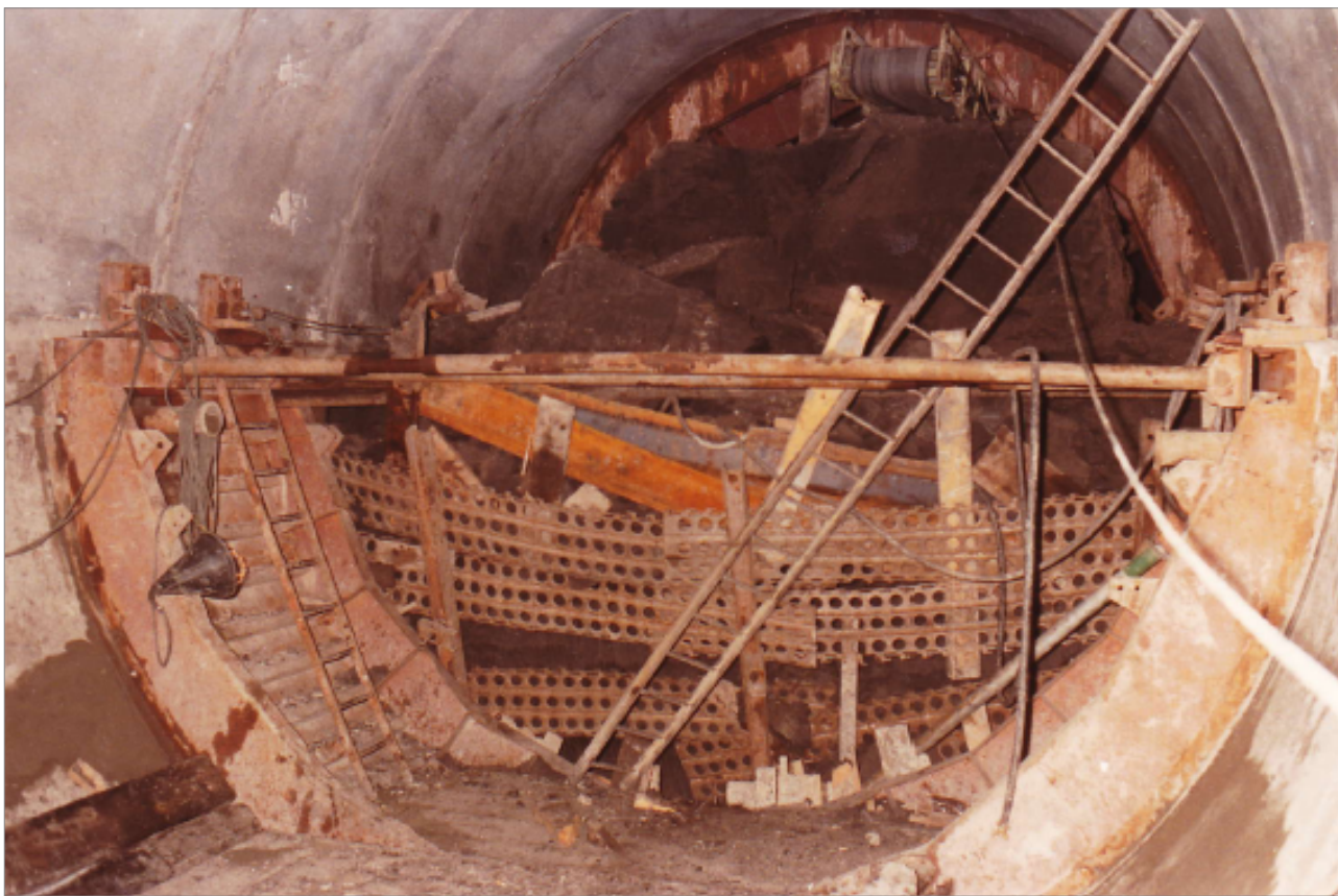
Photographie 15. Soulèvement en galerie creusée dans l'Argile du Gault, dû à la sous-pression de la nappe de l'Albien / EDF
