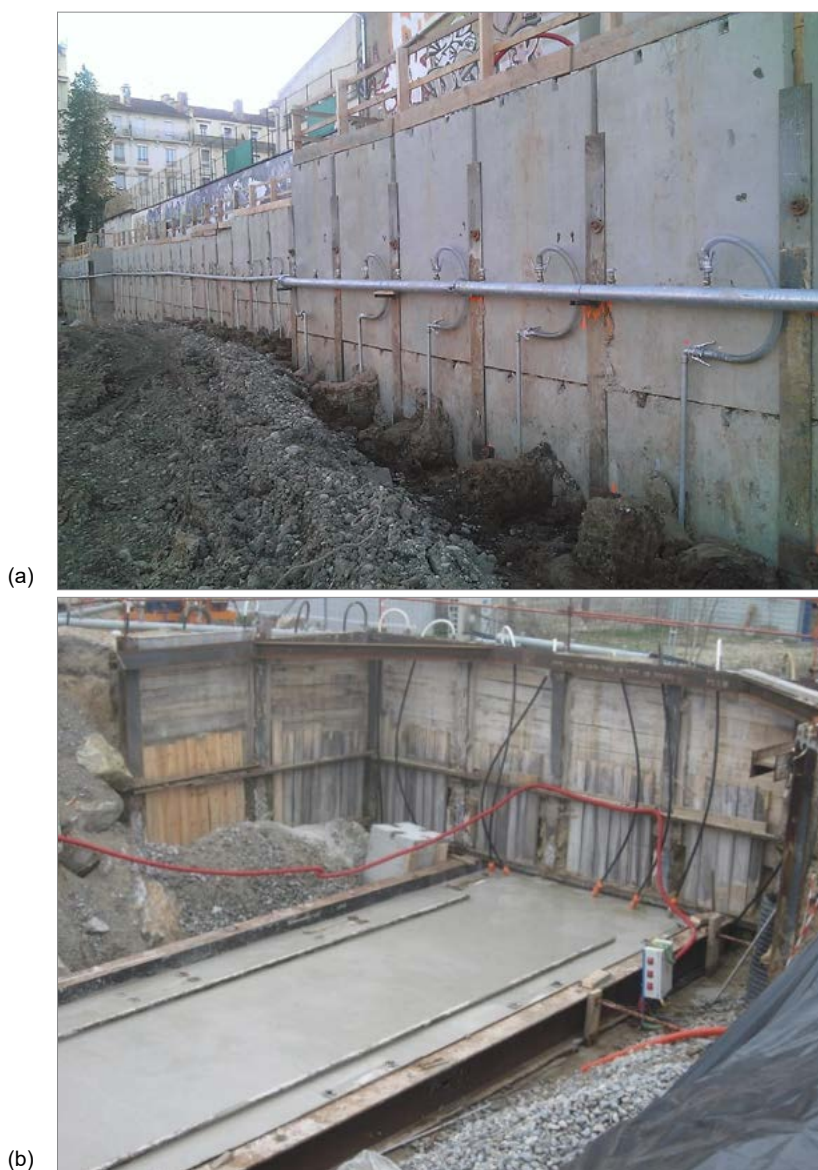
Photographie 2. Rabattement à l'aide de pointes filtrantes : (a) Région parisienne Lyon 9 / DPG Pompage - (b) La Baule / Demathieu Bard 2008
