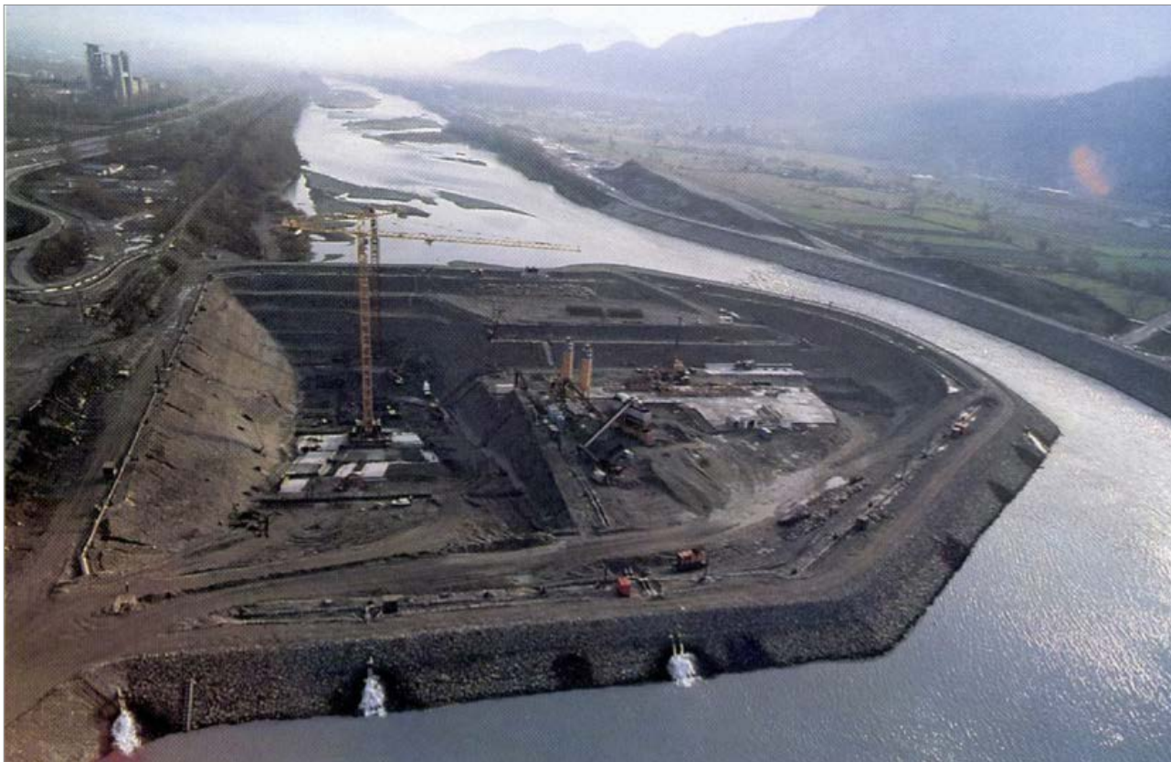
Photographie 8. Mise hors d'eau de la fouille de Saint-Égrève dans le lit de l'Isère avec écran d'étanchéité et puits de pompage / Solétanche-Bachy pour EDF
