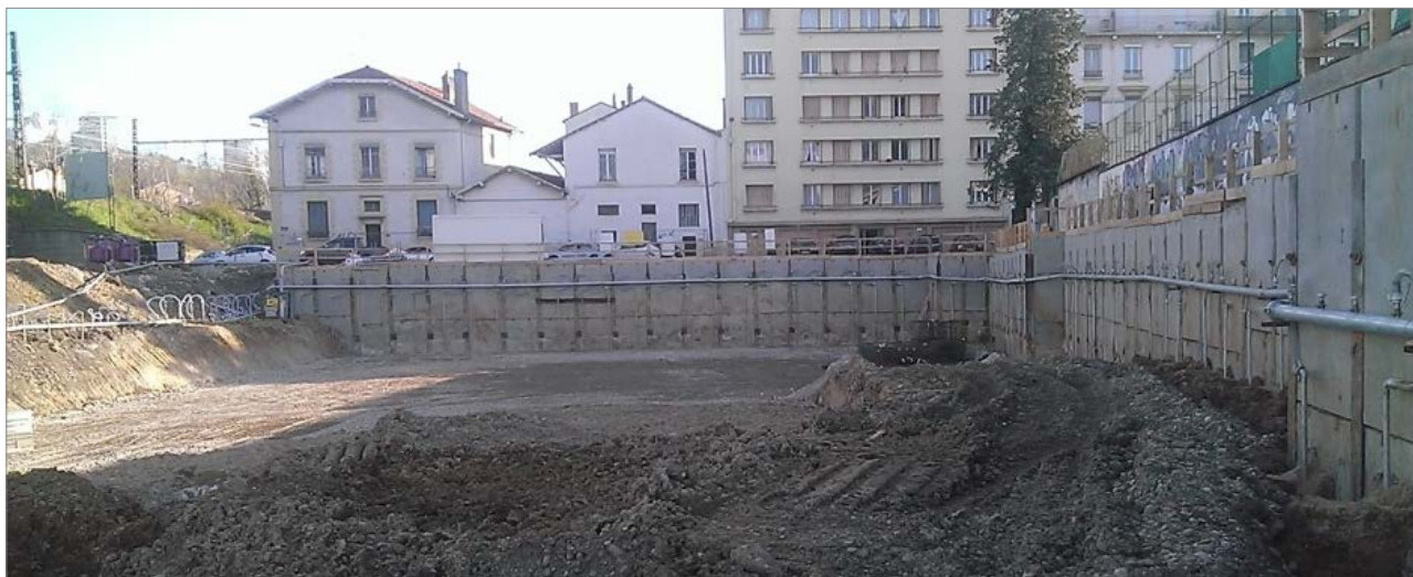
Photographie 33. Points filtrantes sur un rang pour un chantier de rabattement / A. Parrot
