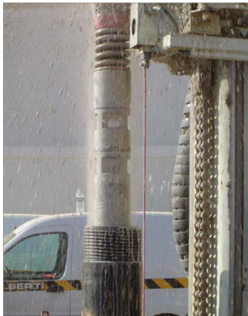
Photographie 17. Forage avec tubage à l'avancement
