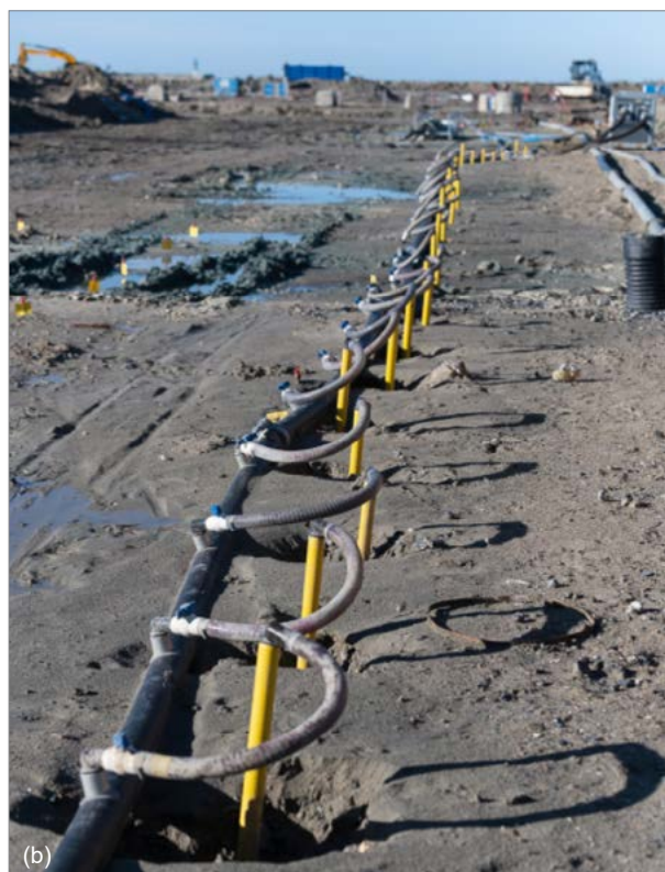
Photographie 30. Installation de pointes filtrantes pour un chantier de paroi moulée / Cédric Helsly
