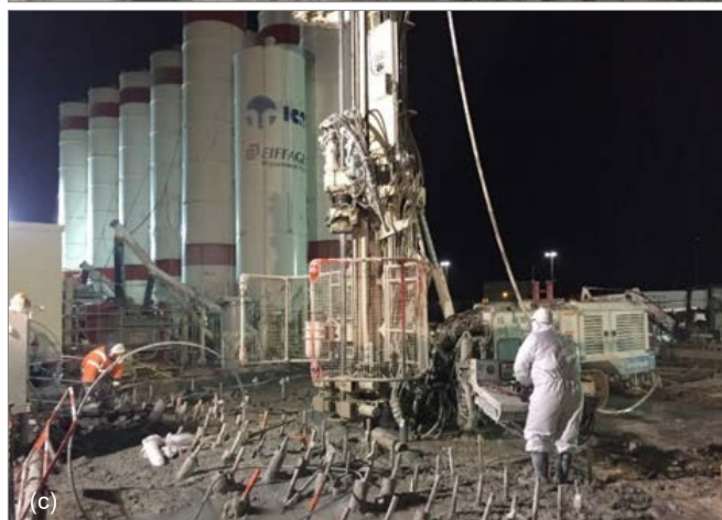
Photographie 12. Chantier d'injections de confinement pour pompage en nappe : fond injecté pour tranchée TGV à Avignon (a), et étanchéification à Fukushima (b) et (c)
