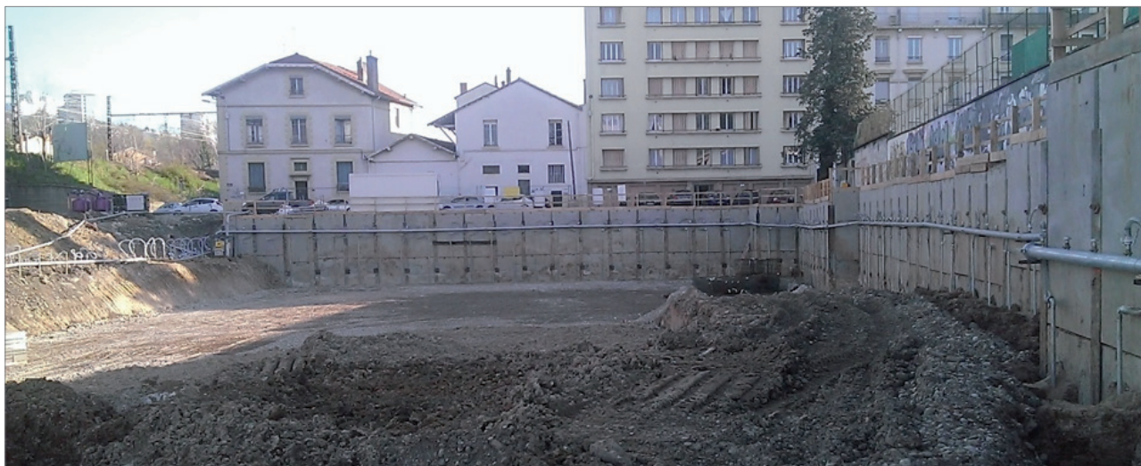
Photographie 33. Points filtrants sur un rang pour un chantier de rabattement / A. Parrot
