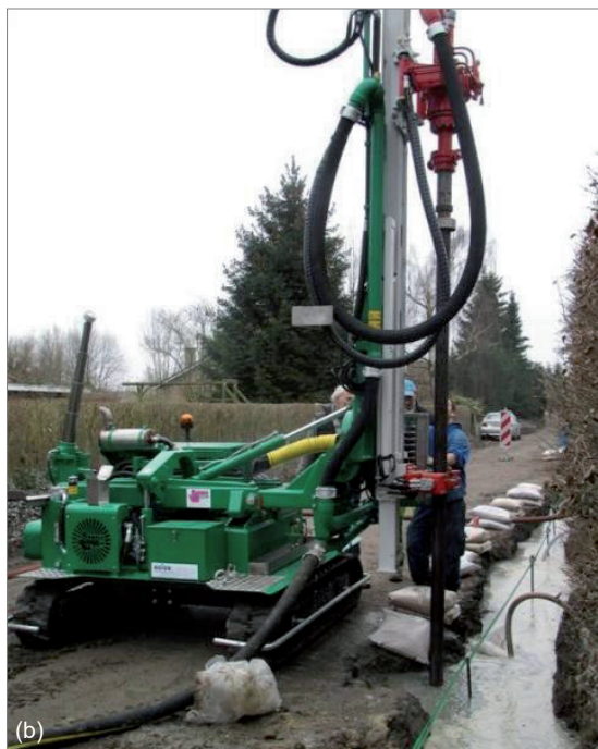
Photographie 29. Mises en œuvre de pointes filtrantes / Cotrasol
