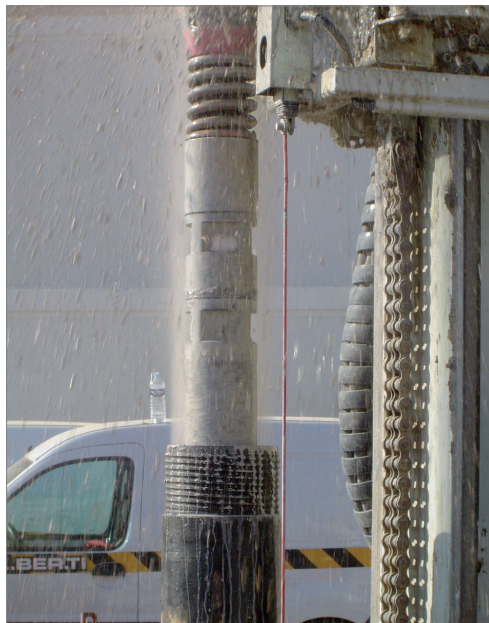
Photographie 17. Forage avec tubage à l'avancement
