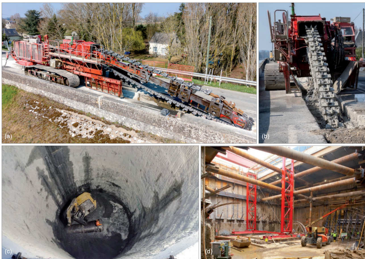
Photographie 11. Technique de mélange sol-ciment Trenchmix sur une digue (a) et (b) / Cédric Helsly, et exemples de soutènement en Deep Soil Mixing - Puits Norris cut (c) et Metro Pittsburg (d)
