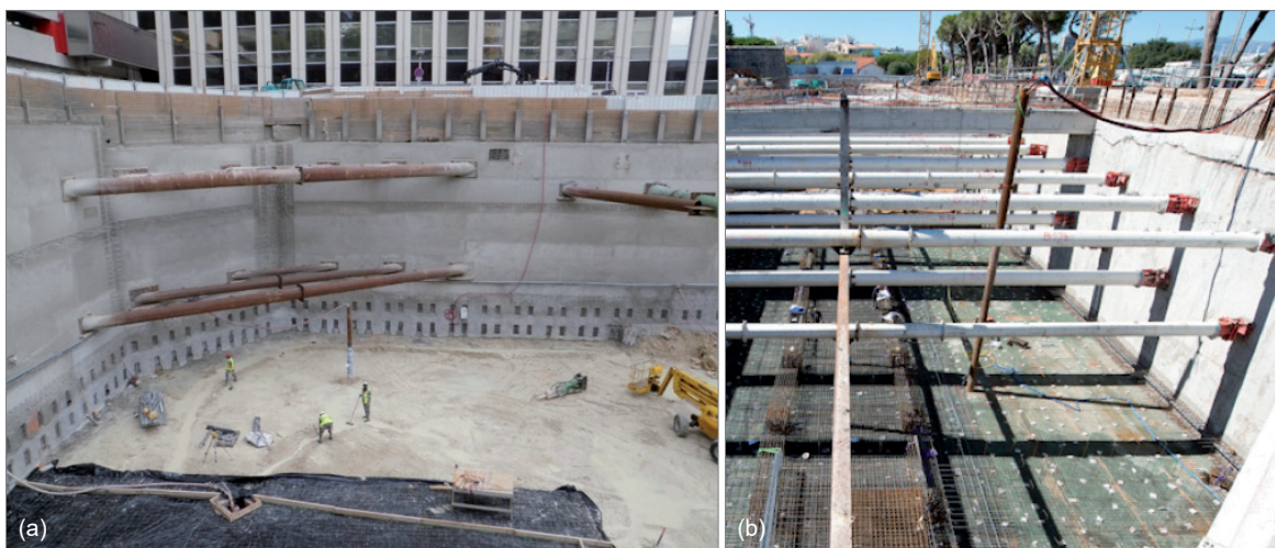
Photographie 4 : écran étanche pour les projets de Tour Majunga à la Défense (a) / Terrasol et de Pré Aux Pêcheurs à Antibes (b) / Cédric Helsly
