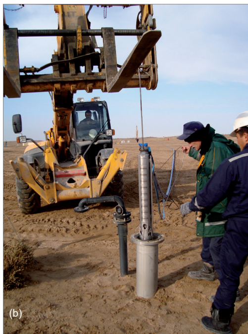
Photographie 26. Pompes centrifuge (a) et multicellulaire (b)
