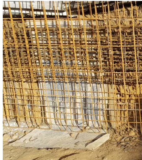
Figure 4-7 : Illustration de la pose du drainage vertical dans la réalisation de voiles par passes
