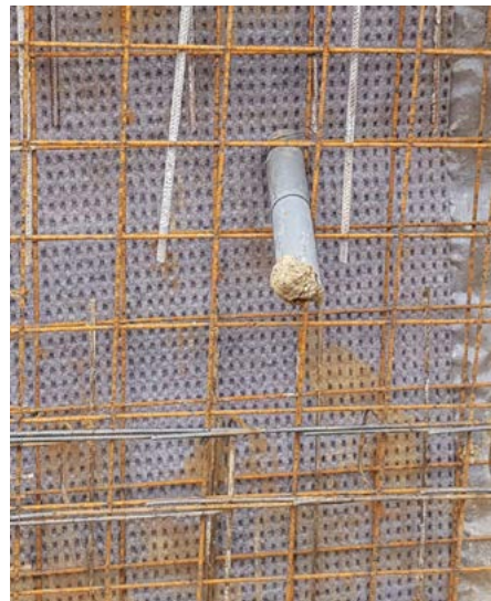
Figure 4-8 : Illustration de la pose d'une barbacane et de la connexion avec le drainage vertical
