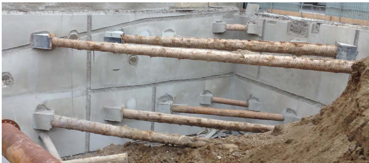
Figure 4-6 : Illustration du serrage de butons d'angle à l'aide de coins en bois installés au niveau des corbeaux en béton armé
