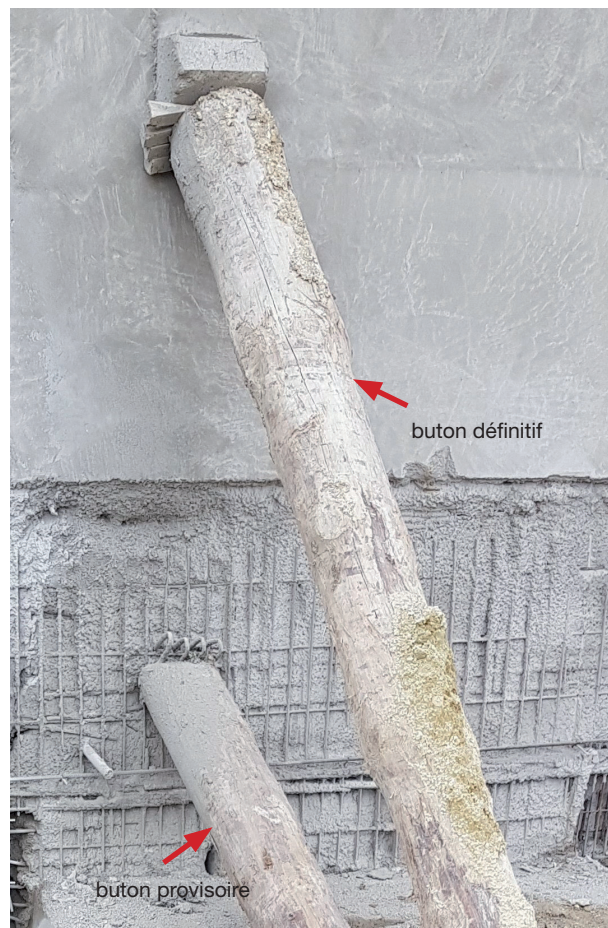
Figure 4-2 : Illustration d'un calage du ferrailage pendant la projection du béton (photo du haut), d'un bouton « provisoire » et d'un bouton « définitif » (photo du bas)
