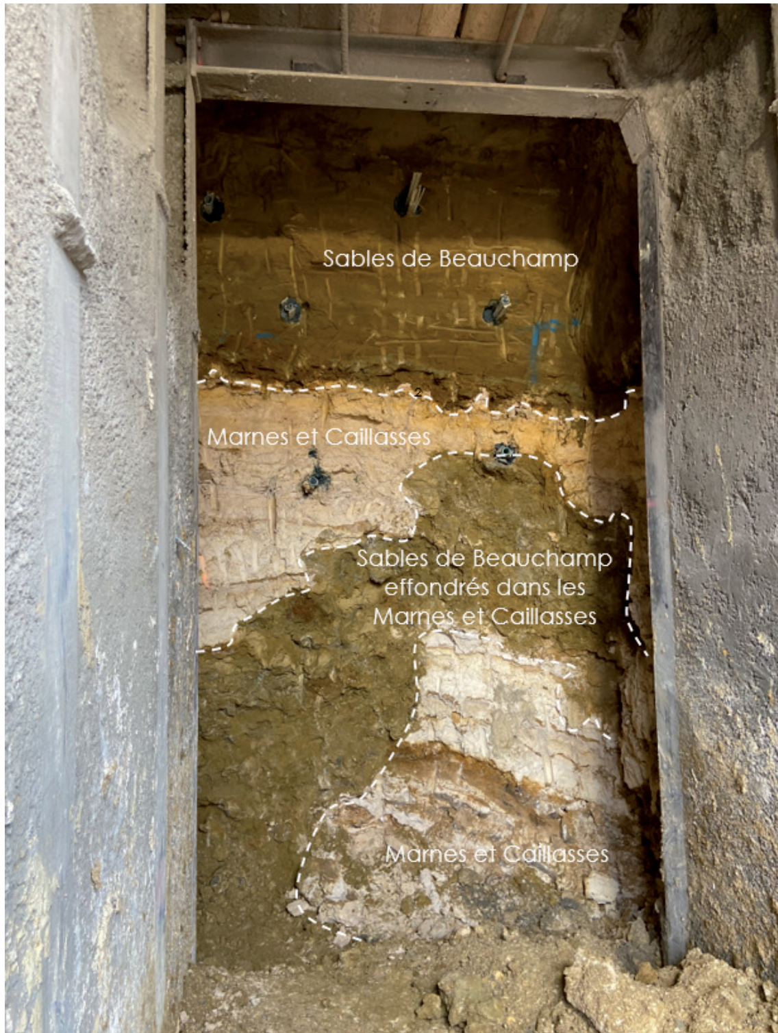
Sables de Beauchamp « tombés » au sein des Marnes et Caillasses à la faveur de galeries et cavités de dissolution karstiques formées dans ces dernières (Tunnel TSEE, Paris 12). Photographie F. Binet
