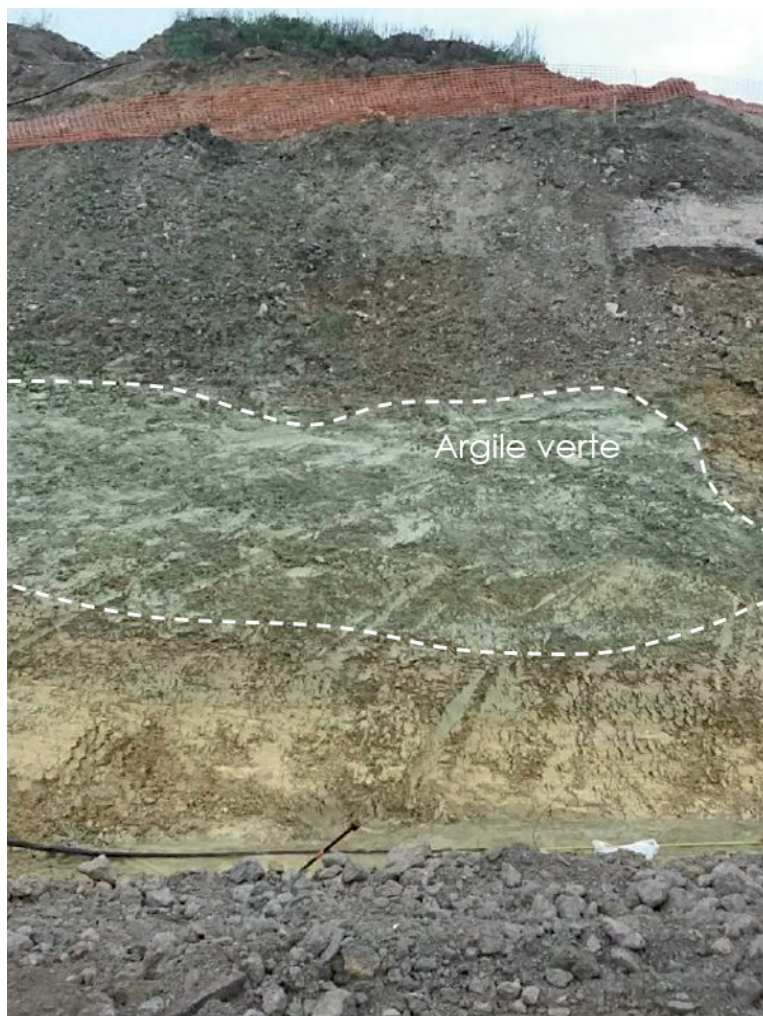
Affleurement mis au jour après terrassement d'une butte naturelle à BVC (gare Bry-Villiers-Champigny nouvellement Villiers-Champigny-Bry), le long de la ligne L15S T2B du GPE (Grand Paris Express). La couche verte correspond à la formation des Argiles vertes de Romainville. Photographie G. Meyer
