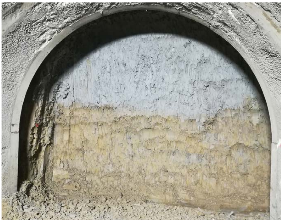
Front d'excavation dans la formation de l'Argile plastique : la teinte gris pâle de la partie supérieure du front est fréquemment observée dans la partie supérieure de la formation ; en partie inférieure du front on retrouve le caractère plus bariolé (beige-jaune +/- gris) de l'Argile plastique mais de manière encore discrète et sans la teinte lie-de-vin très développée par ailleurs dans la formation. Grand Paris Express (GPE) : L15Sud T2B (OA 1002P). Photographie G. Meyer
