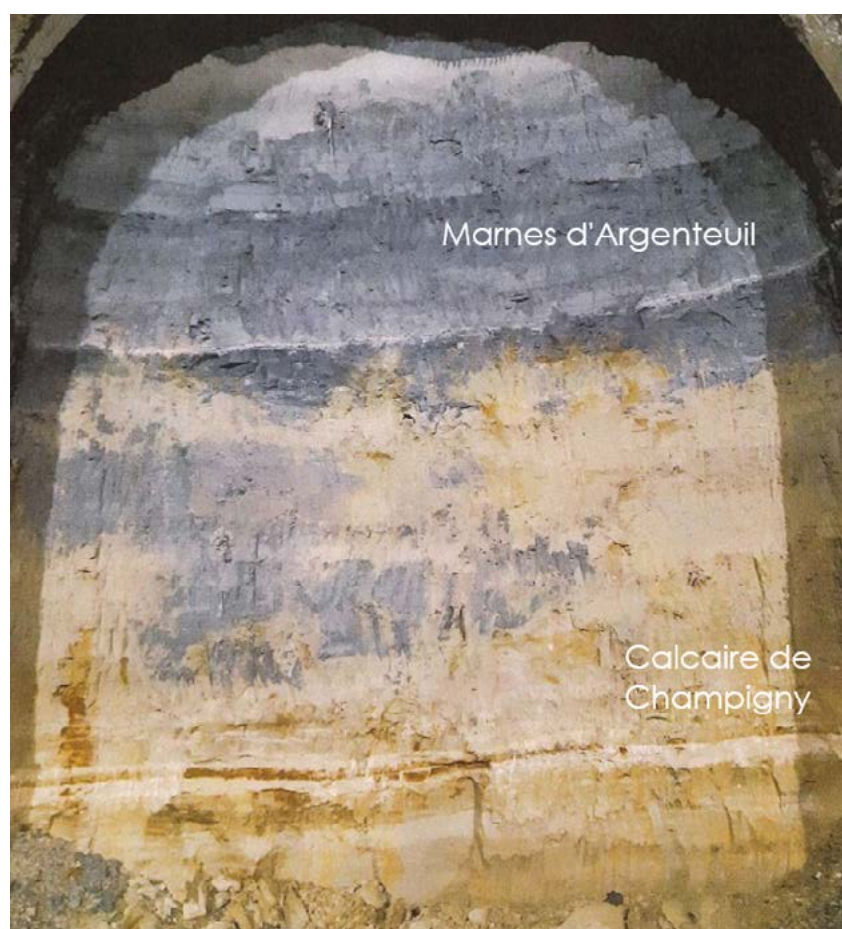
Front creusé dans les Marnes « bleues » d'Argenteuil (et Calcaire de Champigny à la base) : on voit bien ici que la teinte bleue des marnes n'est pas homogène et ne peut être retenu comme un critère exclusif de distinction de la formation notamment dans sa partie inférieure ou basale. GPE, L15 Sud T2C (OA 0803P). Photographie G. Meyer
