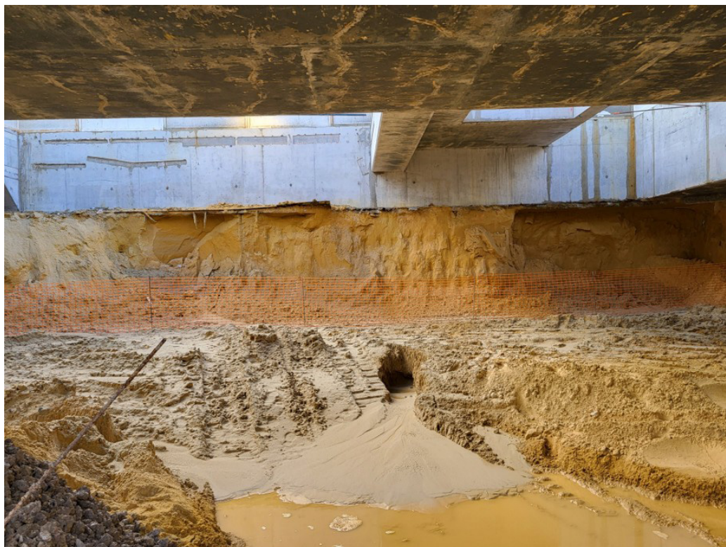
Excavation dans les Sables de Fontainebleau très altérés sur la ligne 18-3 à Versailles-Chantiers du GPE (Grand Paris Express). Photographie F. Binet
