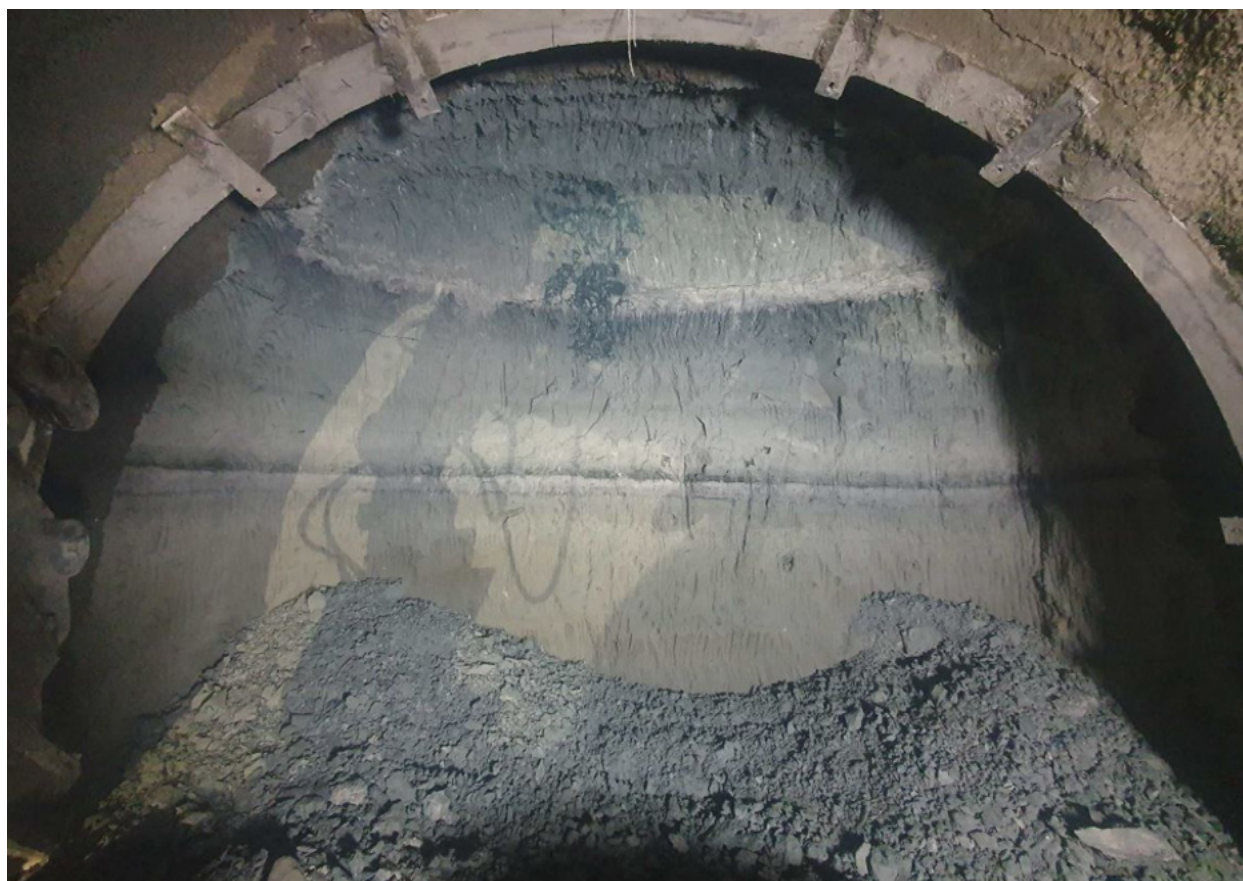
Front d'excavation dans les Sables de Beauchamp, Grand Paris Express, L15 Sud-T2B (OA 0901P). Photographie G. Meyer
