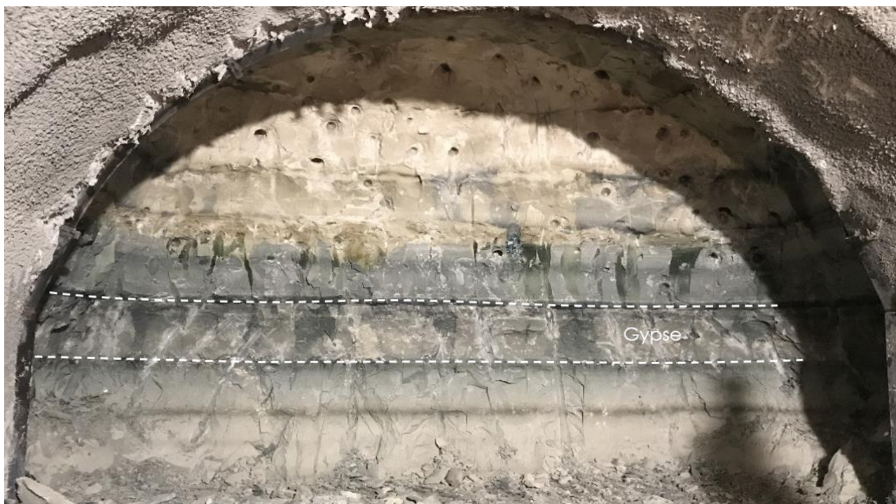
Front d'excavation dans les Masses et marnes du Gypse avec bancs de calcaires, de marnes et de gypse. GPE, Ligne 15 Sud T2A (OA 1501P). Photographie G. Meyer
