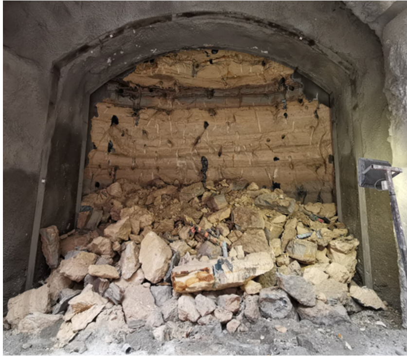
Front d'excavation dans le Calcaire grossier « moyen », chantier EOLE (gare Porte-Maillot). Le Banc vert est ici très bien exprimé, avec les lits plus sombre en haut et en bas et le faciès laminé typique entre les deux. Photographie Y. Liou
