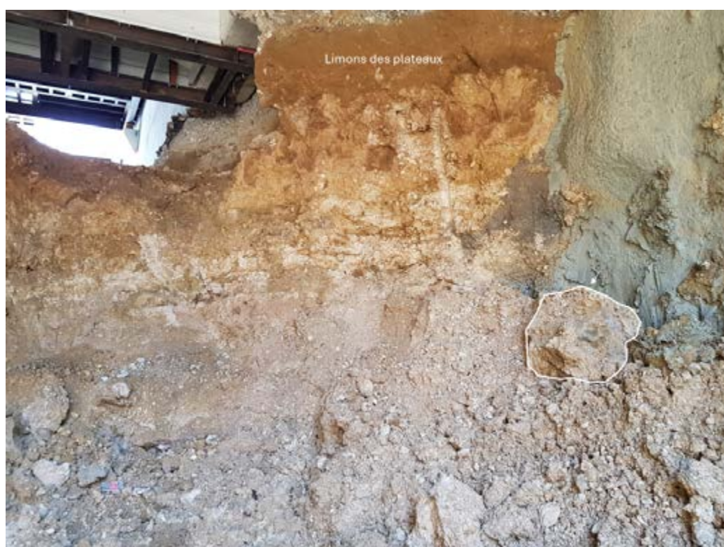
Excavation dans le Calcaire de Brie altéré sur la ligne 15 Sud à VLA (Villejuif-Louis-Aragon) du GPE (Grand Paris Express). Photographie F. Binet
