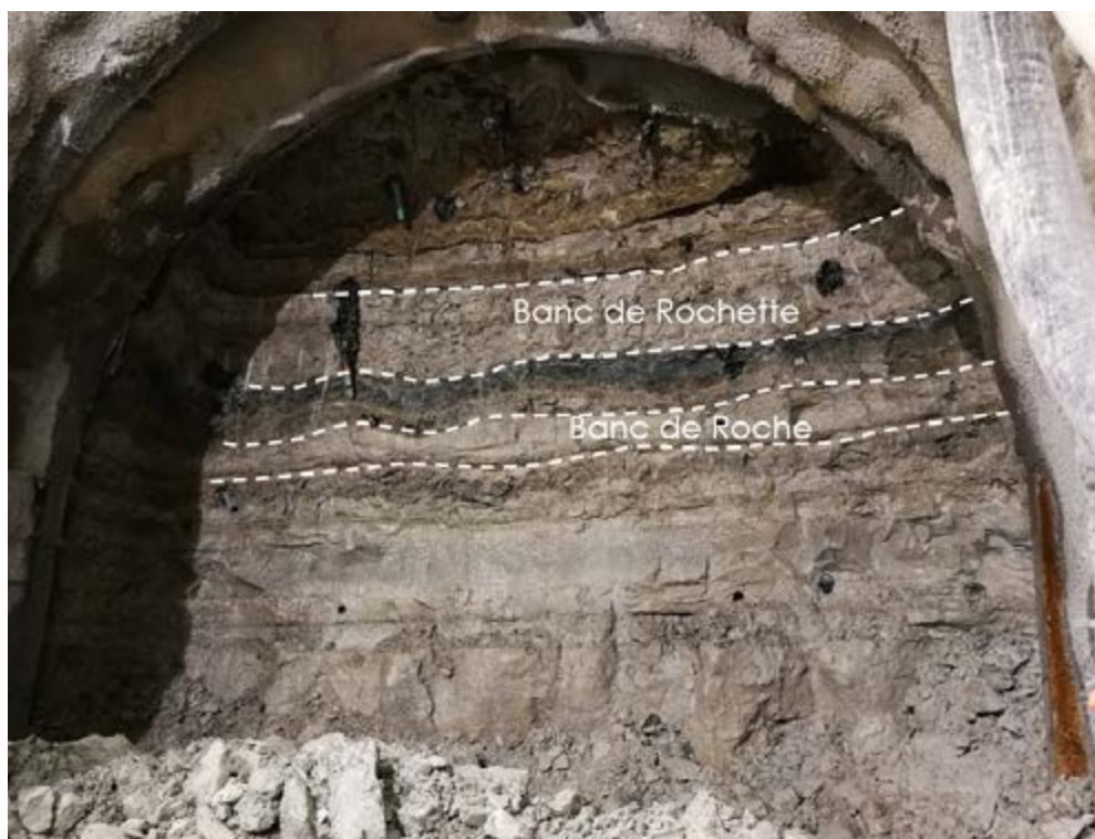
Front d'excavation à travers les Marnes et Caillasses et le Calcaire grossier (EOLE, secteur HSL).
