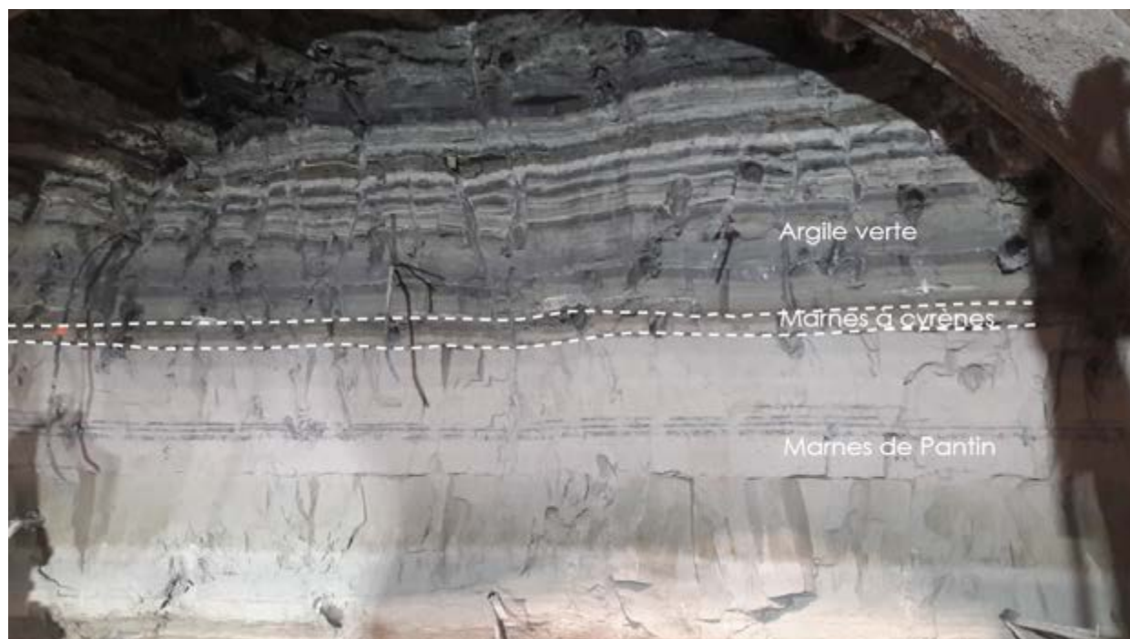
Front creusé dans les Argiles vertes de Romainville ici très litées et les Marnes « blanches » de Pantin. GPE, L14 Sud (Gare IGR = Villejuif-Gustave Roussy (anciennement Institut Gustave-Roussy)). Photographie F. Binet
