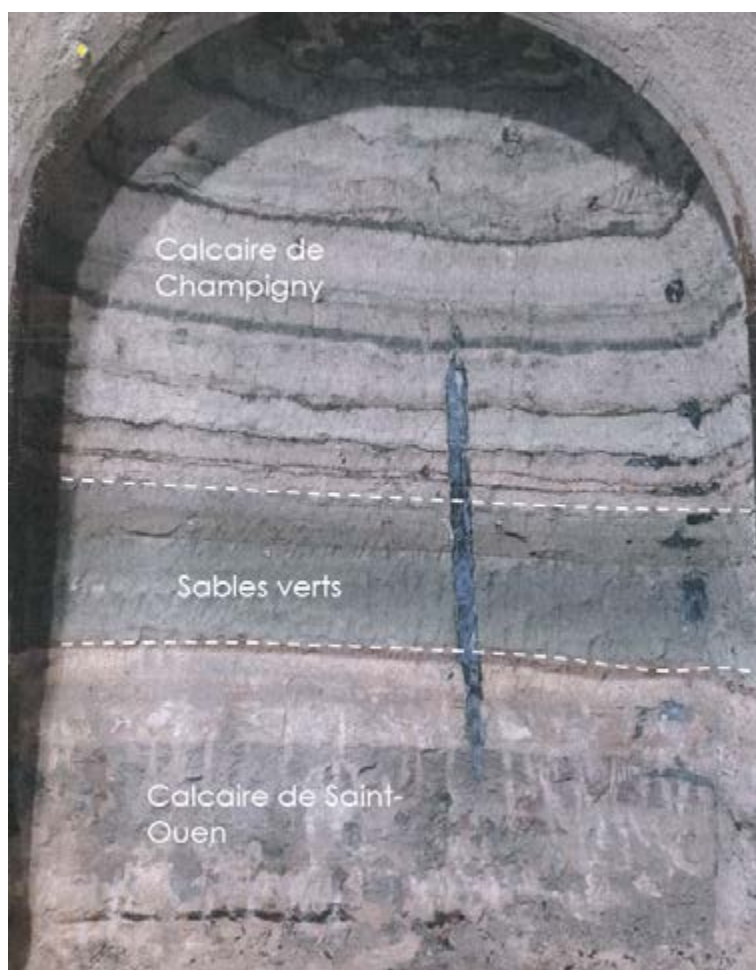
Front d'excavation dans (de haut en bas) : le Calcaire de Champigny bien stratifié (partie supérieure du front), les Sables verts ici bien individualisés et le Calcaire de Saint-Ouen en partie basale. Un tube d'injection de coulis bentonite-ciment est visible au milieu du front. GPE, L15 Sud T2C (OA 0808P). Photographie G. Meyer
