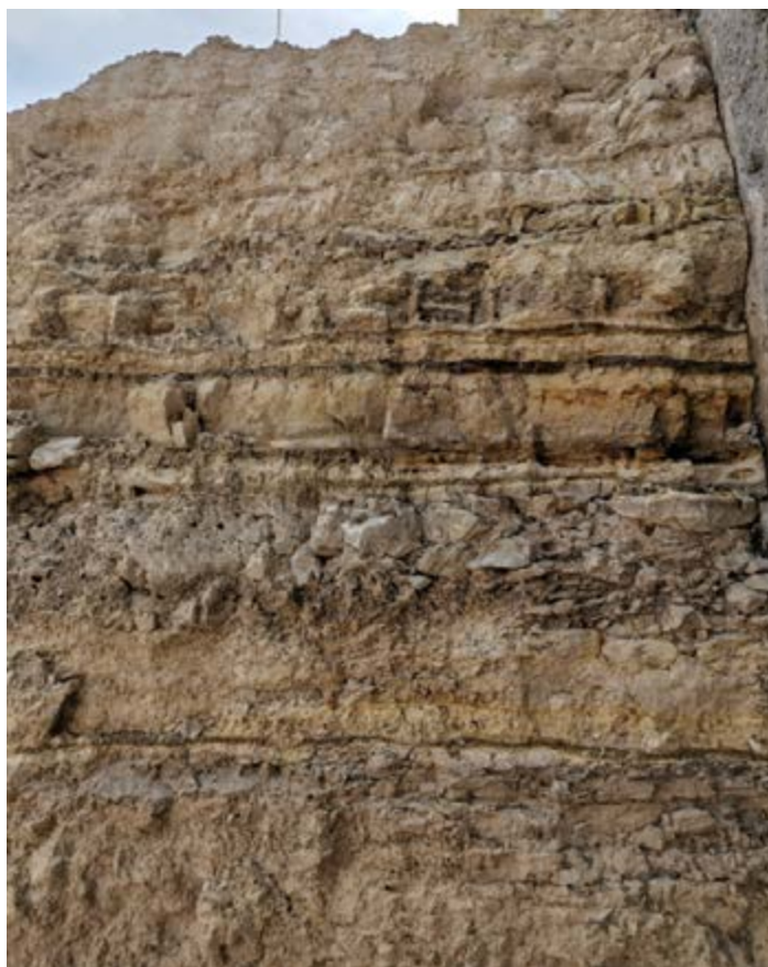
Affleurement de Marnes et Caillasses mis au jour lors de l'excavation de la gare Porte-Maillot (EOLE).
