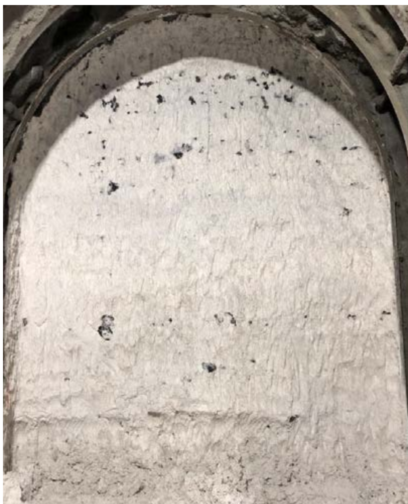
Front d'excavation dans la Craie campanienne. On note le caractère lithologiquement homogène de la craie (très peu stratifiée ici) à l'exception des silex noirs plus ou moins dispersés soulignant une stratification fruste. GPE, L15Sud T2B (OA 1003P). Photographie G. Meyer
