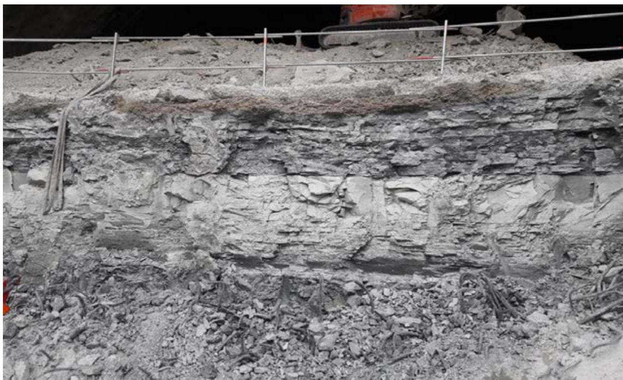
Excavation réalisée dans les Marnes « bleues » d'Argenteuil, L14 Sud (Gare IGR = Villejuif-Gustave Roussy (anciennement Institut Gustave-Roussy)). Photographie F. Binet
