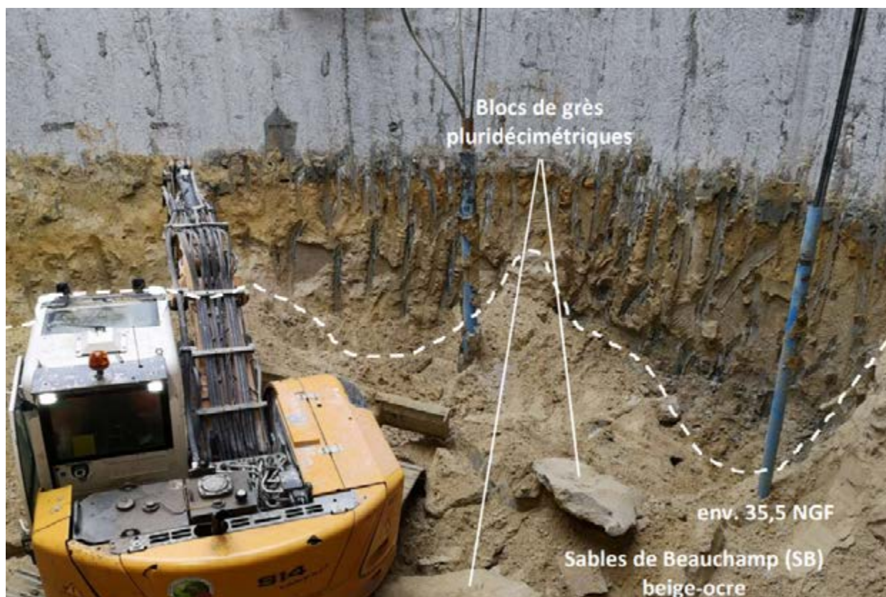
Fond de fouille interprété du puits 0201 de la ligne 16 du GPE mettant en évidence des blocs/lentilles de grès extrêmement durs et abrasifs au sein de la formation des Sables de Beauchamp. Photographie Eiffage pour SGP
