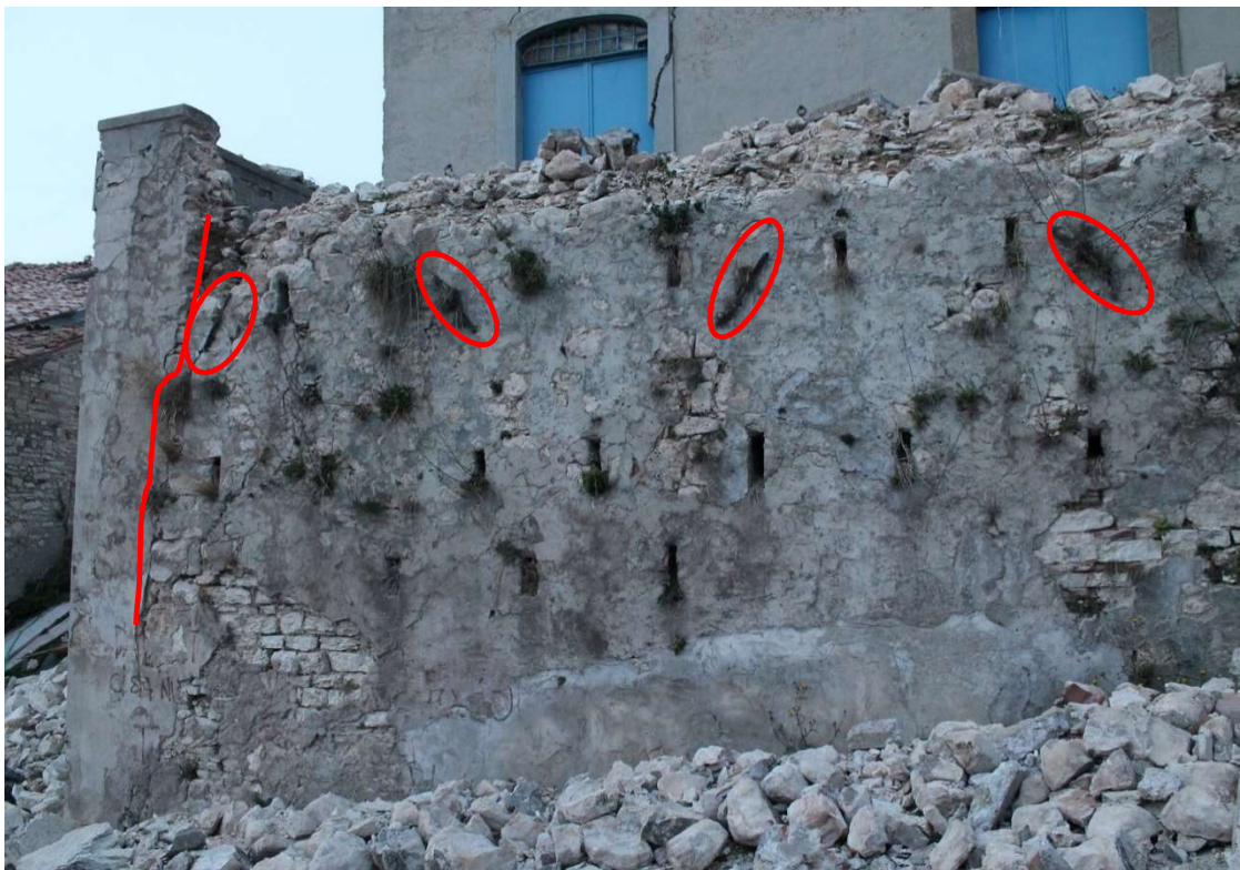
Mur maçonné 3-4m renforcé par clouage
