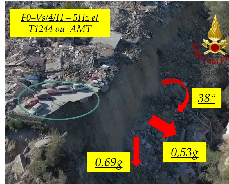
Rupture fragile de la falaise et du mur lors d'un 2 ème séisme (30 octobre)
