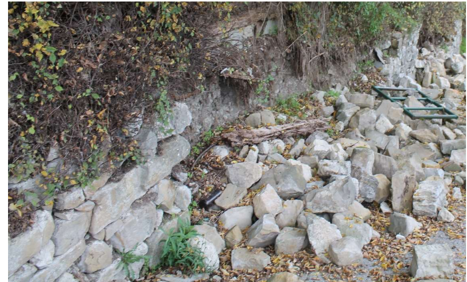
Aucun signe de rupture géotechnique
