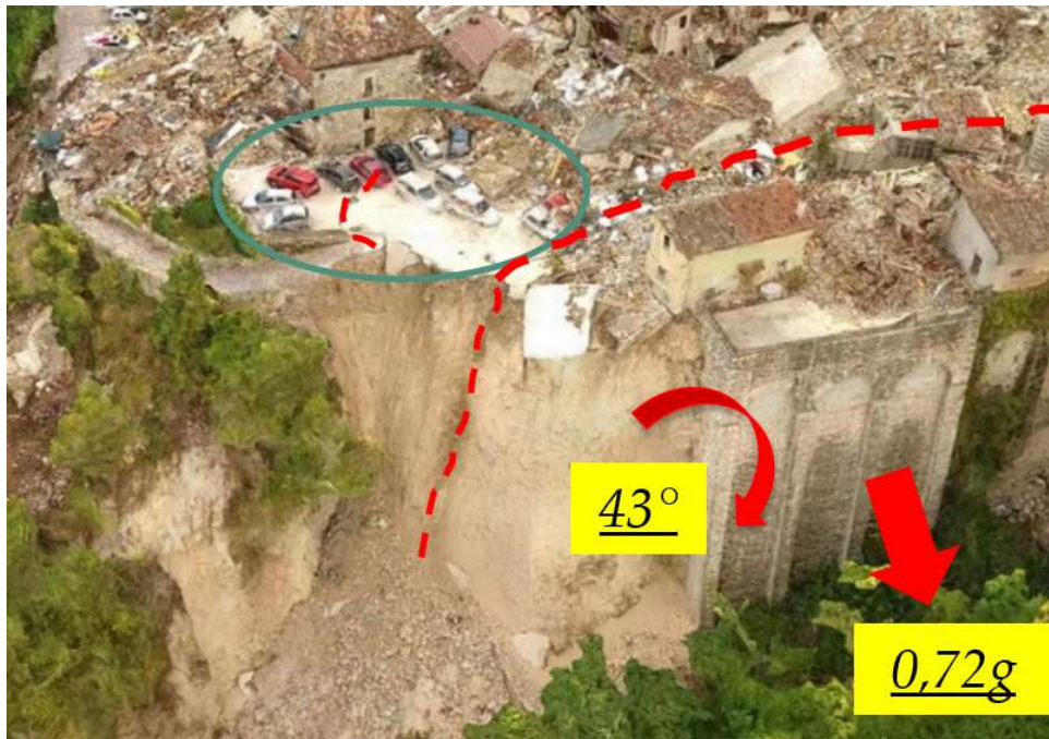
Endommagement du massif identifié après le séisme du 24 août : perte de cohésion du matériau
