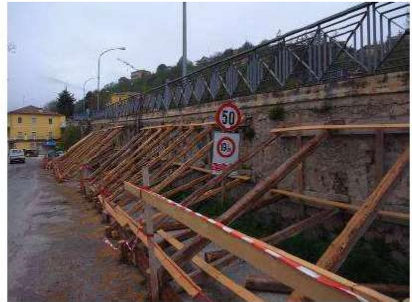
AFPS (2009). Mur de soutènement, tassement du remblai de la rampe d'accès, détail de déformation de la chaussée, confortation du mur. Route d'accès Sud à la ville de L'Aquila (SS17), un mur de soutènement en pierres cimentées, de hauteur variable jusqu'à environ une douzaine de mètres.
