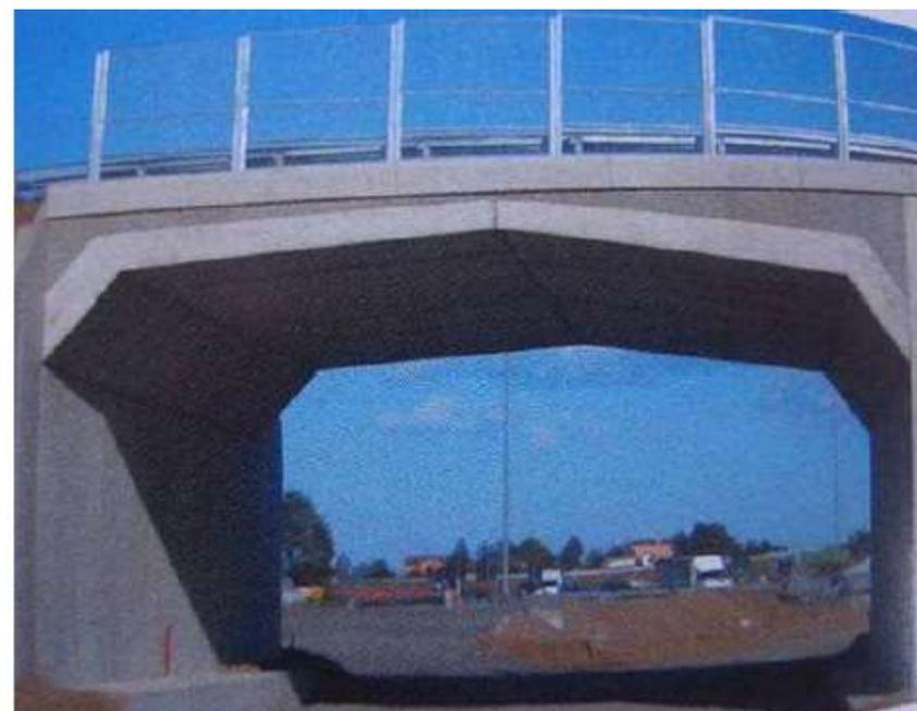
AFPS (2009). Mur de soutènement en éléments préfabriqués et pont cadre préfabriqué. Bon comportement de ces ouvrages sous séisme.
