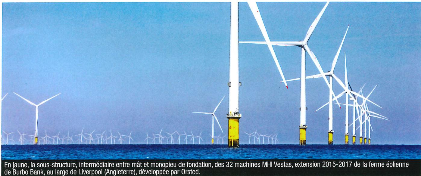
En jaune, la sous-structure, intermédiaire entre mât et monopieu de fondation, des 32 machines MHI Vestas, extension 2015-2017 de la ferme éolienne de Burbo Bank, au large de Liverpool (Angleterre), développée par Orsted.
