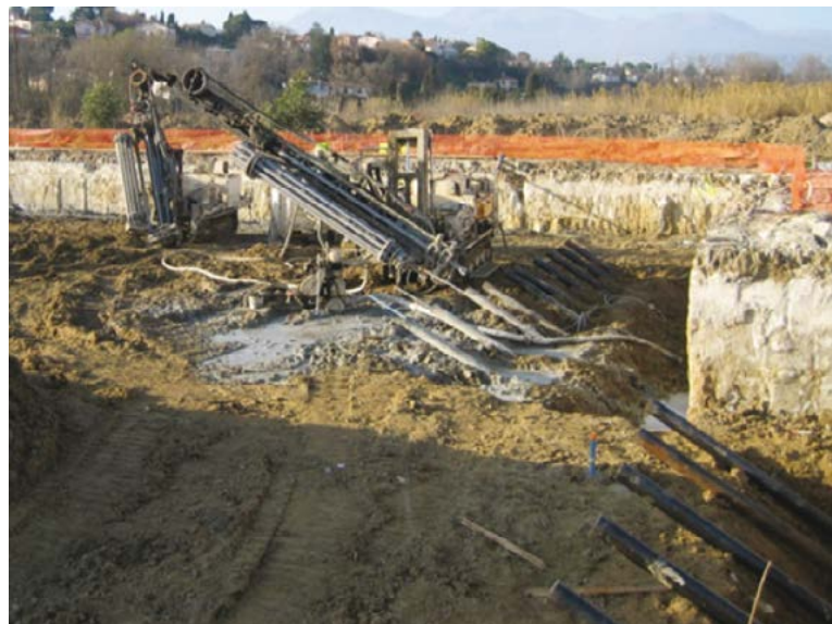
Photo 7.7 : forage avec tubes prolongateurs (© Spie Fondations)
