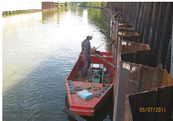
Photo 7.17 : Exemple de mise en tension de tirants sur un rideau de palplanches
