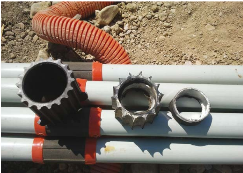
Photo 4.4 : écarteurs posés sur des tubes à manchettes (© Freyssinet)
