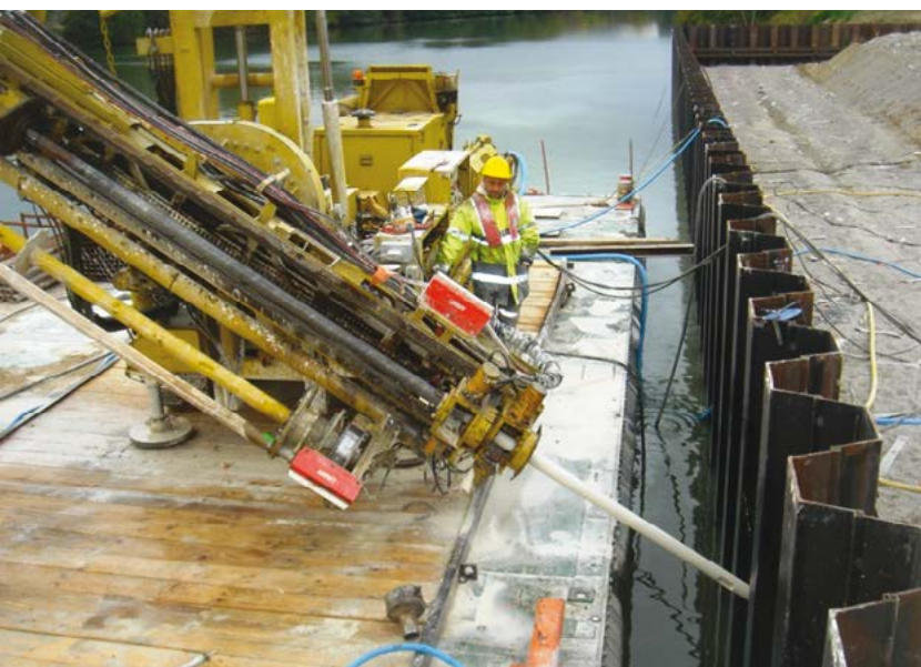
Photo 7.4 : foreuse installée sur une barge (© Sefi Intrafor)
