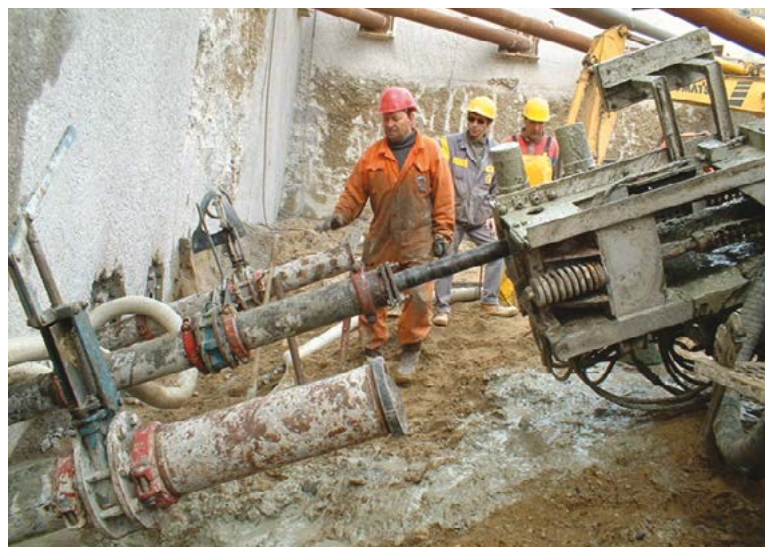
Photo 7.6 : forage sous sas (© Sefi Intrafor)
