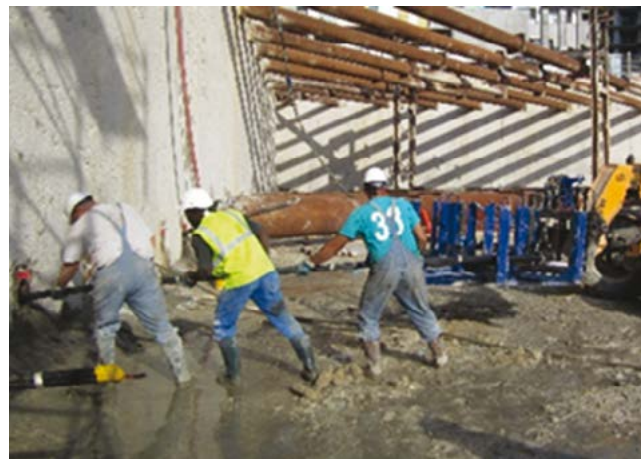
Photo 7.10b : tirant en cours de déroulement dans le forage (© Freyssinet)
