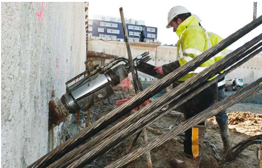
Photo 7.14 : mise en service du tirant (© Sefi Intrafor)
