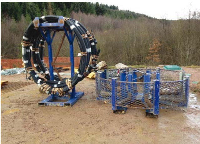
Photo 7.10a : à droite, dérouleur pour faciliter l'installation du tirant ; à gauche, portique pour conditionnement et enrouleur (© Freyssinet)
