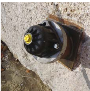
Photo 6.3 : Tête de tirant avec protection de type T (©Freyssinet)
