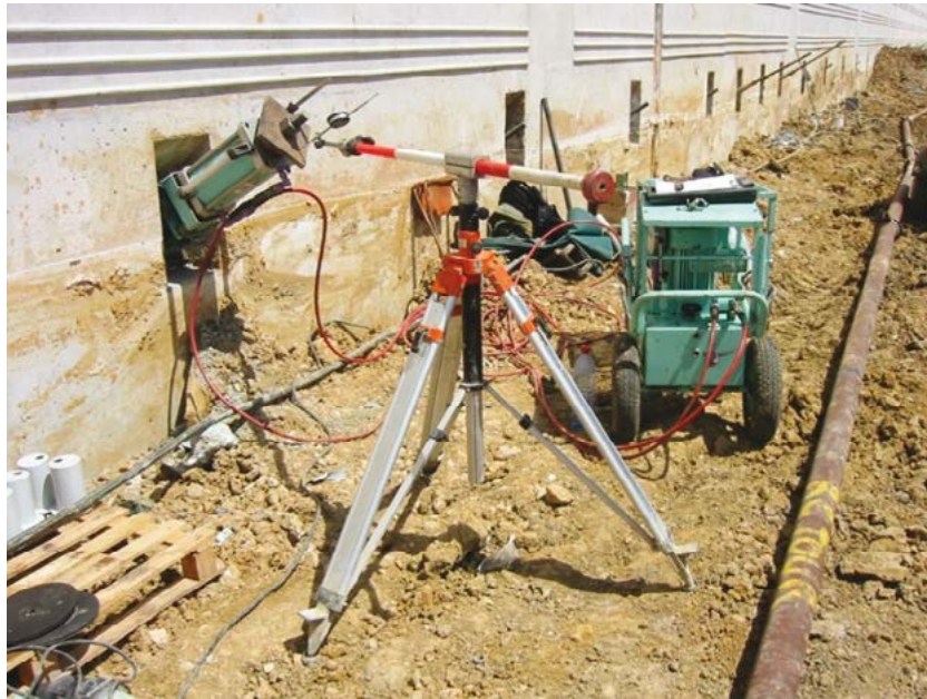
Photo 8.3 : exemple de dispositif pour essai de contrôle (© SMG)
