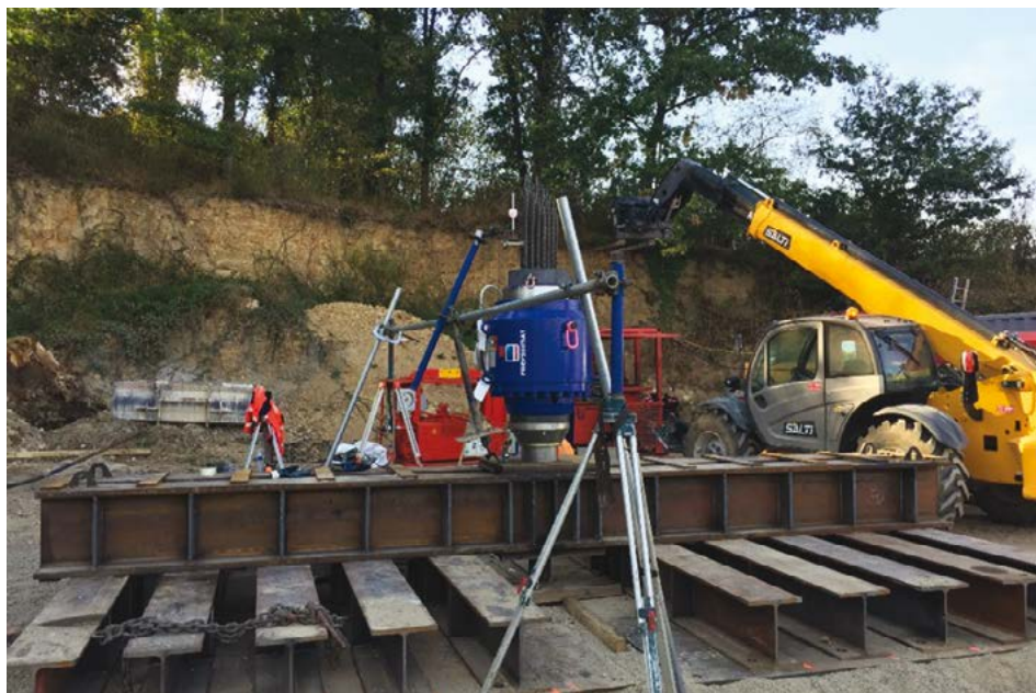
Photo I.1 : Structure d'appui d'essai de chargement (© Soletanche Bachy)
