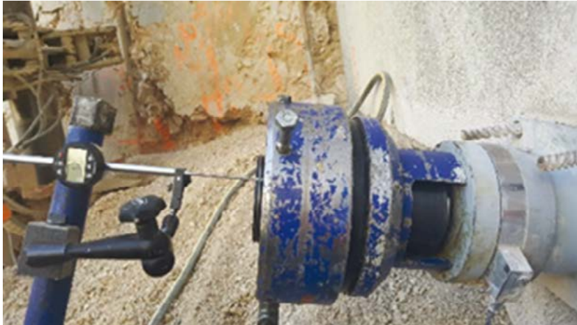
Photo 8.10 : pesage d'un tirant avec tête instrumentée (© Freyssinet)
