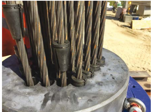
Photo 7.19a : Clavettes en cours de mise en position (© Soletanche Bachy)
