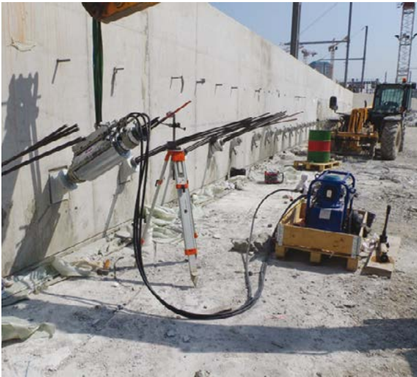
Photo 8.4 : essai de contrôle (© Soletanche Bachy)
