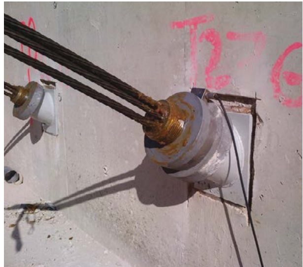
Photo 8.5 : tête de tirant instrumentée (© Freyssinet)
