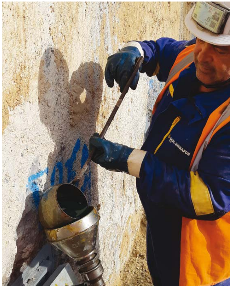
Photo 6.5 : remplissage du tube-trompette de produit anti-corrosion (cire)
