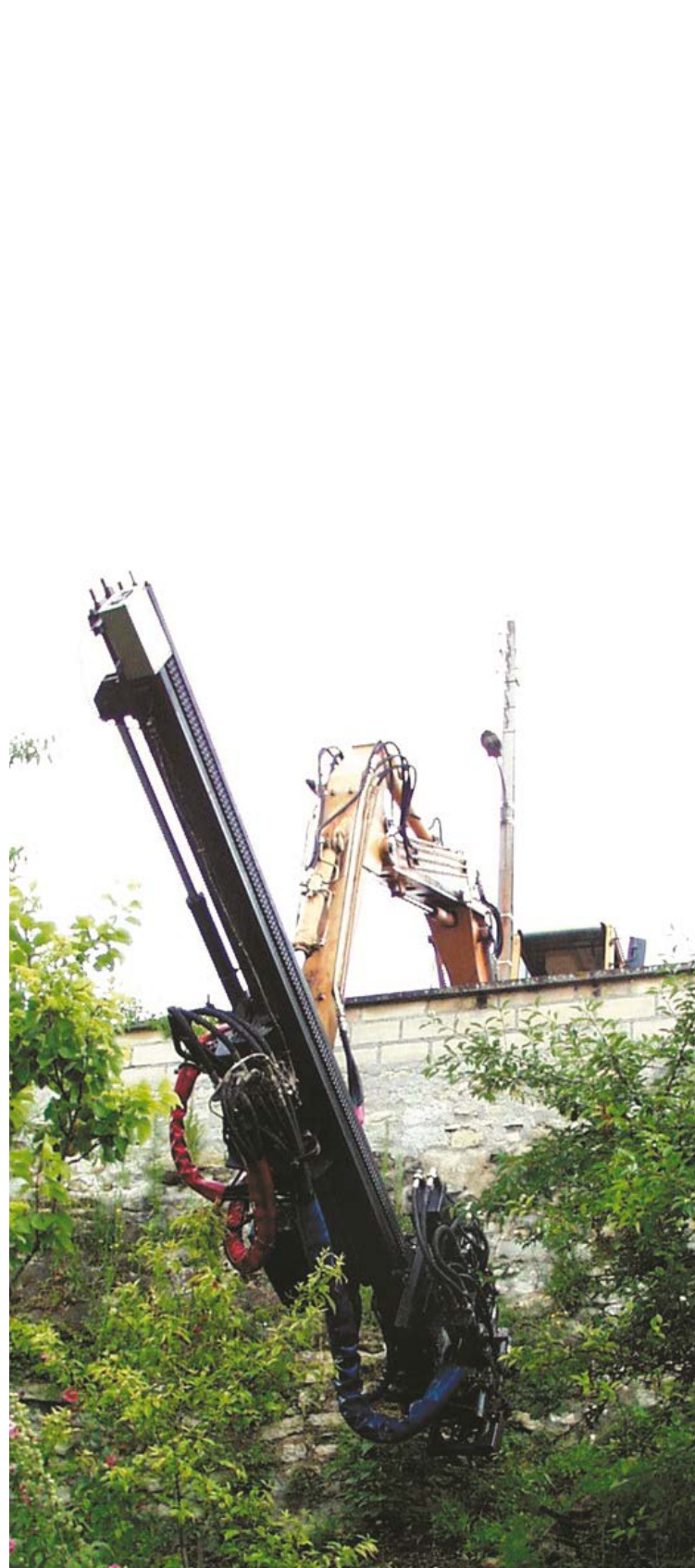
Photo 7.3 : foreuse montée en rétro (© Spie Fondations)
