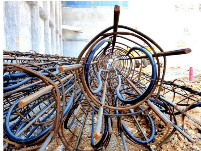
Illustrations de la fixation de tubes PEHD sur des armatures de pieux géothermiques (géothermie-professionnelle)
