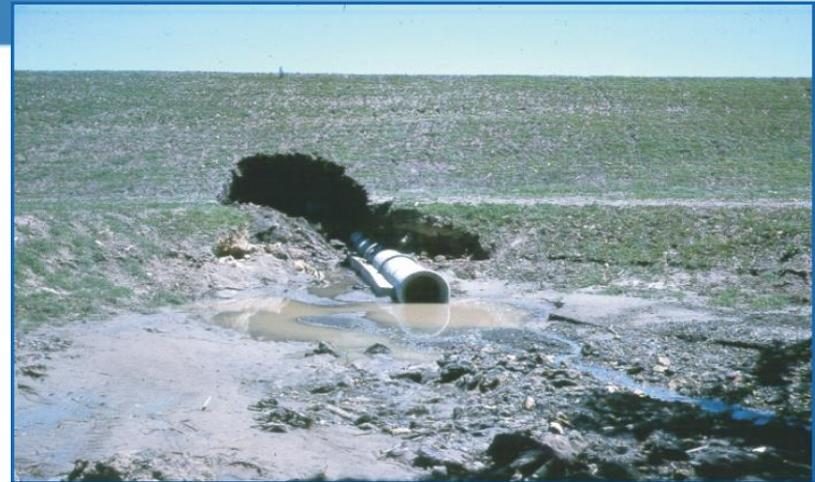
Erosion interne (de conduit) le long d'un ouvrage traversant
