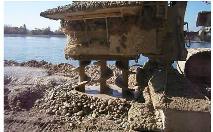
Création d'un renforcement de sol/étanchement par soil mixing (triple taryère)
