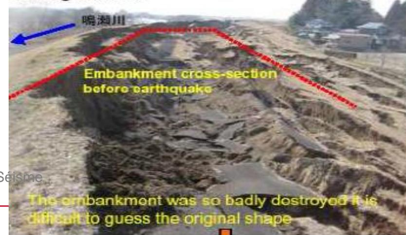
Rupture d'une digue par liquéfaction - Séisme de Tohoku - Japon 2011
