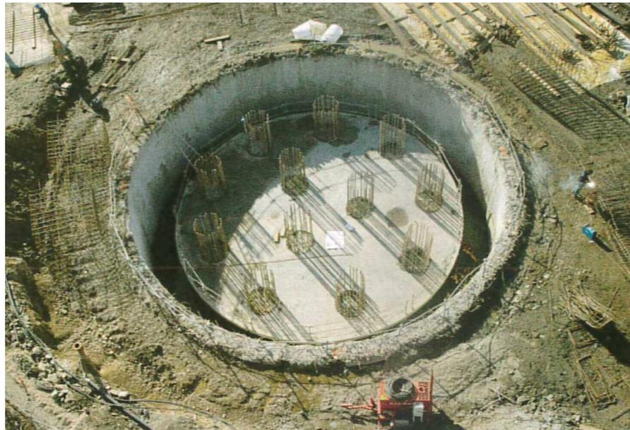
**Photo des travaux, semelle sur pieux + protection par enceinte circulaire**
