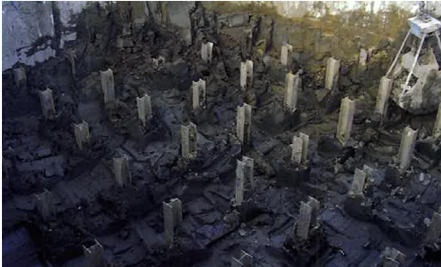
**Excavation des argiles/ têtes des inclusions rigides**
