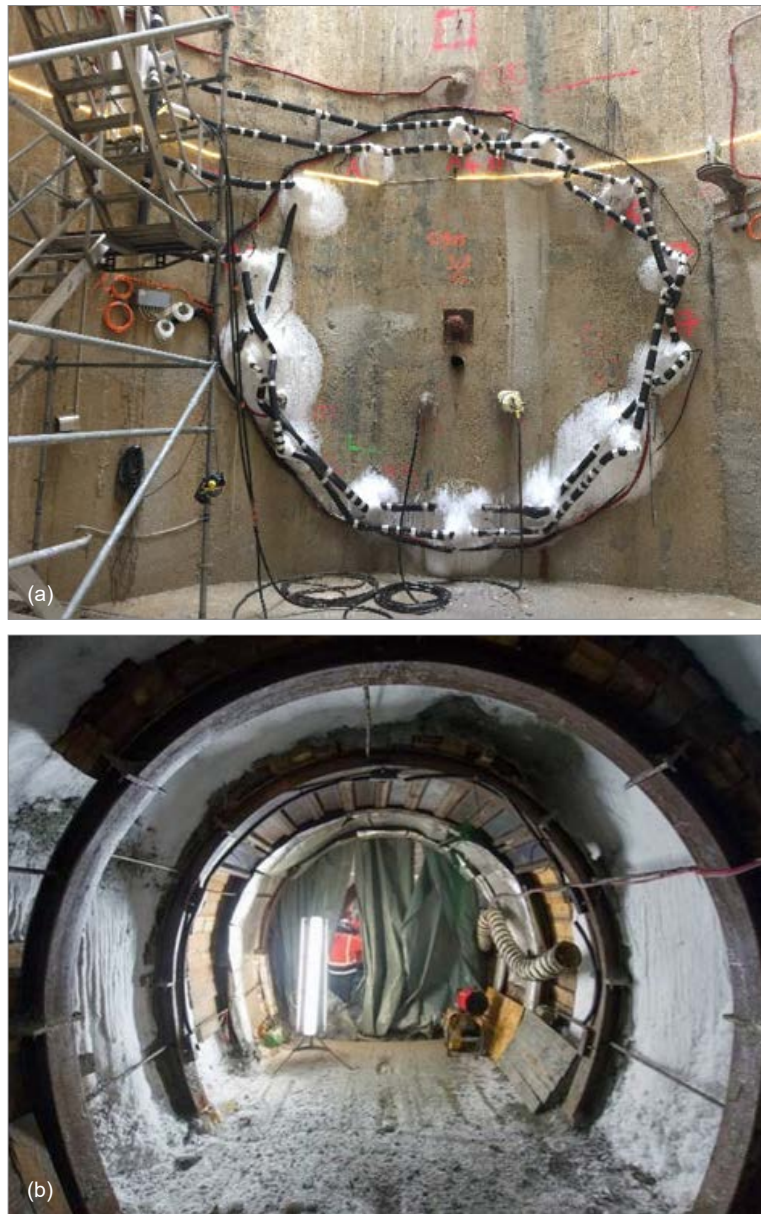
Photographie 13. Exemple de congélation des sables de Beauchamp pour excavation d'une galerie avant (a) et après creusement (b) / Solétanche-Bachy
