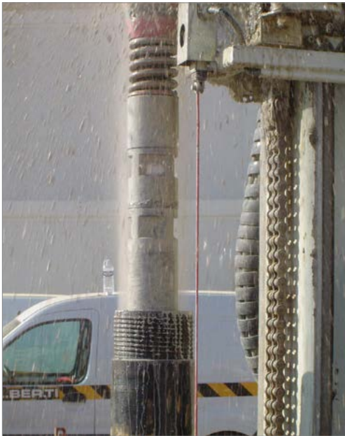
Photographie 17. Forage avec tubage à l'avancement
