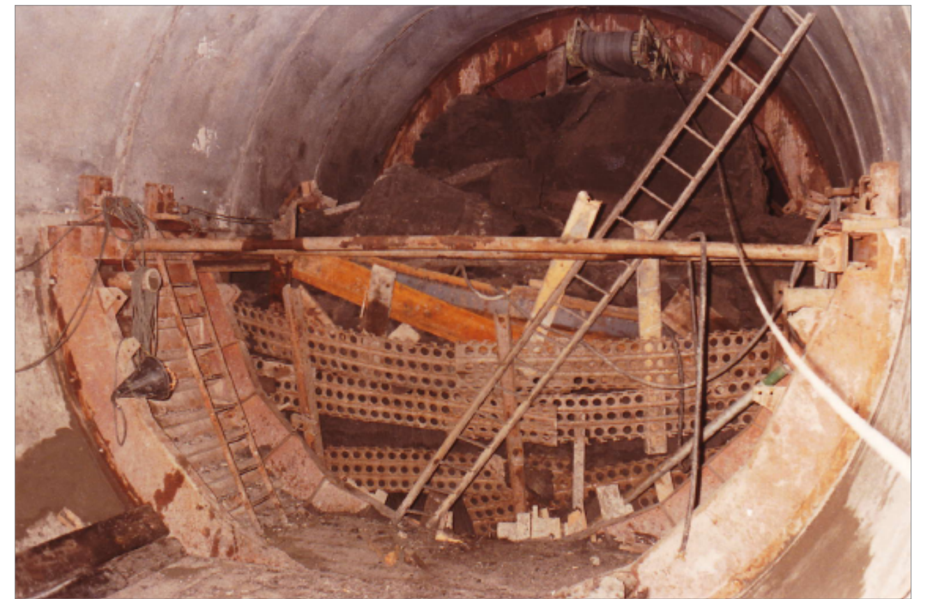
Photographie 15. Soulèvement en galerie creusée dans l'Argile du Gault, dû à la sous-pression de la nappe de l'Albien / EDF
