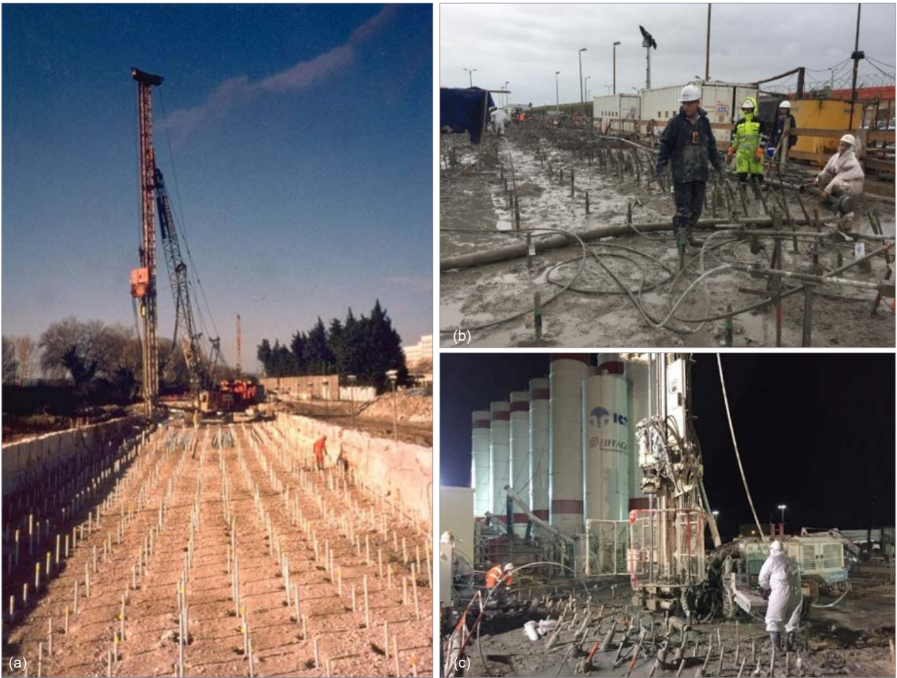
Photographie 12. Chantier d'injections de confinement pour pompage en nappe : fond injecté pour tranchée TGV à Avignon (a), et étanchéification à Fukushima (b) et (c)
