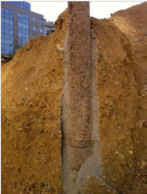
Photographie 18. Vue en coupe d'un puits de pompage terrassé (espace annulaire, crépine) / Cotrasol
