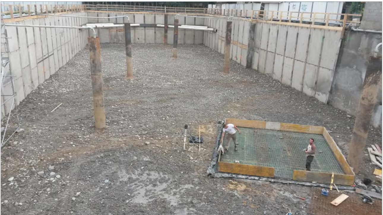
Photographie 3. Rabattement par puits à Ville La Grand / DPG Pompage
