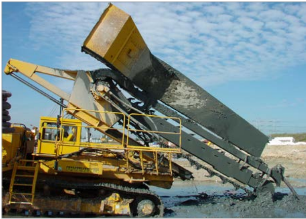
Photographie 34. Trancheuse permettant de creuser sur plusieurs mètres, et de poser le drain et le gravier à l'avancement / E. Garroustet
