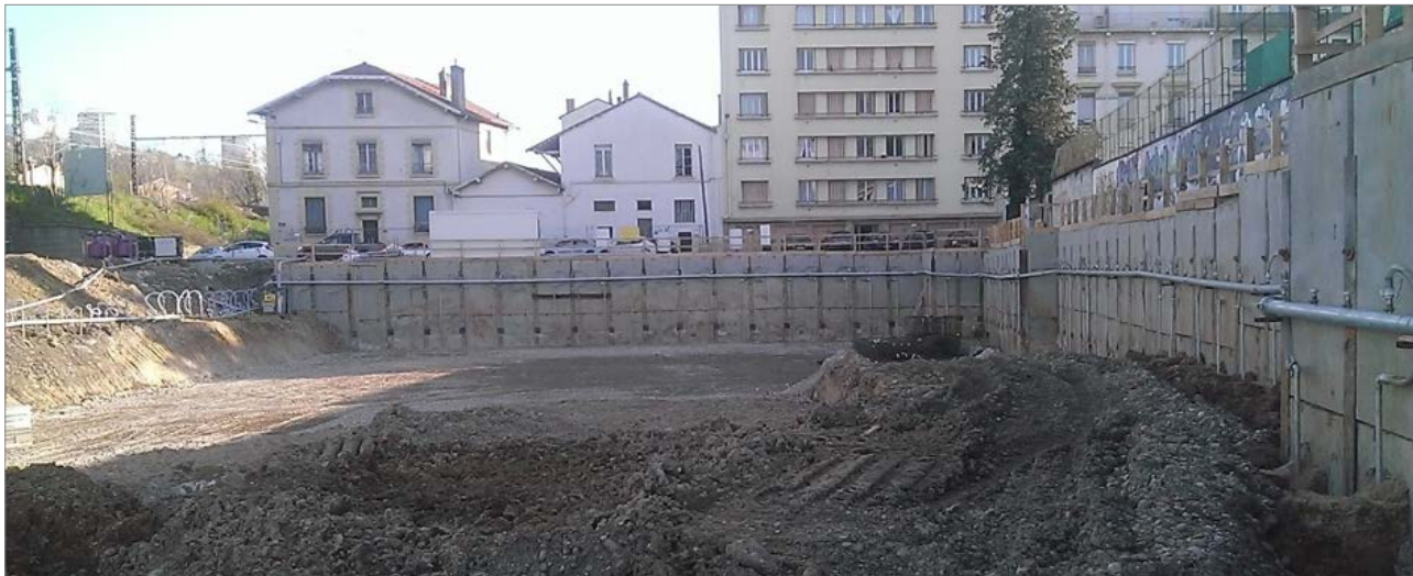
Photographie 33. Pointes filtrantes sur un rang pour un chantier de rabattement / A. Parrot
