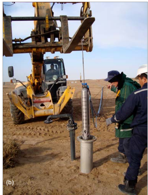
Photographie 26. Pompes centrifuge (a) et multicellulaire (b)
