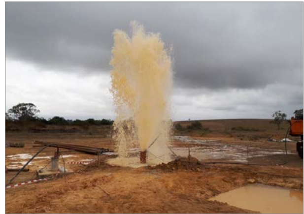
Photographie 24. Nettoyage d'un puits de pompage par air-lift simple colonne
