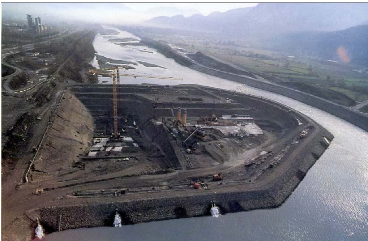
Photographie 8. Mise hors d'eau de la fouille de Saint-Égrève dans le lit de l'Isère avec écran d'étanchéité et puits de pompage / Solétanche-Bachy pour EDF
