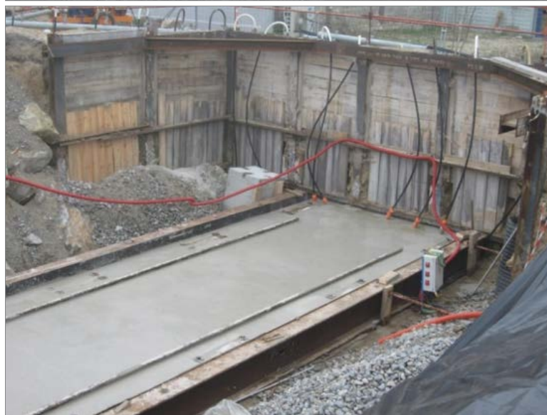
Photographie 2. Rabattement à l'aide de pointes filtrantes : (a) Région parisienne Lyon 9 / DPG Pompage - (b) La Baule / Demathieu Bard 2008
