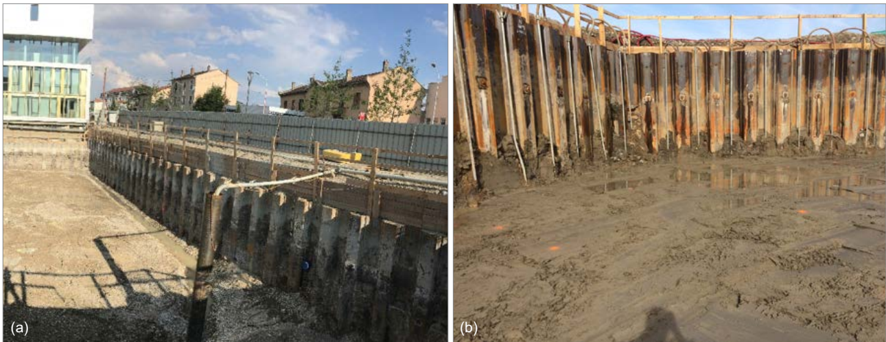
Photographie 5. Enceinte en palplanches associée à des puits de pompage à Lyon 7 (a) ou des pointes filtrantes à Annemasse / DPG pompage (b)
