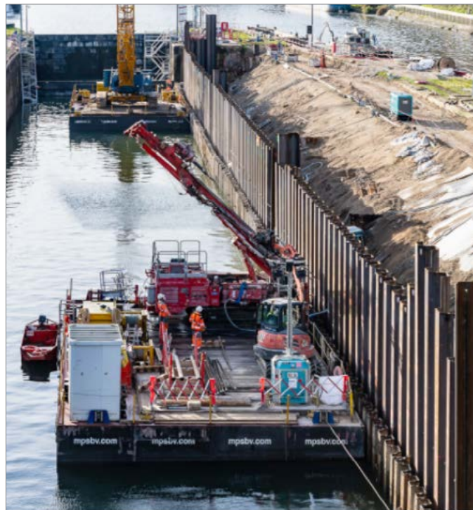
Photographie 6. Rideau de palplanche avec rabattement provisoire à l'arrière pour permettre la mise en œuvre des tirants de l'écluse de Méricourt / Cédric Helsly
