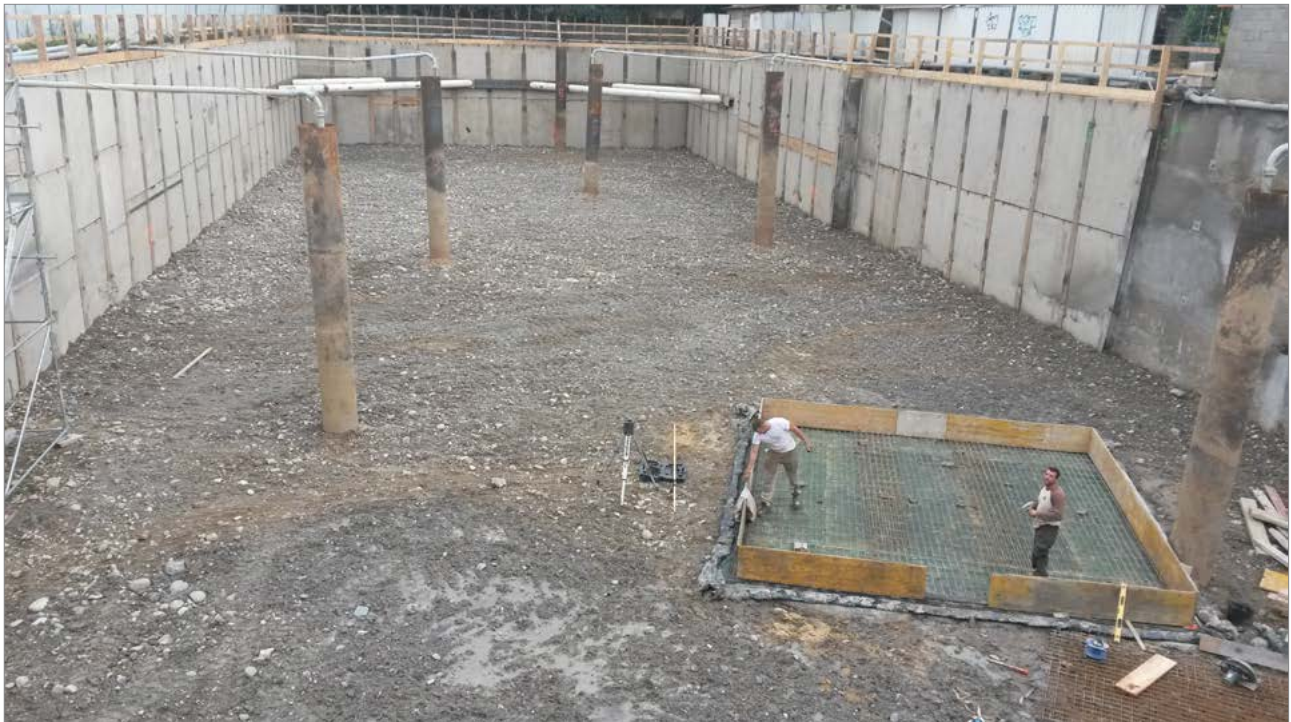
Photographie 3. Rabattement par puits à Ville La Grand / DPG Pompage
