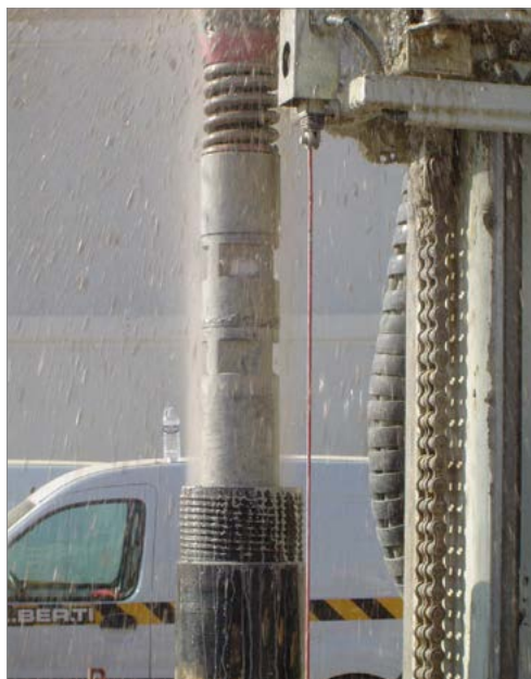
Photographie 17. Forage avec tubage à l'avancement
