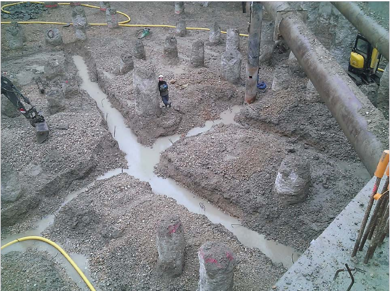
Photographie 1. Tranchées drainantes de faible profondeur / A. Parrot
