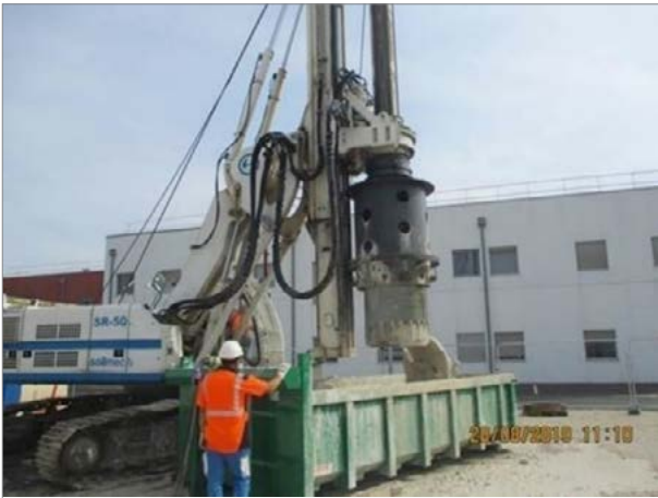
Photographie 19. Machine de forage pour un puits de rabattement en gros diamètre
