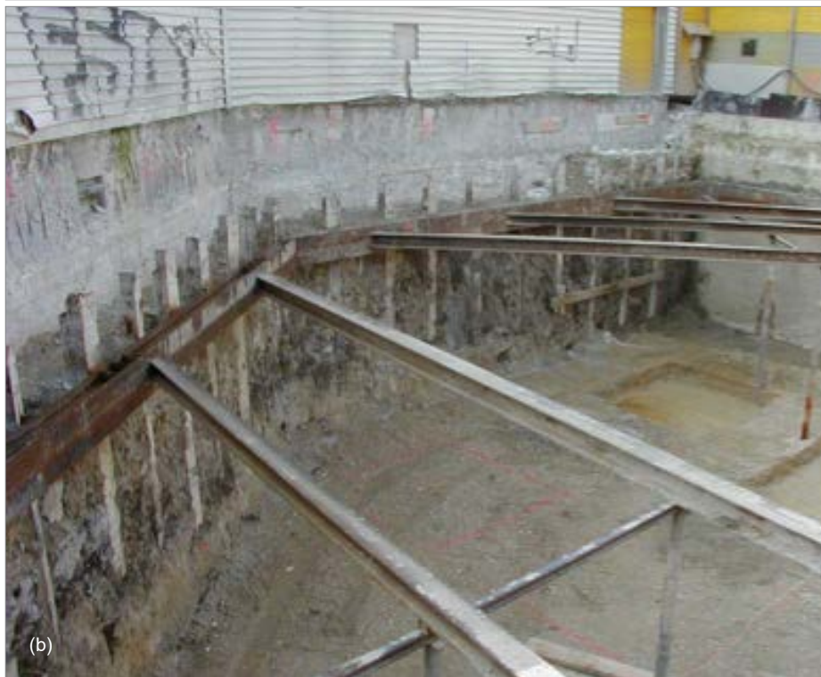
Photographie 10. Colonnes en jet-grouting avant recépage (a) et l'enceinte une fois terminée (b)
