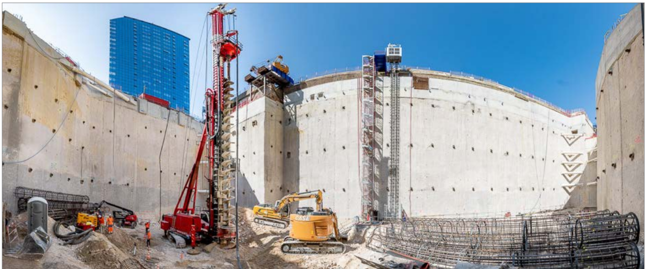
Photographie 7. Enceinte à l'aide d'une paroi moulée tirantée / Cédric Helsly
