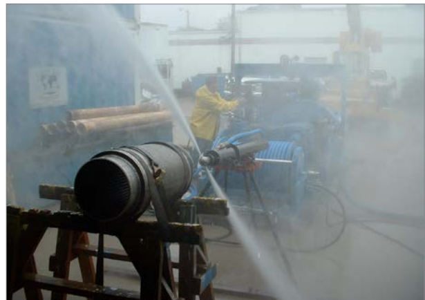
Photographie 25. Outil de jetting pour le développement des puits
