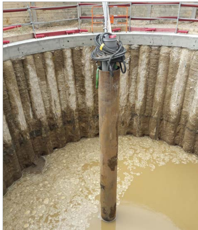
Photographie 9. Enceinte à l'aide de pieux sécants associée à un puits de pompage / EDF
