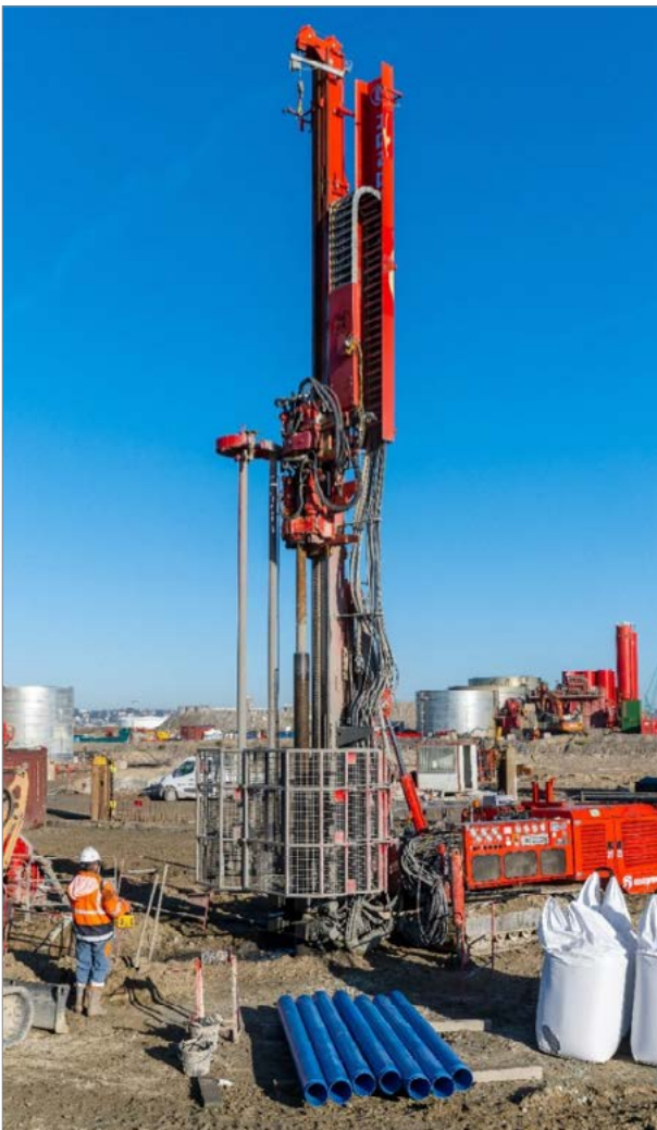
Photographie 20. Atelier de forage : foreuse, tube crépiné et gravier filtre / Cédric Helsly
