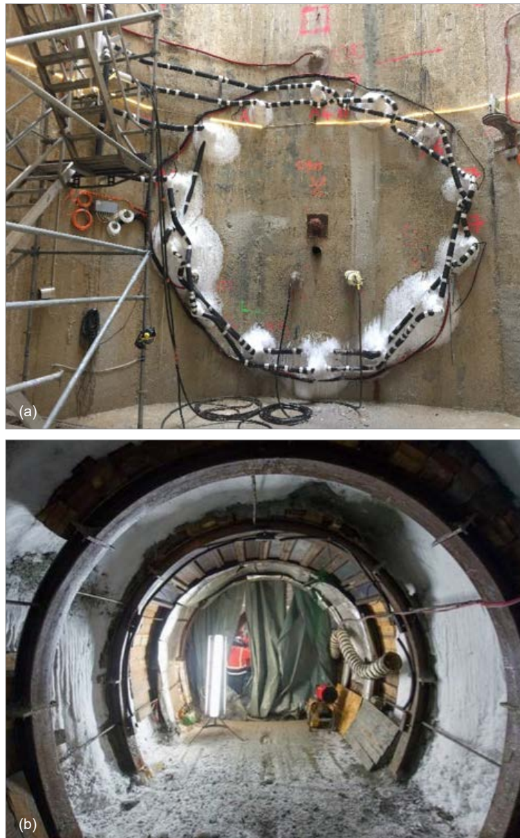
Photographie 13. Exemple de congélation des sables de Beauchamp pour excavation d'une galerie avant (a) et après creusement (b) / Solétanche-Bachy
