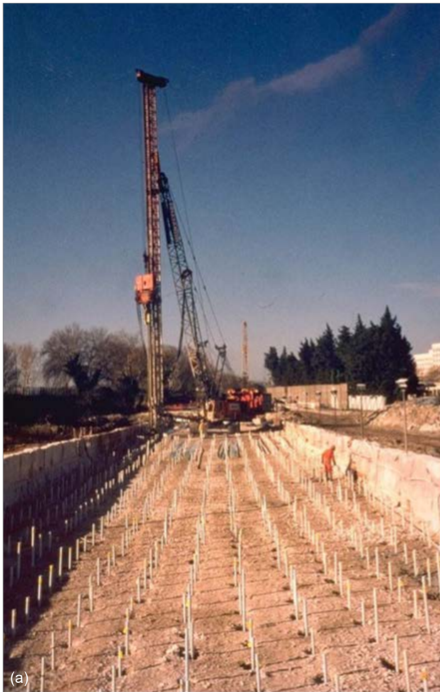
Photographie 12. Chantier d'injections de confinement pour pompage en nappe : fond injecté pour tranchée TGV à Avignon (a), et étanchéification à Fukushima (b) et (c)
