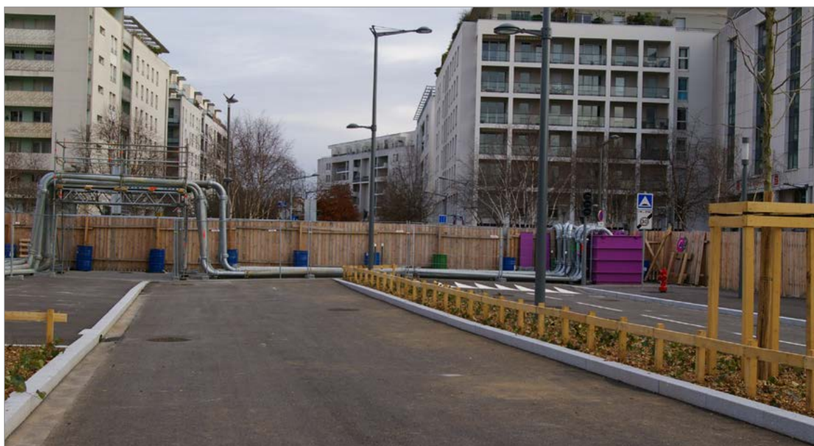
Photographie 28. Installation de chantier d'exhaure avec bacs et canalisations / A. Parrot
