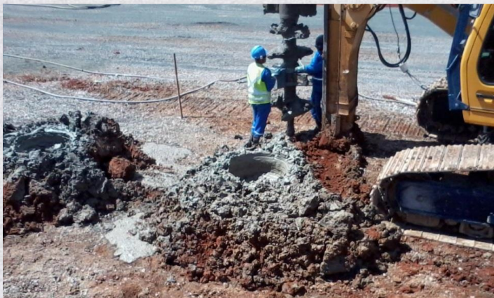
(a) Etape finale de l'exécution d'une colonne DSM
