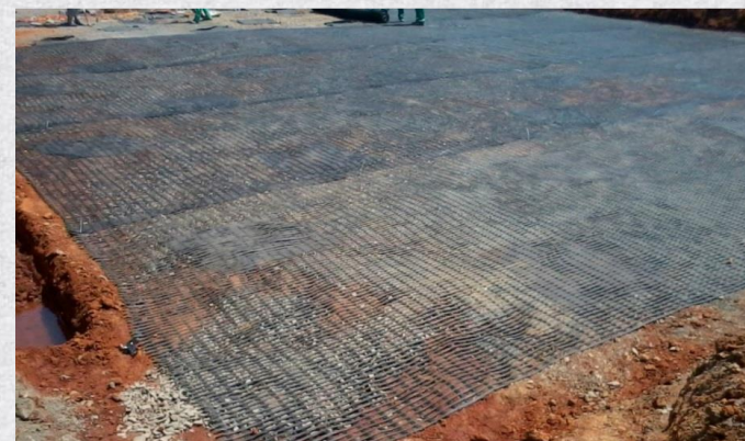
(d) Mise en place de la géogrille
