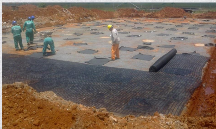
(c) Installation de géogrilles (avec une protection de géotextiles au niveau des colonnes)
