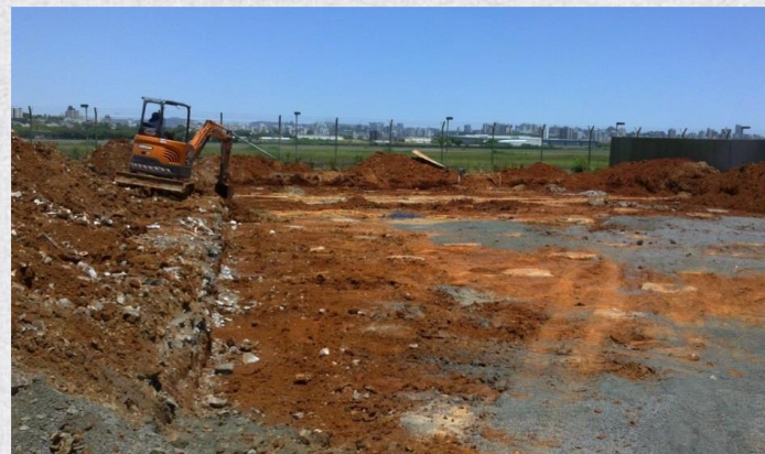
(b) Nettoyage après la mise en place des colonnes
