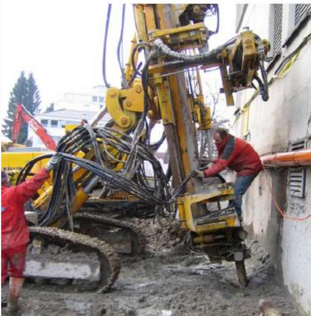
Vérification de l'étanchéité par injection d'air
