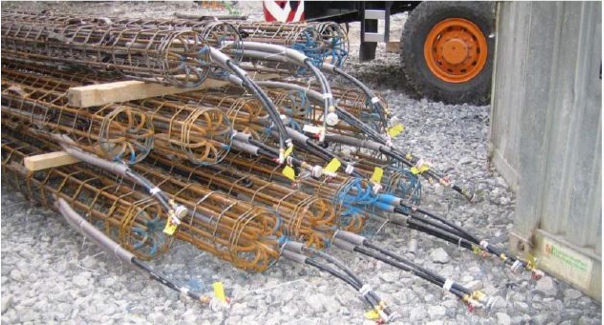
Armatures équipées de sondes thermiques
