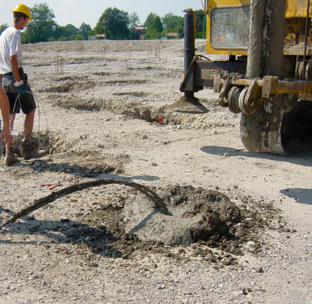
Mise en place d'une cage de 2 m de hauteur et vérification de l'étanchéité des tubes
