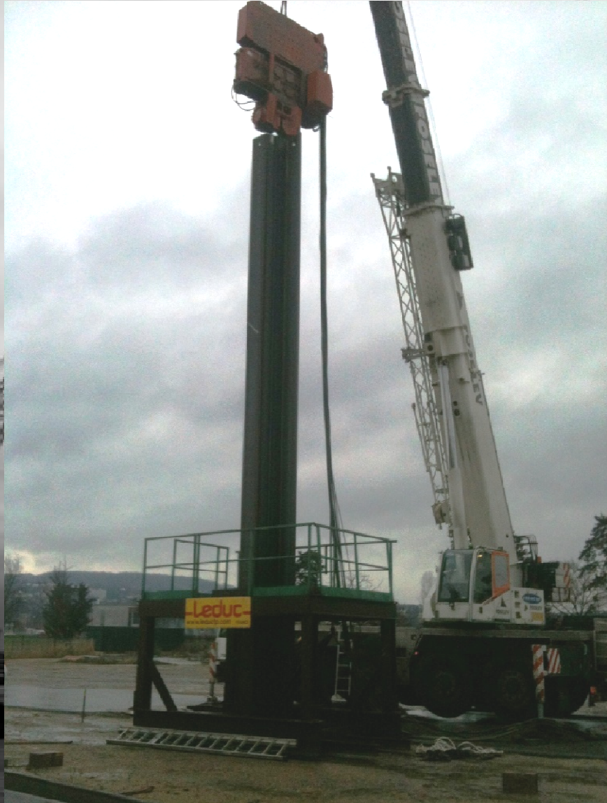
Mise en fiche et vibrofonçage
