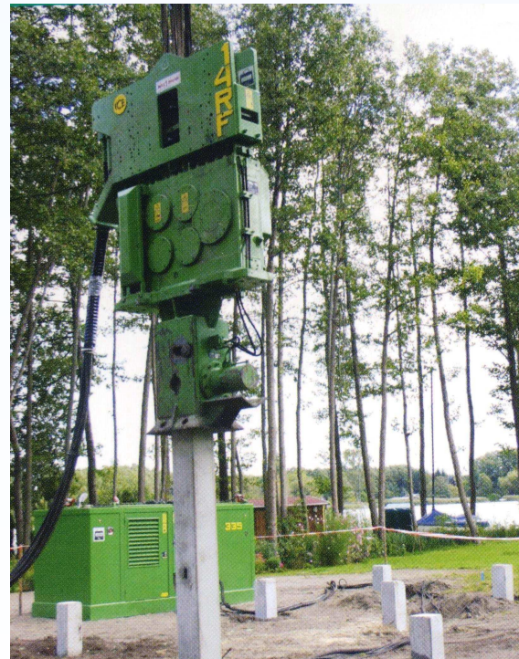
Vibrateur sur pieu en béton préfabriqué
