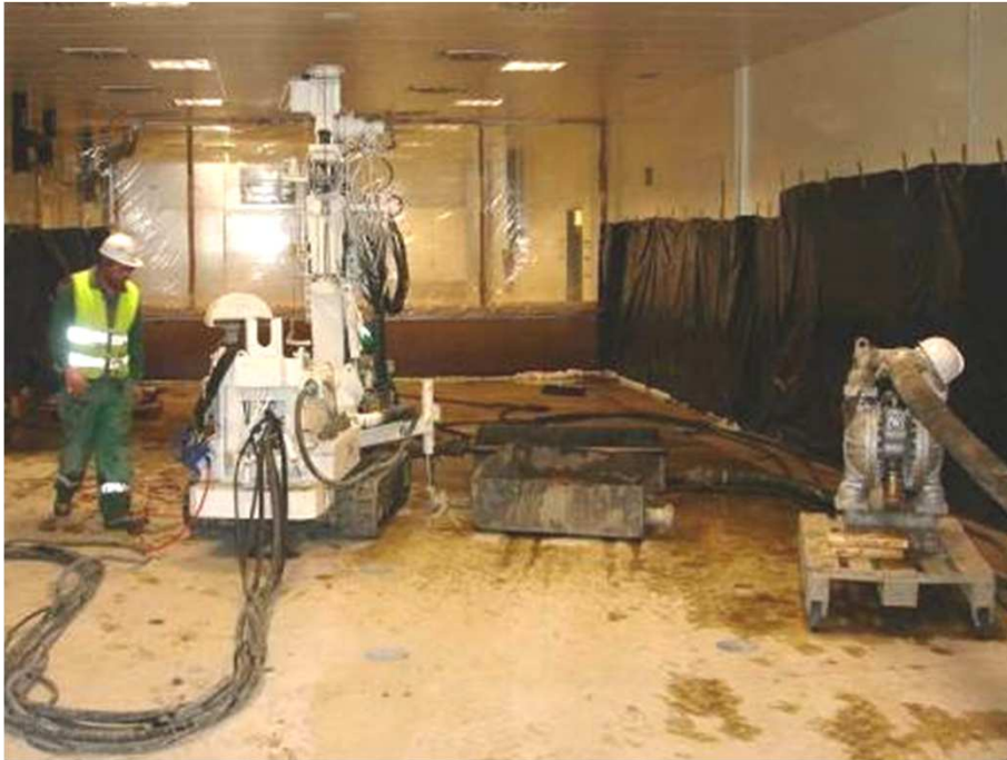
Site pendant les travaux
