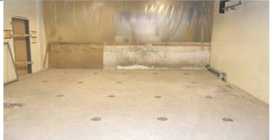
Site à la fin des travaux
