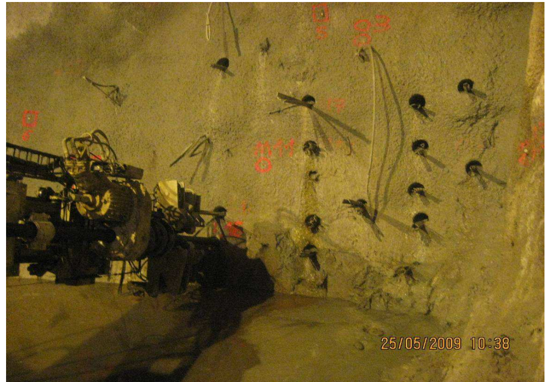
Réalisation des colonnes de Jet-grouting et des boulons au front de taille
