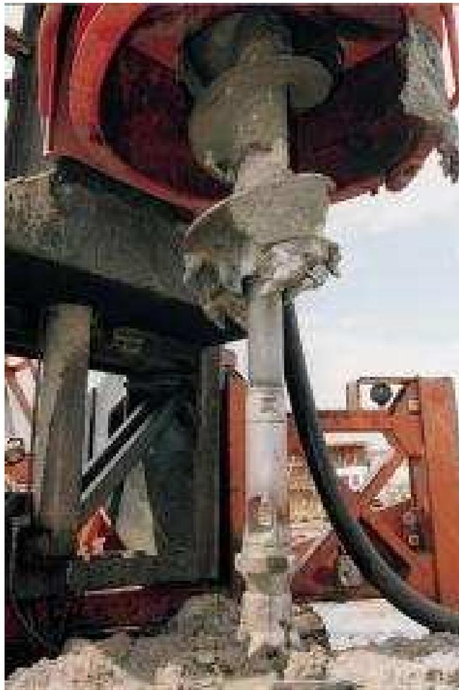
Pieu refoulé en fin de bétonnage
