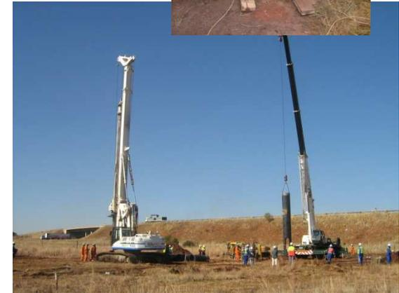
**Forages à la tarière  $\Phi$  900mm pour prélèvement d'échantillons intacts et paramètres de calcul**
