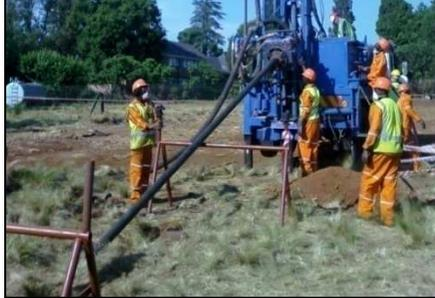
**Forages "Symetrix" avec enregistrement des paramètres**
