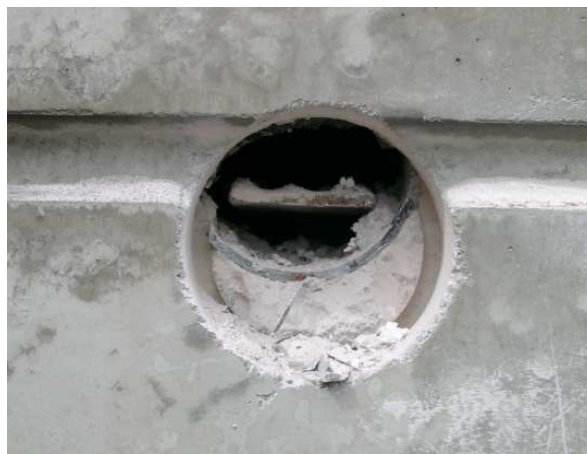
Photo 2 : Vue de l'amorce dans sa réservation
