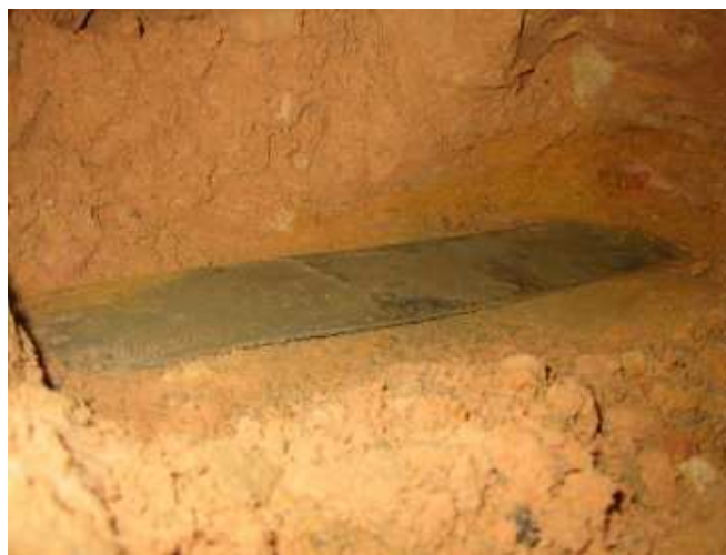
Photo 12 : Dépose de la carotte béton
