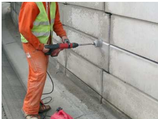
Photo 1 : Découpage de l'opercule béton à l'aide d'une scie cloche
