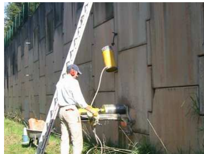
Photo 9 : Réalisation du carottage en parement
