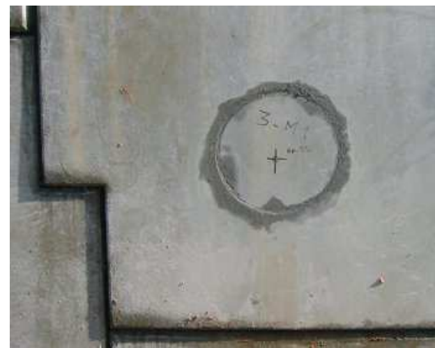
Photo 13 : Scellement de la carotte extraite
