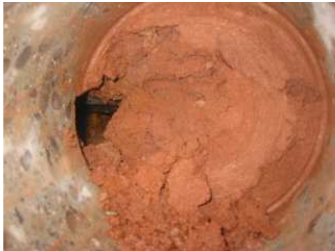
Photo 10 : Début d'extraction du remblai depuis le carottage en parement
