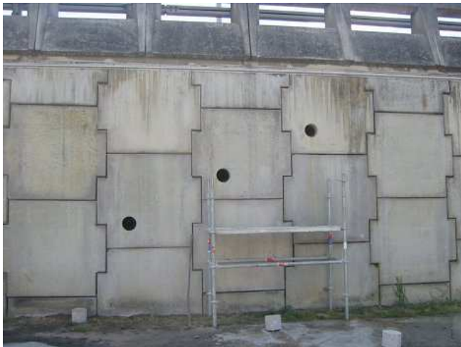
Photo 8 : Implantation des carottages en parement du mur
