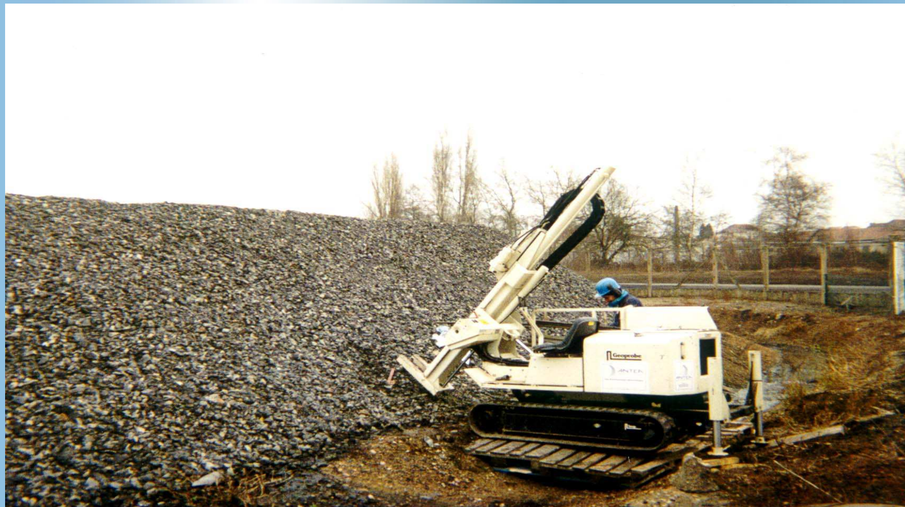
Diagnostic de remblais - sondages inclinés - Geoprobe
