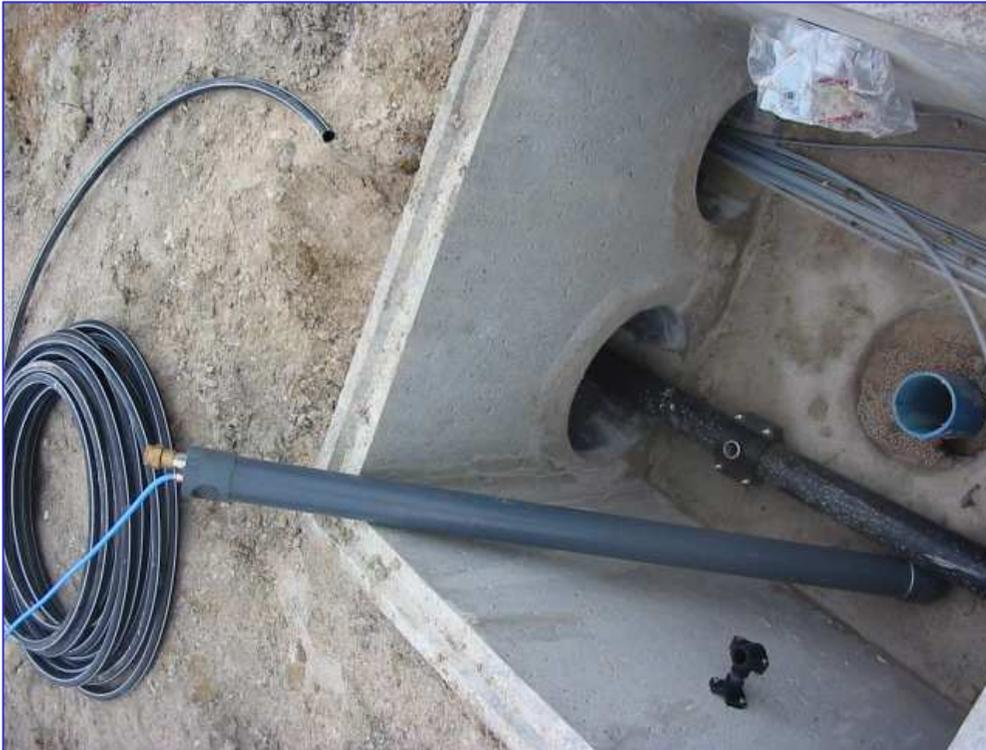
**Equipement des pompes pneumatiques dans les puits de pompage – Exutoire sur conduite forcée en PEHD DN90mm**
