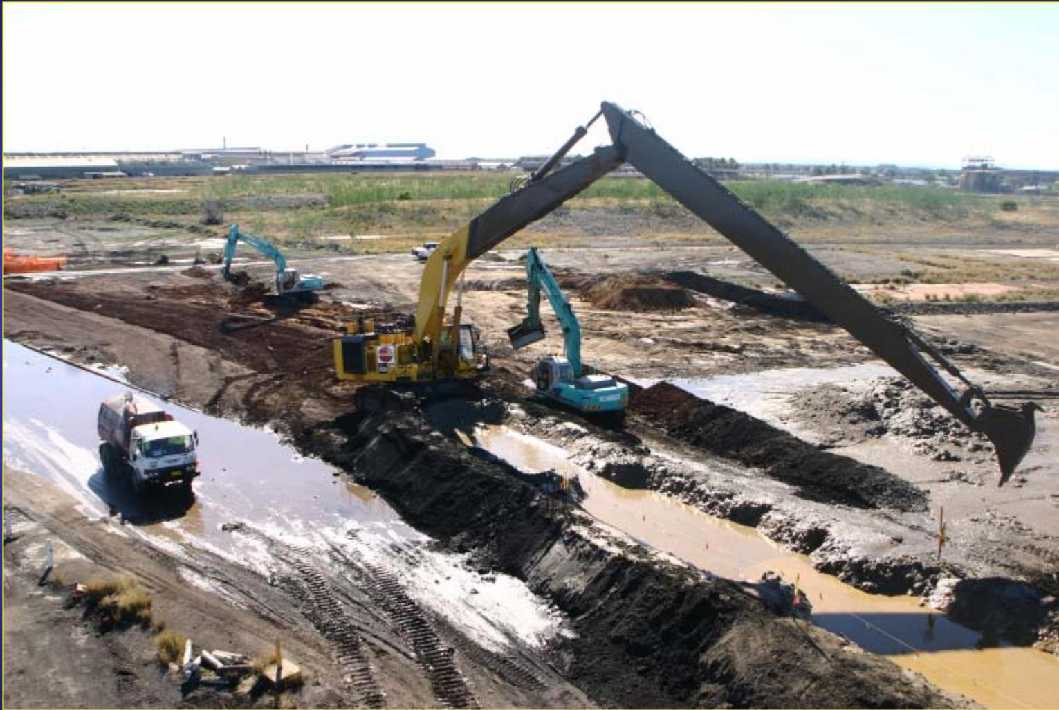
Excavation de la partie supérieure de la tranchée à la pelle au bras long
