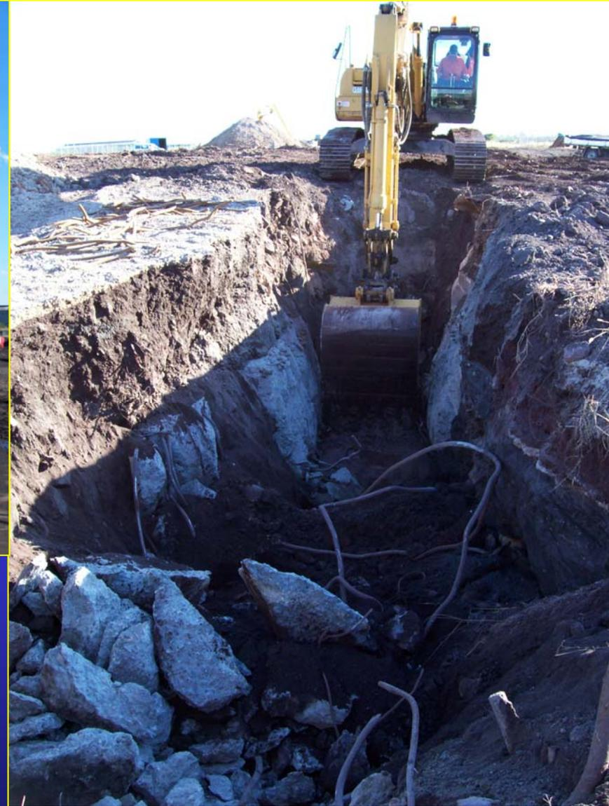
Réalisation d'une pré-tranchée pour élimination des obstacles dans le remblai de surface
