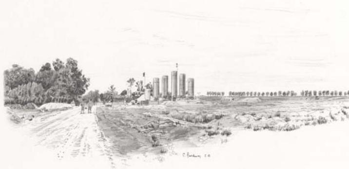
La centrale d'injection a réalisé 45 000 m<sup>3</sup> de cauxis pour alimenter 300 forages – certains jusqu'à 50 m de profondeur – pour combler, en 8 mois, les galeries d'anciennes carrières de gypse. À l'horizon, le réseau d'arbres bordant l'A10 et la D456A.
