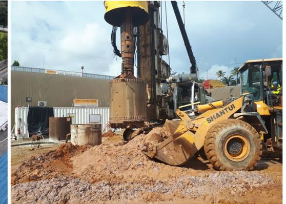
Fig. 12 : Forage des pieux d'essai
