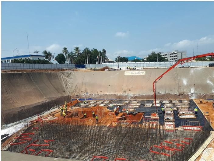
Fig. 24 : Travaux de coffrage / ferrailage du radier par Besix
