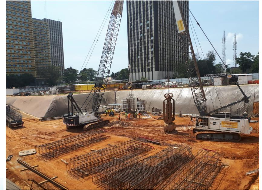
Fig. 23 : Réalisation des travaux de barrettes par Spie batignolles fondations
