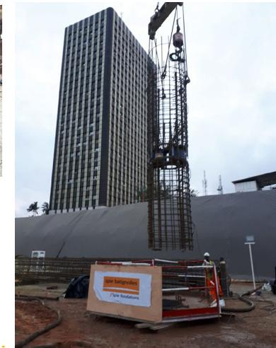
Fig. 14 : Mise en place de la cage d'armature
