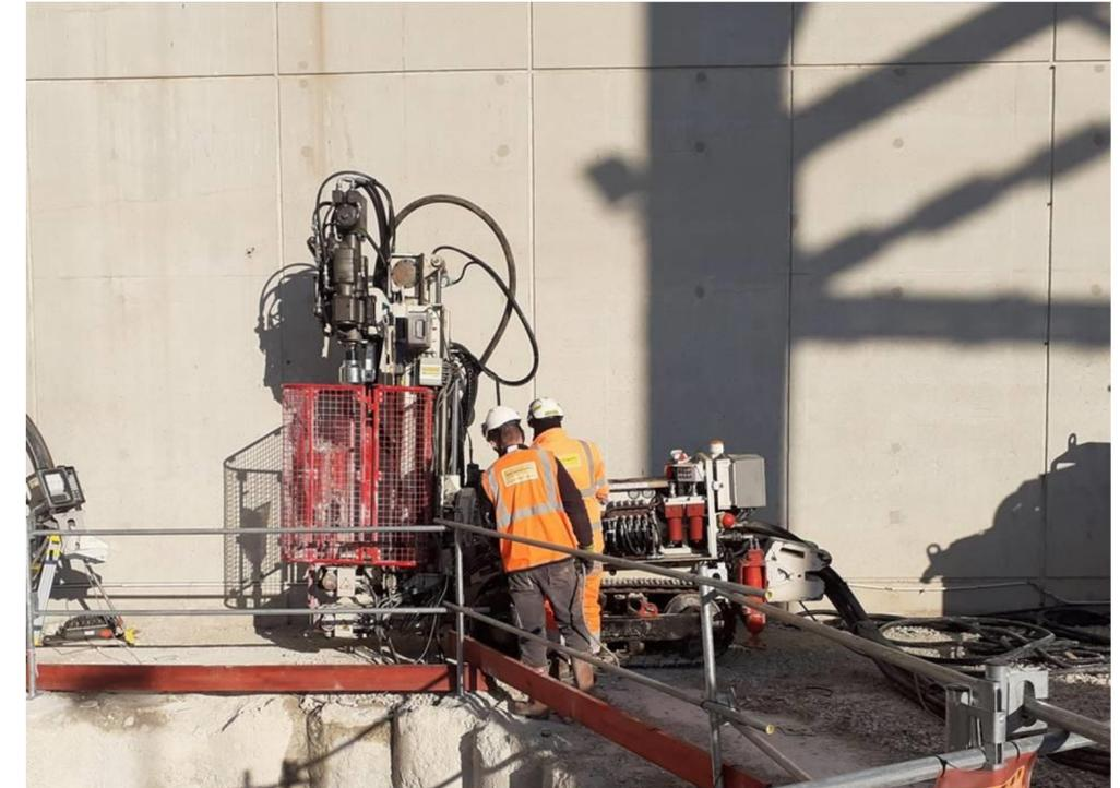
→ La réflexion sur la nécessité ou non d'utiliser un système de tubage influence le choix de la technique de forage
