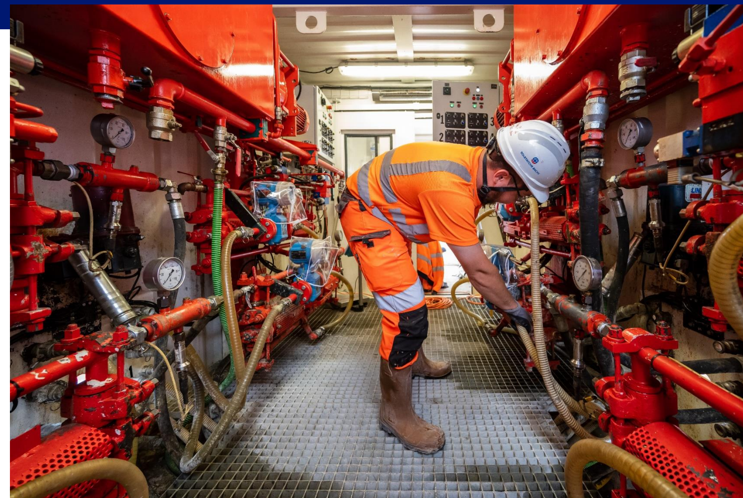
Mise en œuvre par des moyens usuels d'injection (TAM) et contrôles pressiométriques
