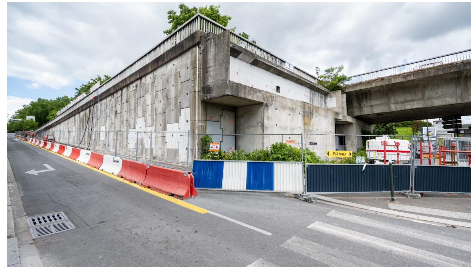
Remblai granulaire associé à des armatures métalliques et un système de parement modulaire
