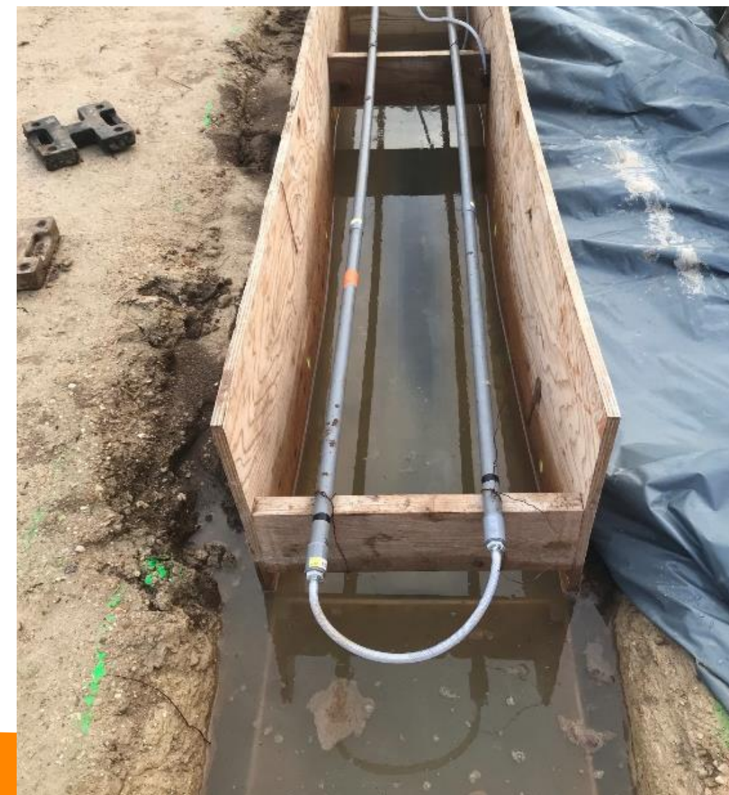
Essais d'épandage P \sim 60\text{ cm} (application enfouissement de câbles électriques)
