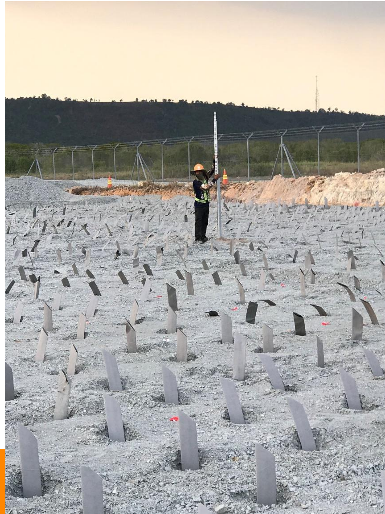
Suivi des tassements de la plate-forme de travail
