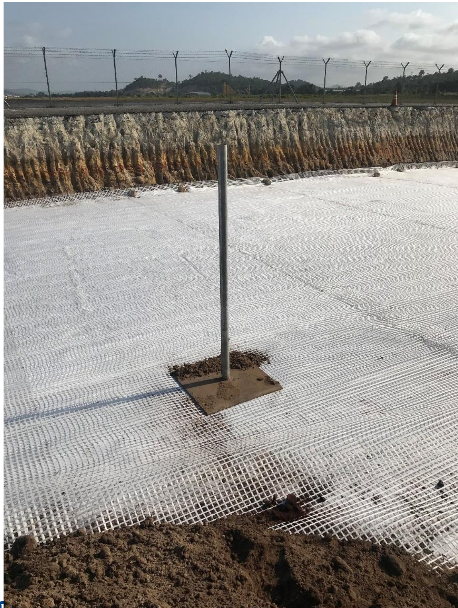
Suivi des tassements de la plate-forme de travail
