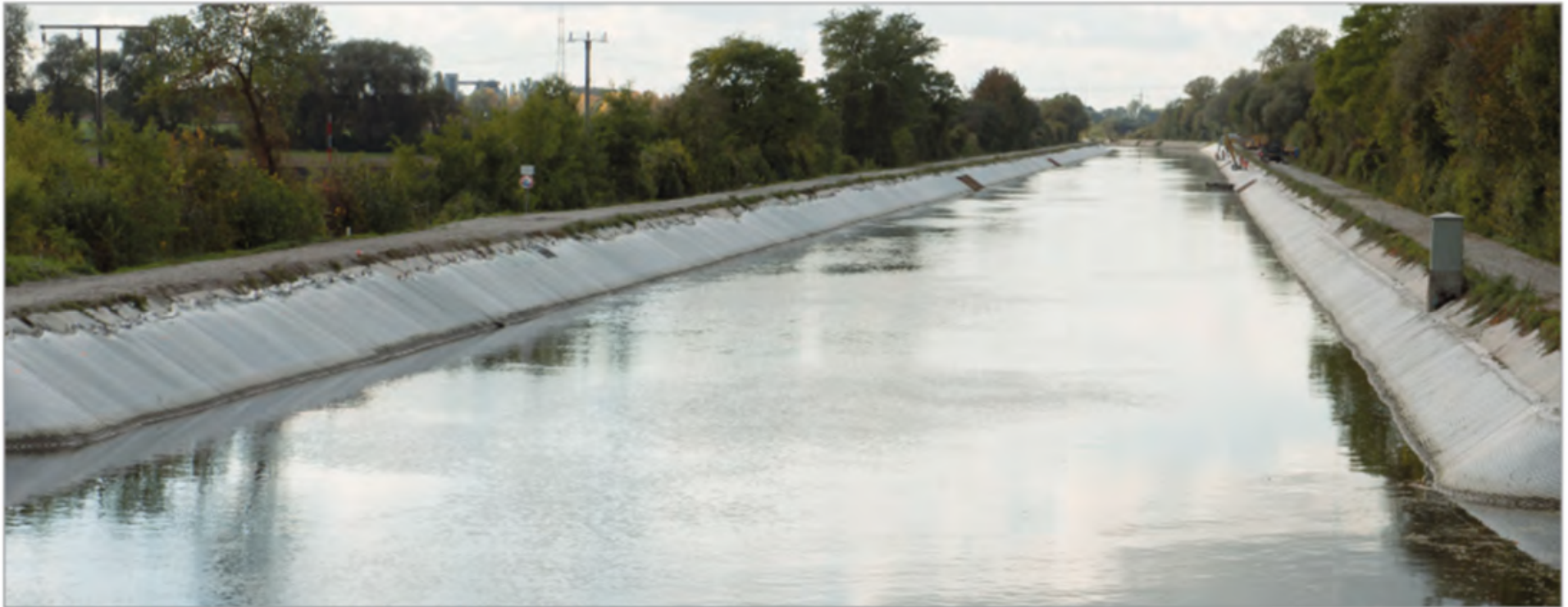
Le bief 4a du canal du Moyen-Isar à l'issue de la réhabilitation
