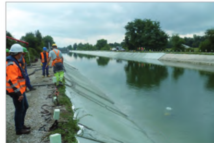
Remplissage des sections de talus
