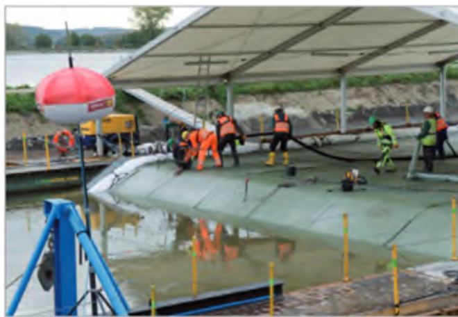
Mise en œuvre de l'étanchéité du fond du canal depuis le ponton
