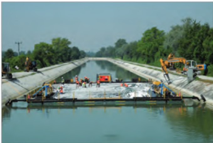
Ponton de pose sur le canal du Moyen-Isar
