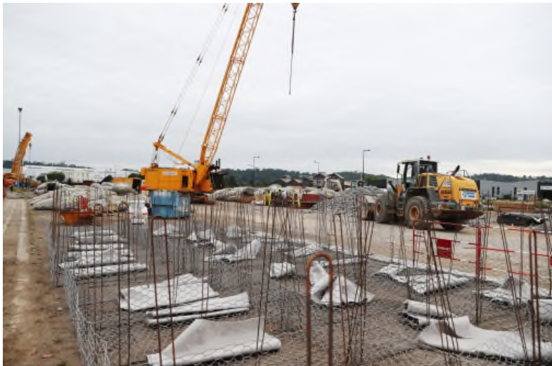
Préfabrication des cages sur le terre-plein (cellules unitaires de 6 x 2m)
