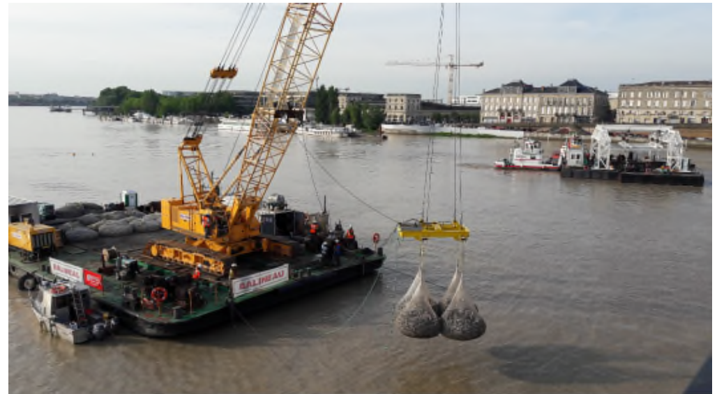
Pose d'un palonnier avec 4 filets de 4t
