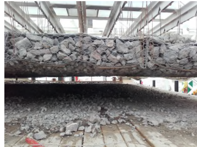
Levage gabion dans les doigts du palonnier (234 élingues, soit # 0,5t/élingues)
