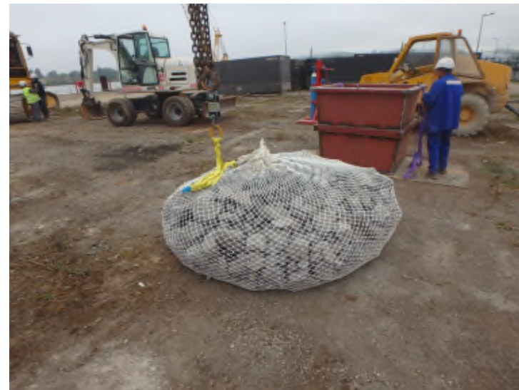
Filet de 4 t (matériau 40/200 mm)
