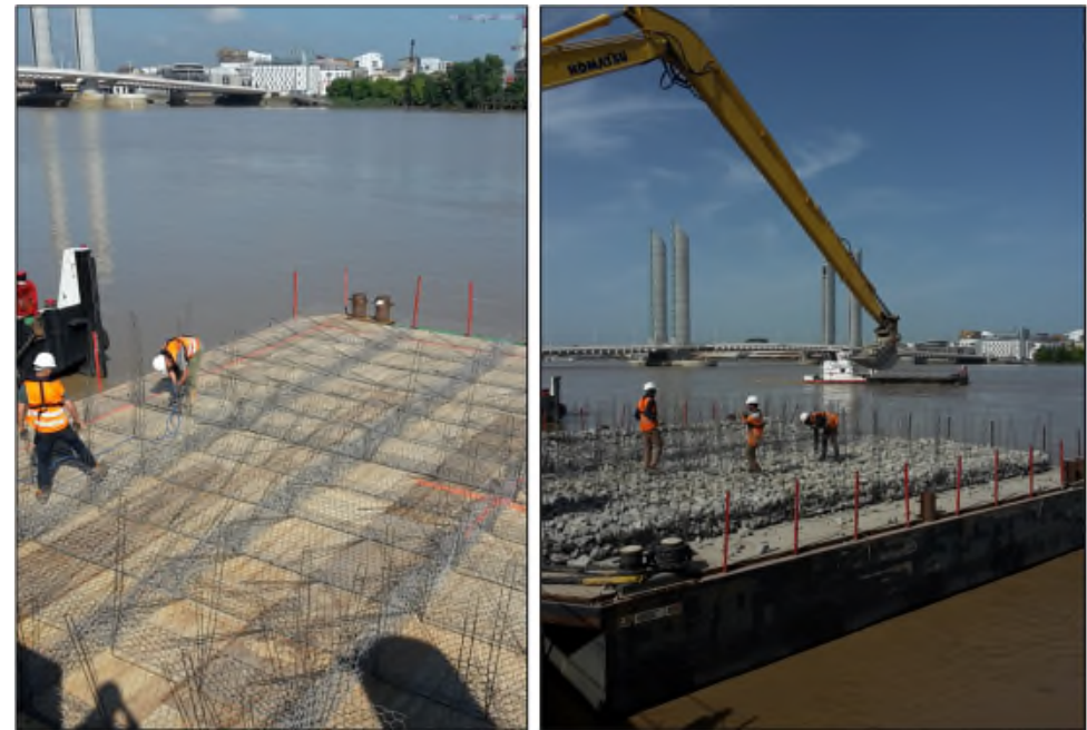
Assemblage et remplissages des cages (90/180 mm) sur ponton de servitude
