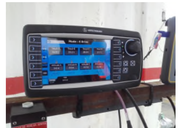
Mesure masse sur chacun des treuils
