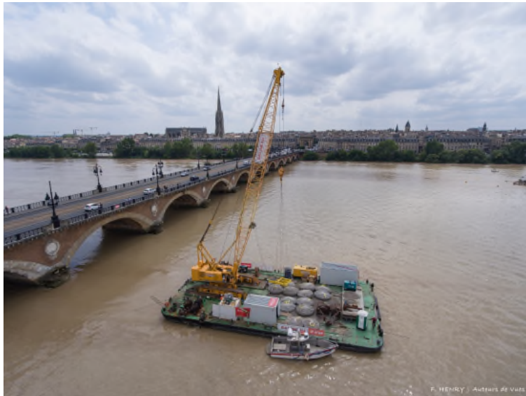
Atelier de pose des filets (ponton Tramex)
