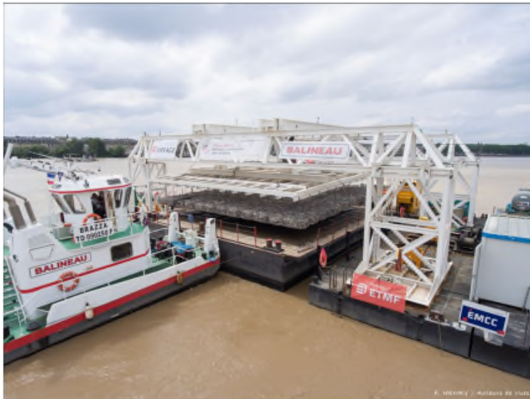
Amenée du gabion au ponton de pose
