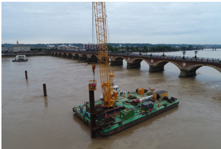
Battage de pieux zone hydrolienne
