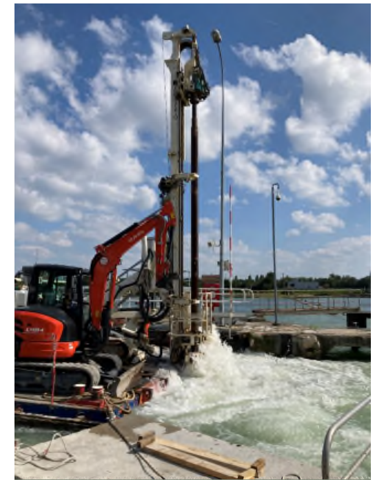
Puits de décompression
