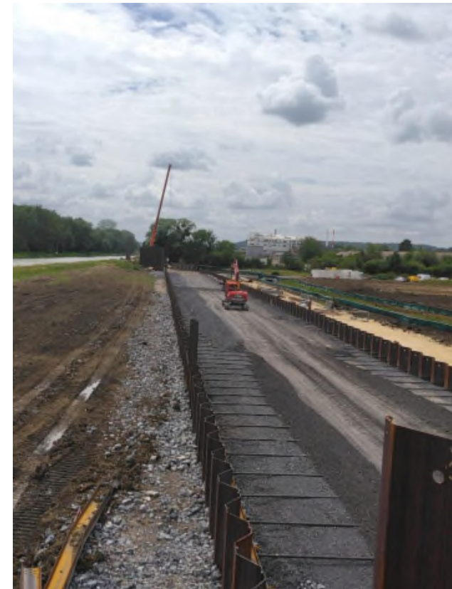
➡ Remblais sur tirants
