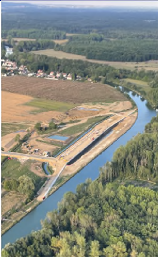
Terrassements et pompage pour la pose des défenses
