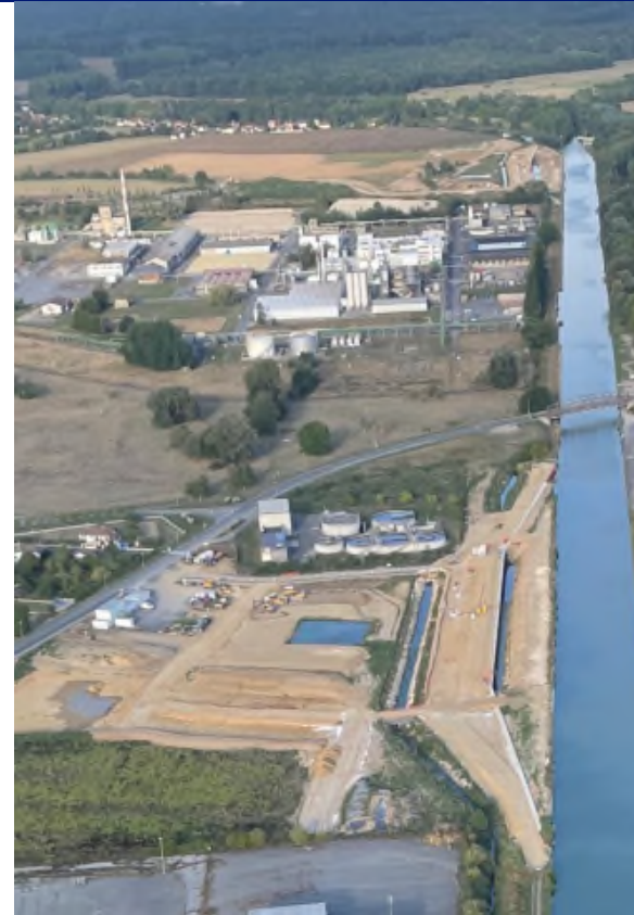
Terrassements et pompage pour la pose des défenses
