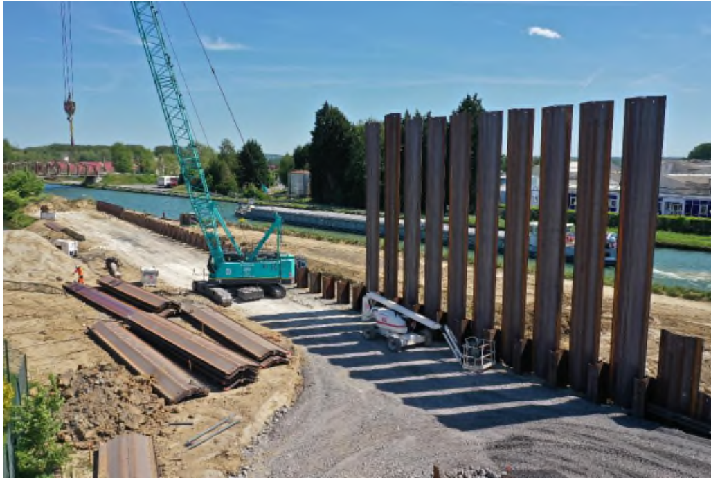
➤ Enclenchement des palplanches intercalaires des H2M
