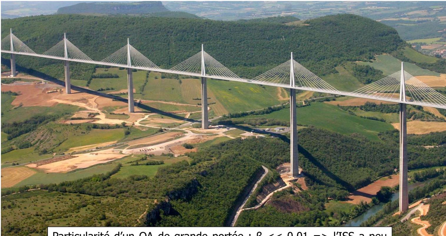
Particularité d'un OA de grande portée :  $\beta \ll 0,01 \Rightarrow$  l'ISS a peu d'incidence sur le comportement l'ouvrage sous charge verticale
