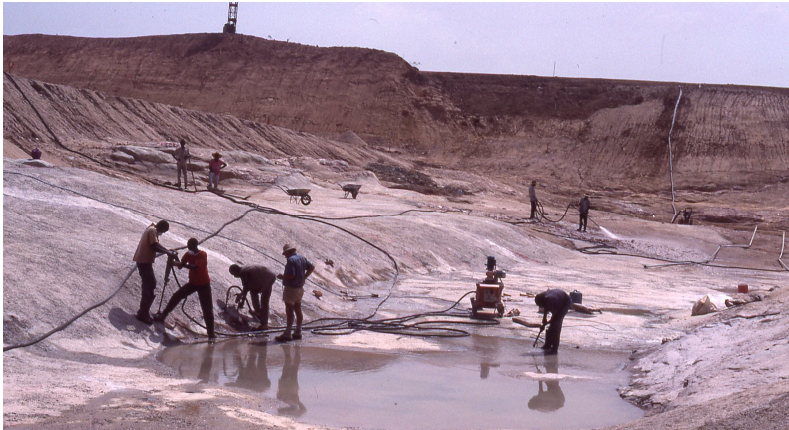
1- Purge des alluvions et préparation rocher en fondation du noyau
