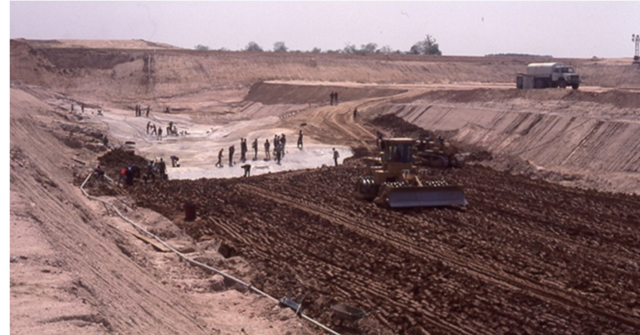
2- Construction partie basse sous 208
