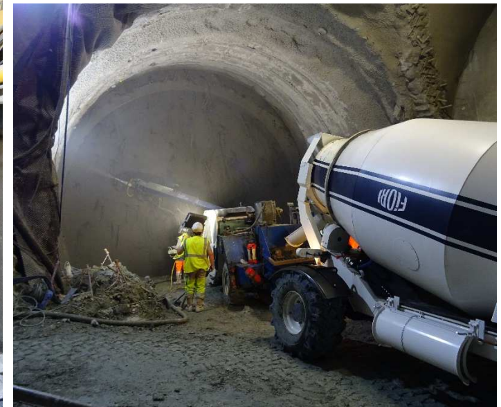
Béton projeté de remplissage
