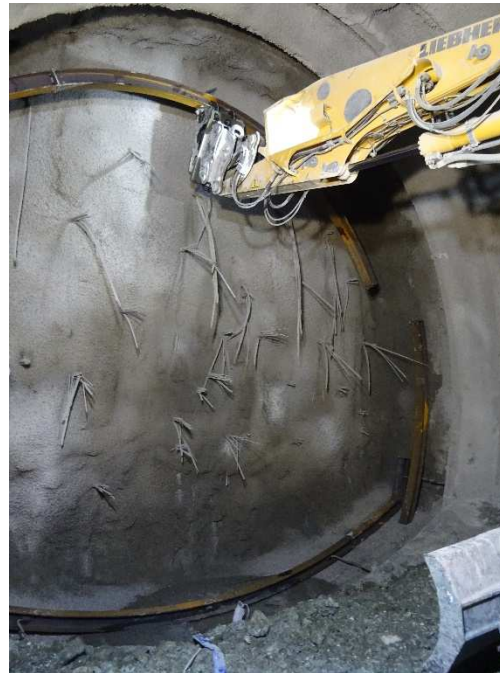
Pose du cintre
