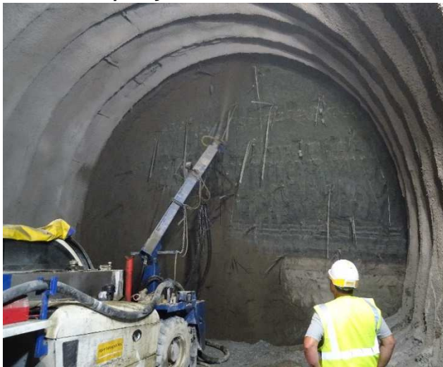
Béton projeté de confinement
