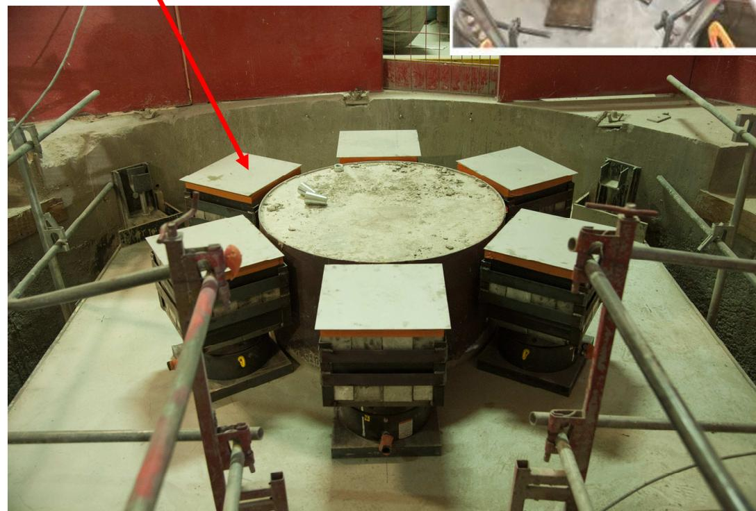
Ferrailage des têtes de poteau et pose des vérins
