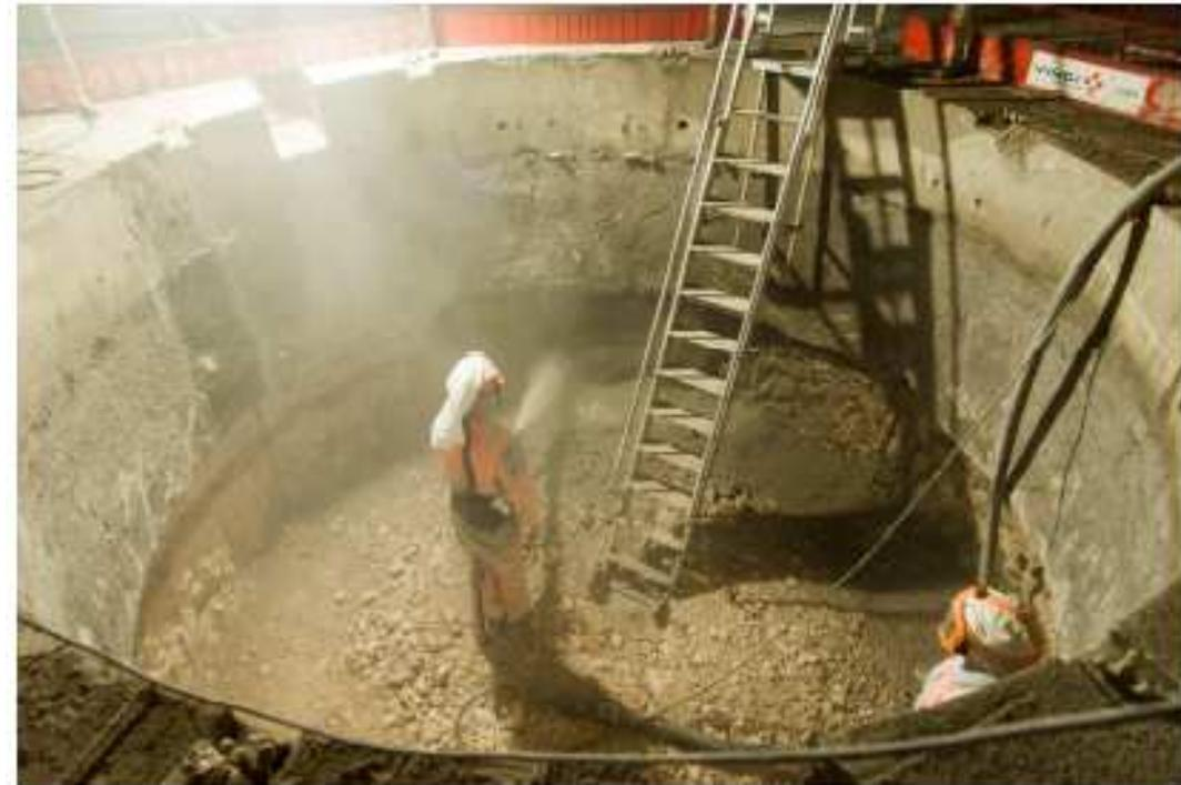
Terrassement et réalisation du blindage en béton projeté
