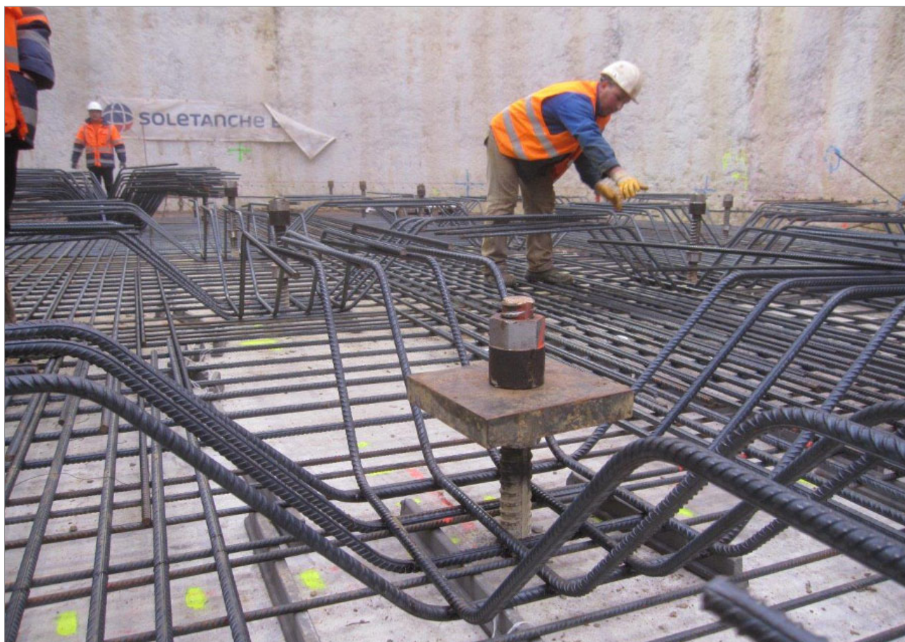
Figure 18 : Micropieux d'ancrage d'un bassin (© Soletanche Bachy)
