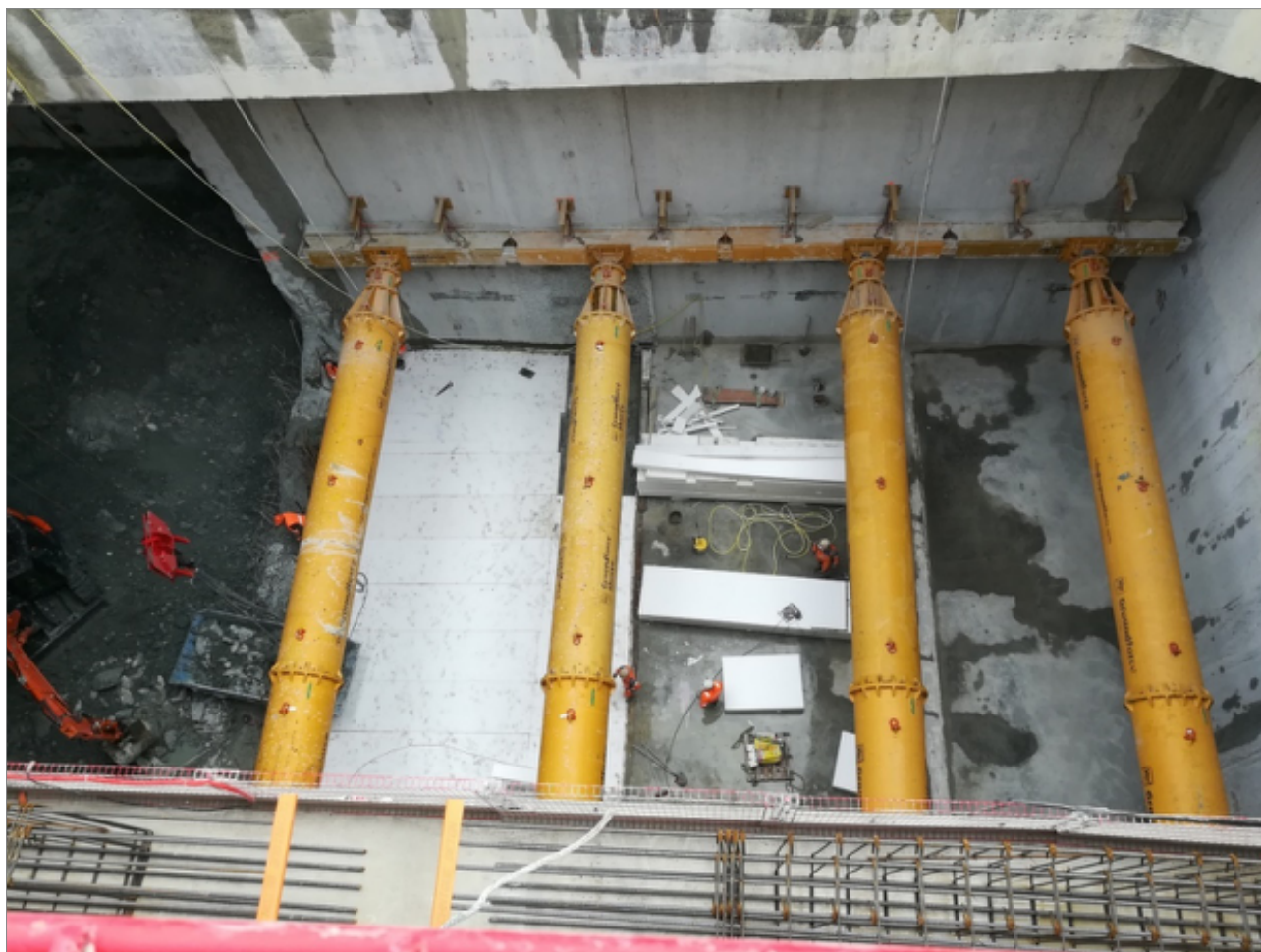
Figure 23 : Mise en œuvre des blocs de polystyrène sur l'OA 0802P (© GPE)
