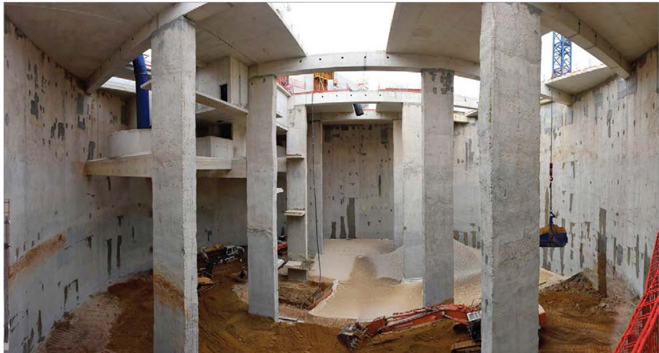
Figure 17 : Radier du bassin Ganay avec clavage tardif (© Soletanche Bachy)
