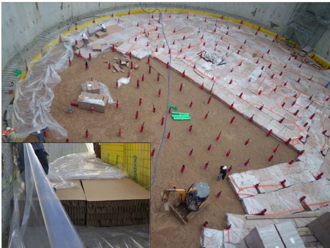
Figure 19 : Mise en place d'un coffrage dégradable (© Soletanche Bachy)
