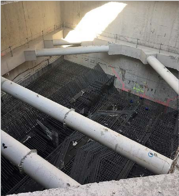
Figure 16 : Ferrailage d'un radier contre-voûté – Arrière-gare de Noisy-Champs (chantier © SGP)
