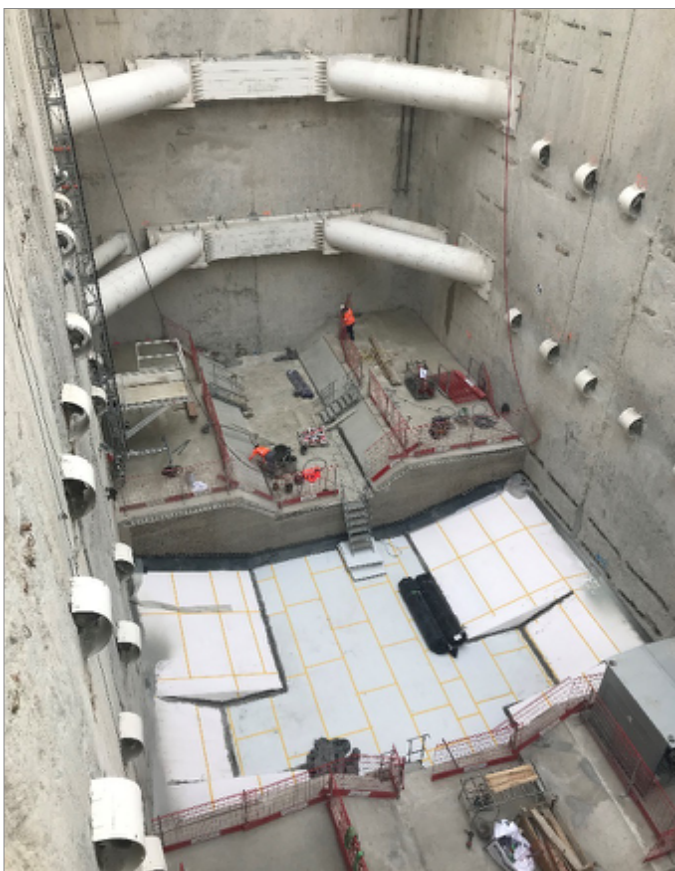
Figure 21 : Système Cellcore® (chantier OA Jean Prouvé L14 Sud GPE)
