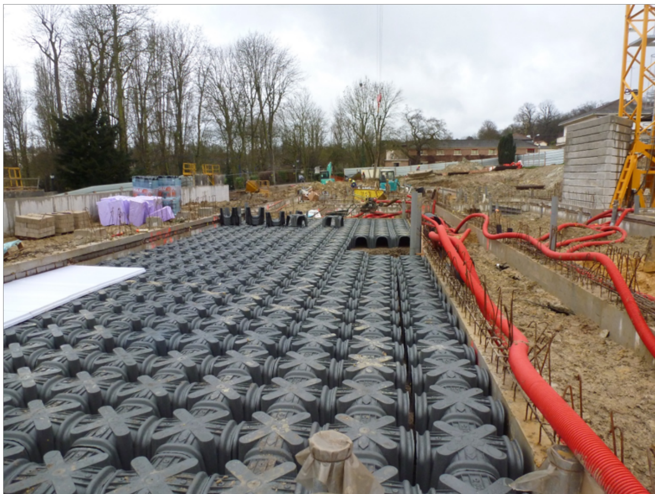
Figure 20 : Système Coffrargile IGLU® (Vide sanitaire pour une dalle portée d'immeuble dans le 92)
