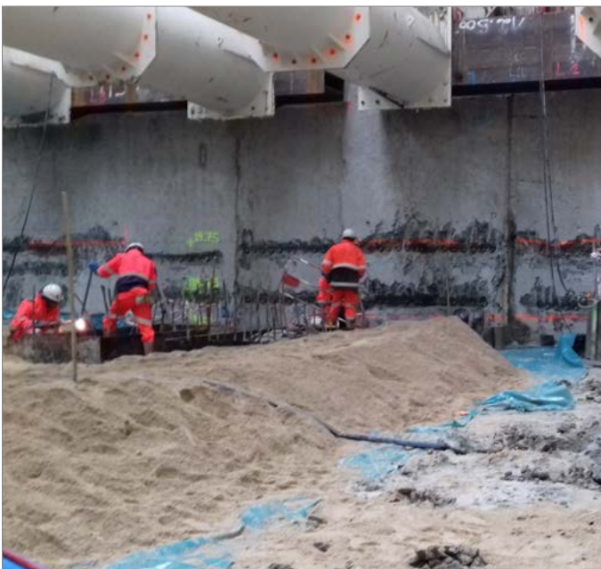
Figure 22 : Mise en place d'un lit de sable (gare Arcueil Cachan L15 sud - © GPE)
