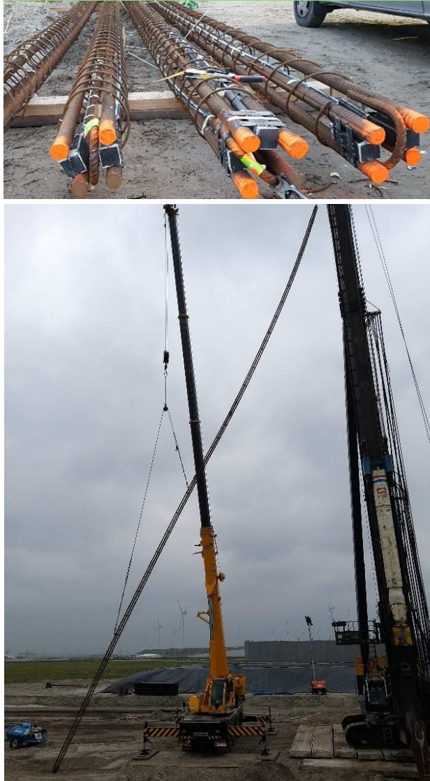
Fixée à la cage d'armature
