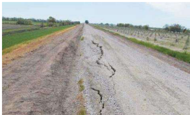
Fissures apparues le long de la crête de digue (Cerema, 2019)
