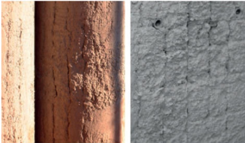
FIGURE D.5 MATELASSAGE DANS UN PIEU (A GAUCHE) ET DANS UN PANNEAU (A DROITE)
