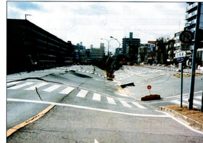
Effondrement de la route nationale au-dessus de station de métro de Daikai (Japon, 1995)
